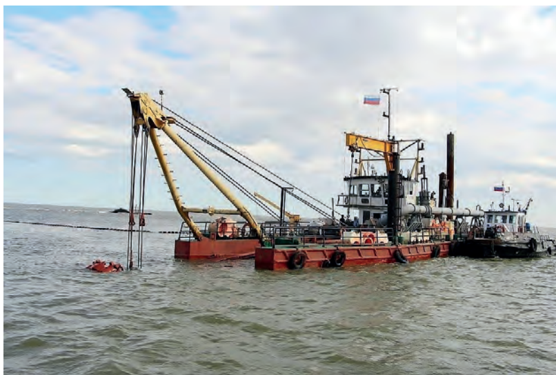
Судно для проведения работ по углублению фарватера
