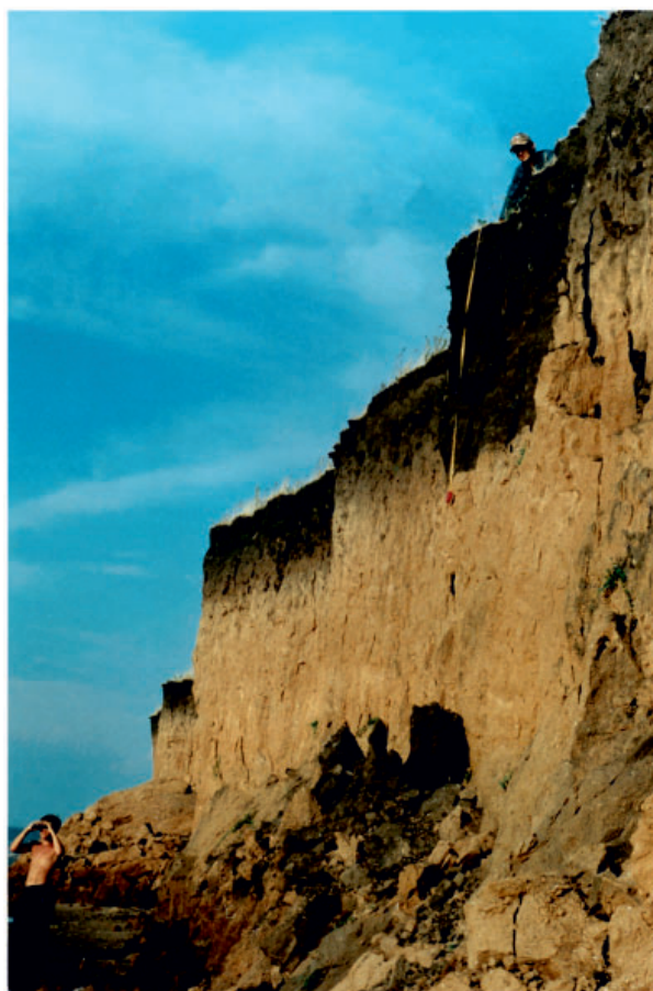
Рис. 17. Девичий городок IV, процесс разрушения клифа и обрушение погребений.
