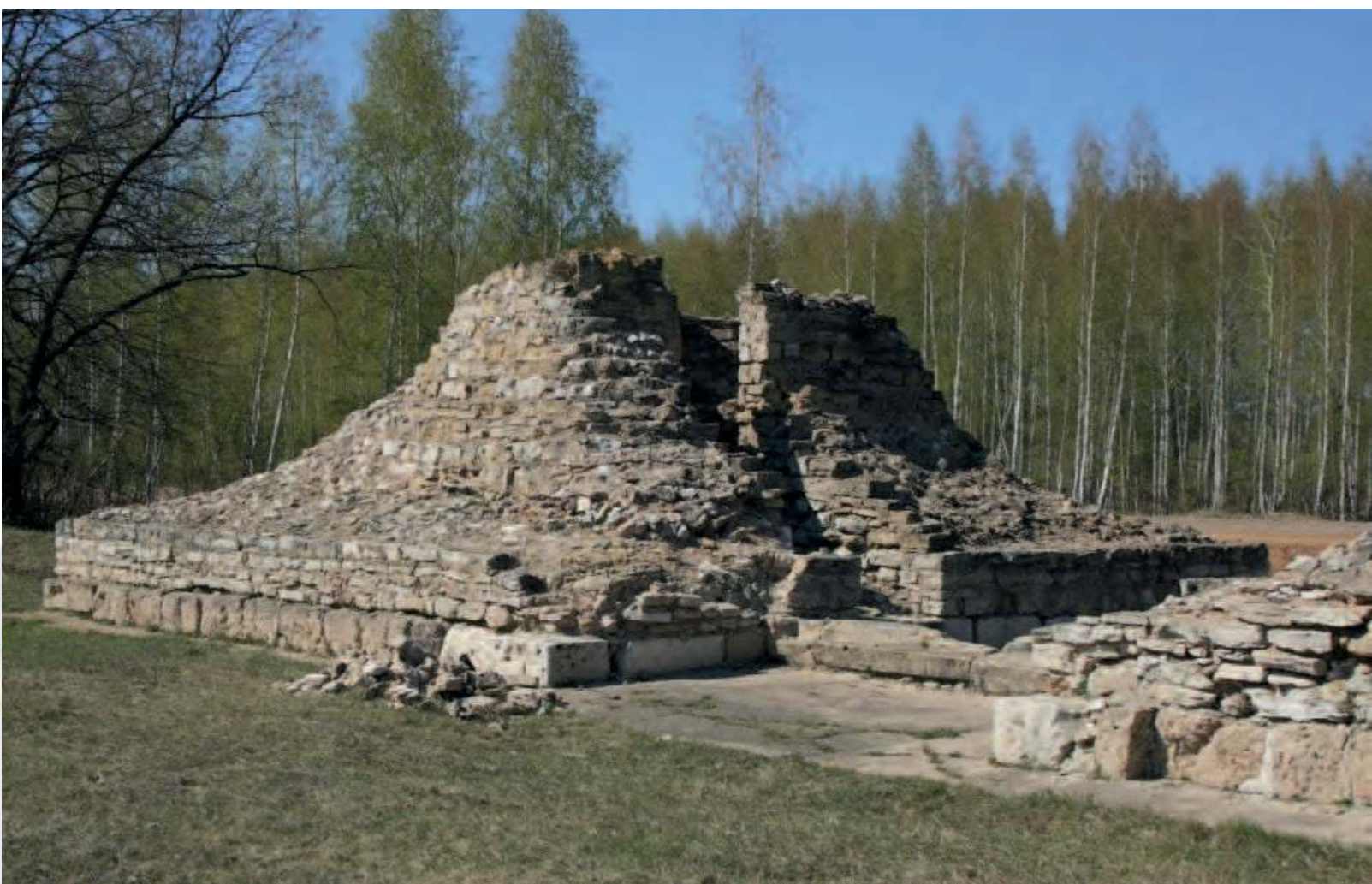
Рис. 130. Западная башня северного здания Малого городка середины XIV в.
