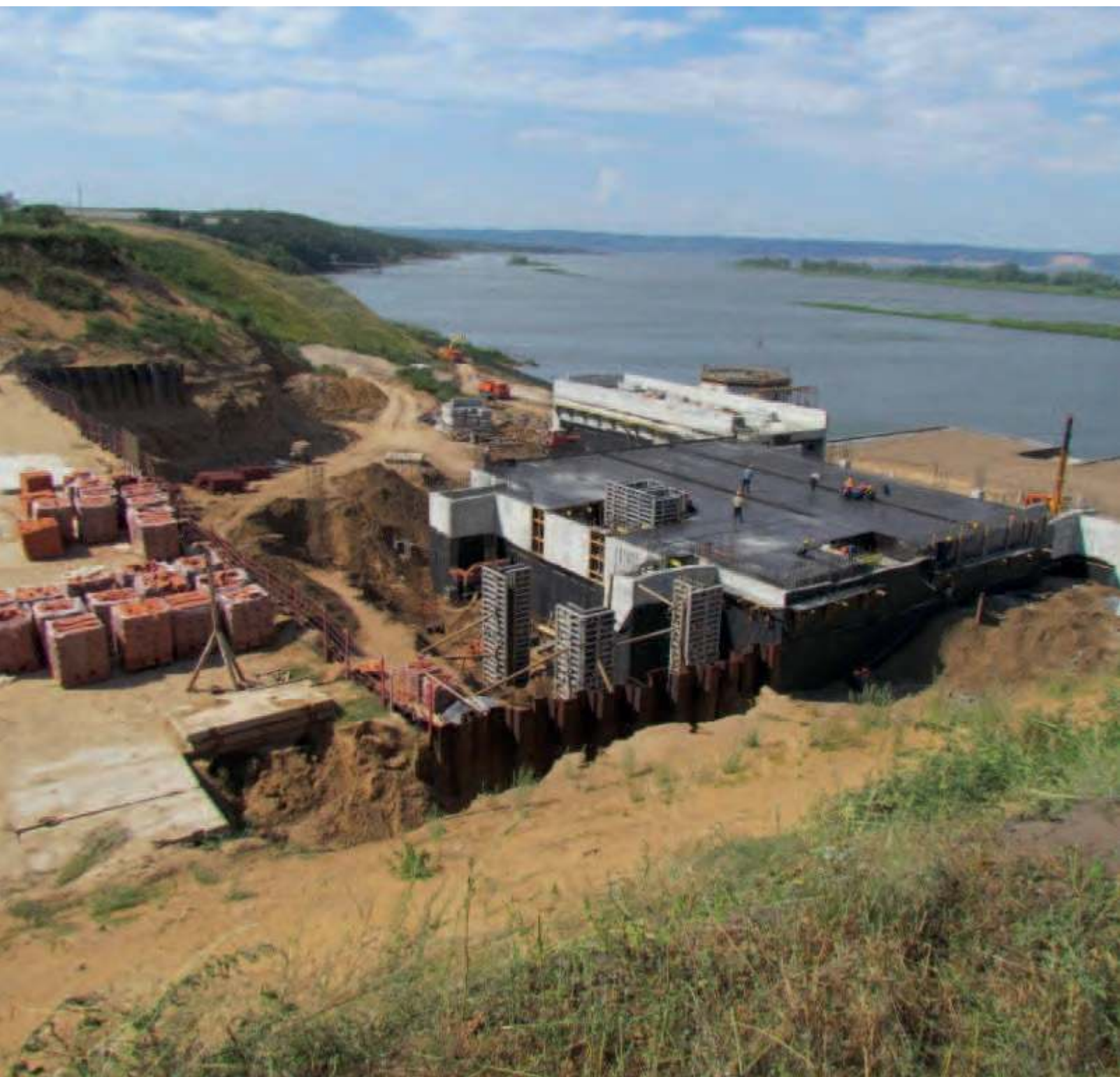
Рис. 140. Строительство речного вокзала с функцией музея.
