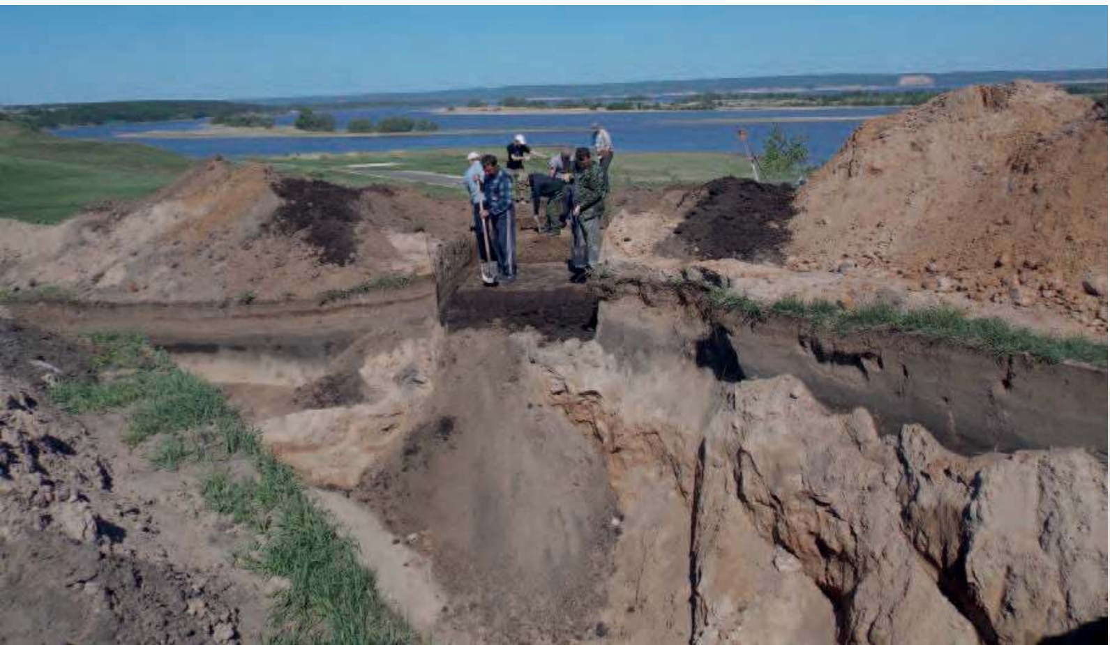
Рис. 532. Рабочий момент. Процесс выемки грунта.
