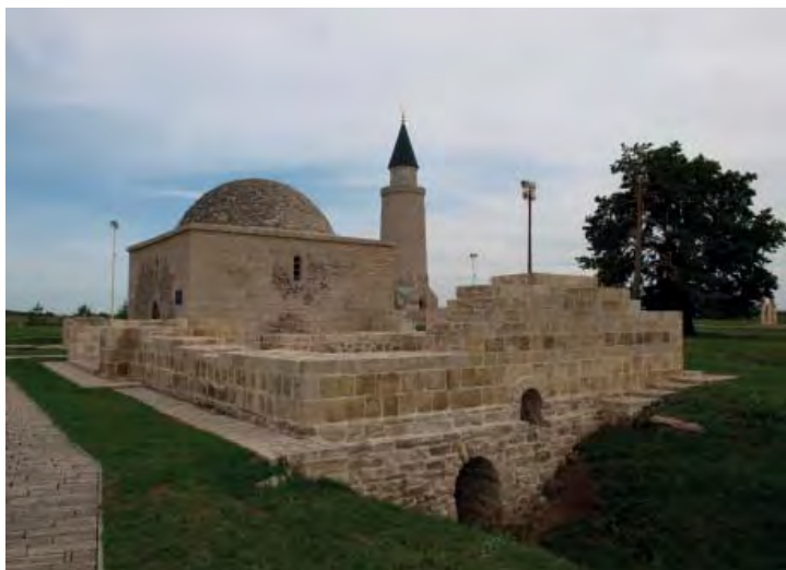
Рис. 23. Ханская усыпальница и Малый минарет после консервации 2011 г. Вид с северо-запада. На первом плане руины Большого западного мавзолея. Ниже дневного уровня – арочный проем входа к рабочему месту истопника и отопительной печи
