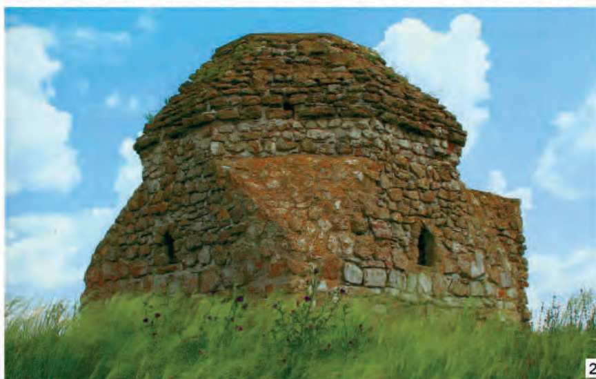
Рис. 21. Мавзолей Тура-хана, современный вид: 1 – фасад; 2 – вид сбоку
