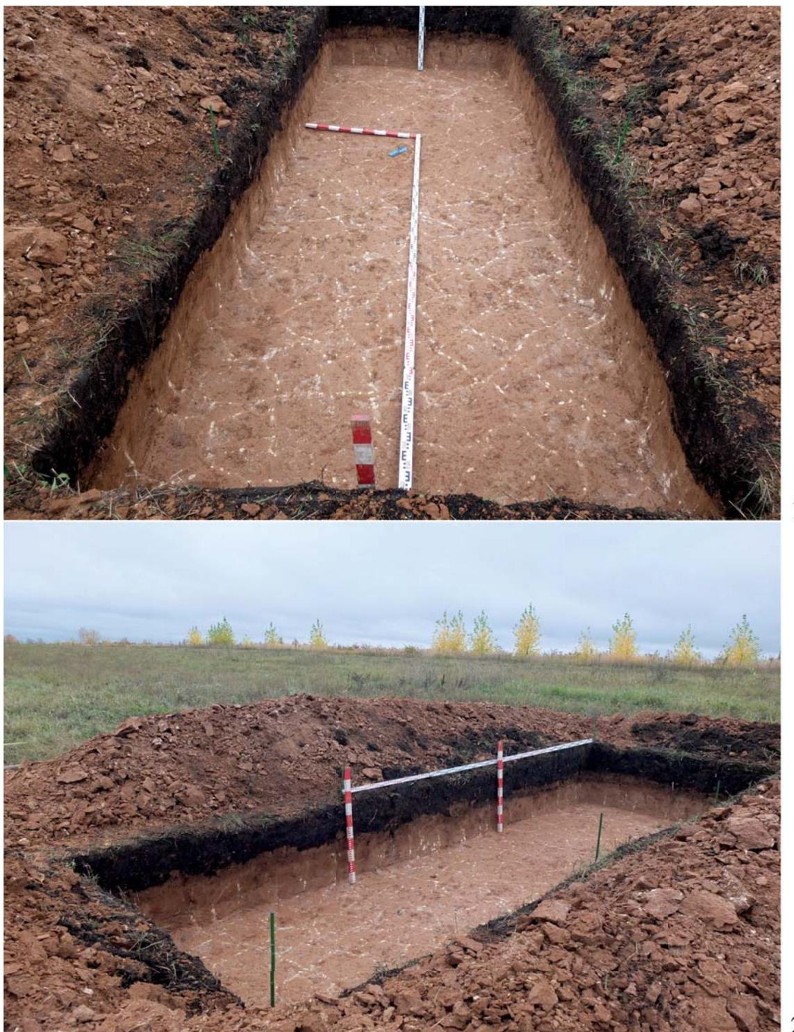
Рис. 11. Шурф 1, фото. 1 – после завершения уплотнение грунта на месте аномалии (-90 от 0);
