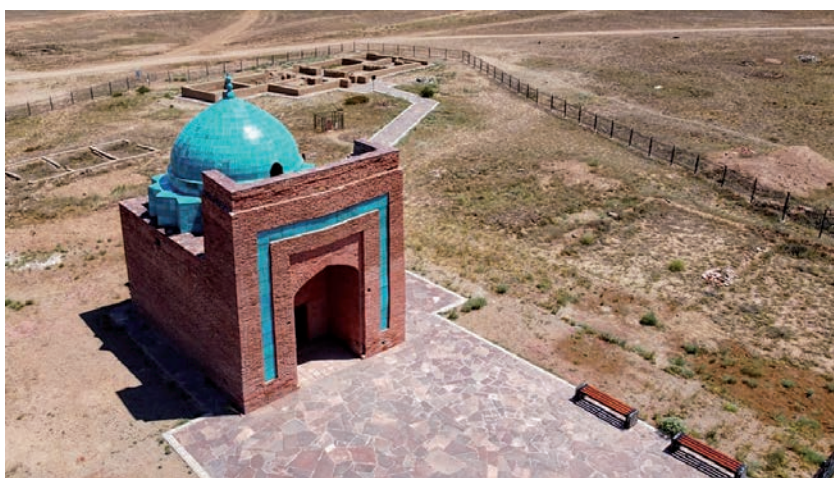
Рис. 3. Мавзолей Джучи-хана. Вид сверху, после реставрации. Фото В. Шуптар, 2021 г.
