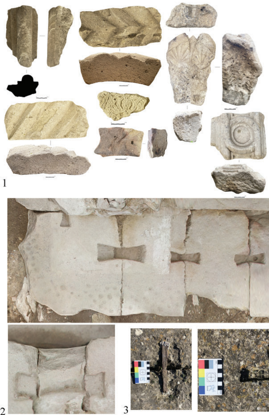
Рис. 3. 1 – фрагменты архитектурных деталей, обнаруженные в ходе исследований порталной части мечети; 2 – пазы для крепления плит пилонов портала мечети Куршун-Джами; 3 – пазы и металлические элементы креплений пилонов портала медресе Инджи-бек Хатун.
