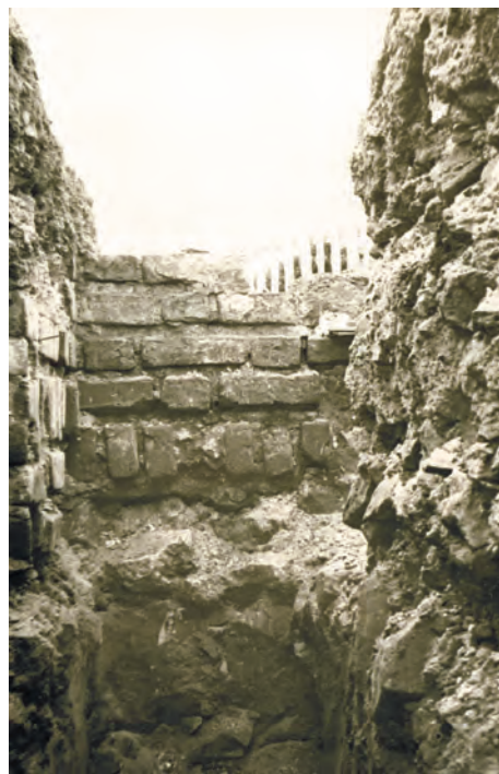
Рис. 123. Конюшенный двор, юго-восточная часть. Траншея № 1. Восточный фасад внутренней стены «север-юг»
