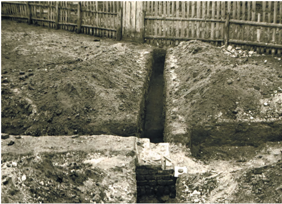
Рис. 117. Конюшенный двор, юго-восточная часть. Траншея № 1, западный отрезок. Зафиксирован фрагмент внутренней стены «север-юг»
