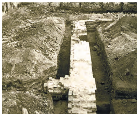
Рис. 125. Конюшенный двор, юго-восточная часть. Внутренняя стена «север-юг» и часть перегородки. Вид с севера
