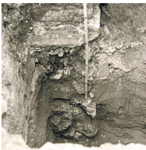
Рис. 99. Конюшенный двор. Южное крыло въездных ворот. Шурф № 3. Фундамент северного отрезка стены
