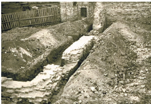
Рис. 137. Конюшенный двор, юго-восточная часть. Общий вид на внутреннюю стену «север-юг». На переднем плане проем II. Вид с юго-востока
