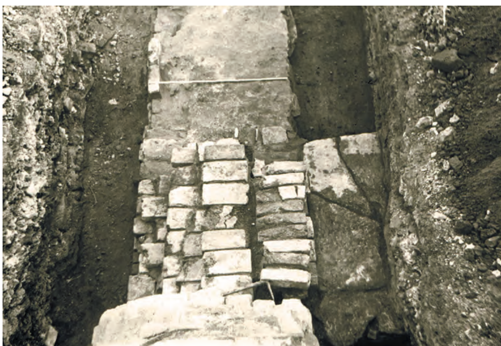
Рис. 131. Конюшенный двор, юго-восточная часть. Проем I во внутренней стене «север-юг». Вид сверху, с севера
