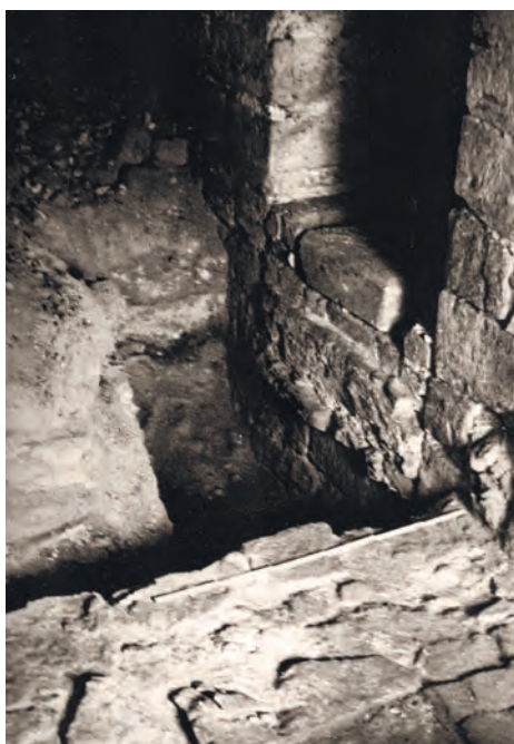
Рис. 70. Богородице-Успенский монастырь. Шурф № 1. Дверной проем в западной стене северо-восточной пристройки. Вид с северо-востока
