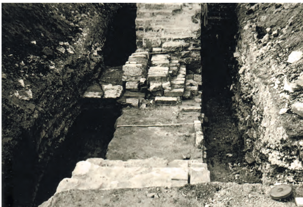
Рис. 133. Конюшенный двор, юго-восточная часть. Закладка в проеме I. Слева от стены возле проема зафиксирован порог. Вид с юга
