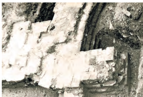
Рис. 85. Конюшенный двор. Южное крыло въездных ворот. Фрагмент северной стены, дуги с пилястрой и северной лопаткой. Вид с северо-запада
