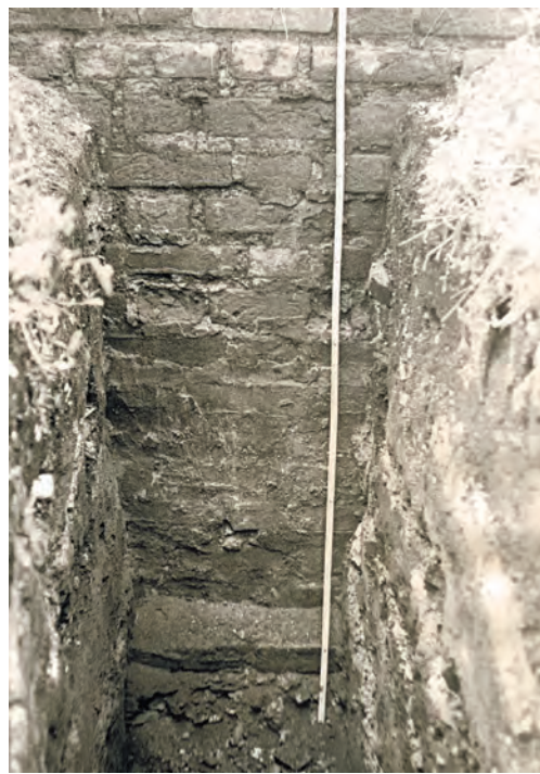
Рис. 111. Конюшенный двор, юго-восточная часть. Шурф № 1. Расчищенная часть фундамента внешней стены. Вид с севера
