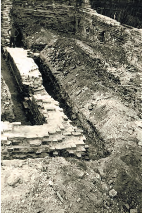
Рис. 138. Конюшенный двор, юго-восточная часть. Общий вид на внутреннюю стену «север-юг». На переднем плане проем II. Вид с юго-запада
