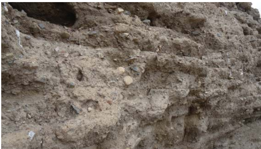
Рис. 9. Деталь восточной стены из ленточного бетона.
