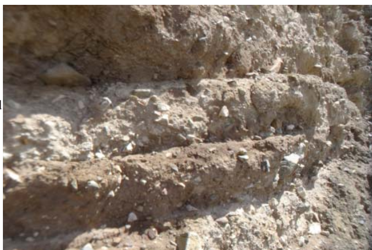
Рис. 10. Деталь восточной стенки из ленточного бетона.
