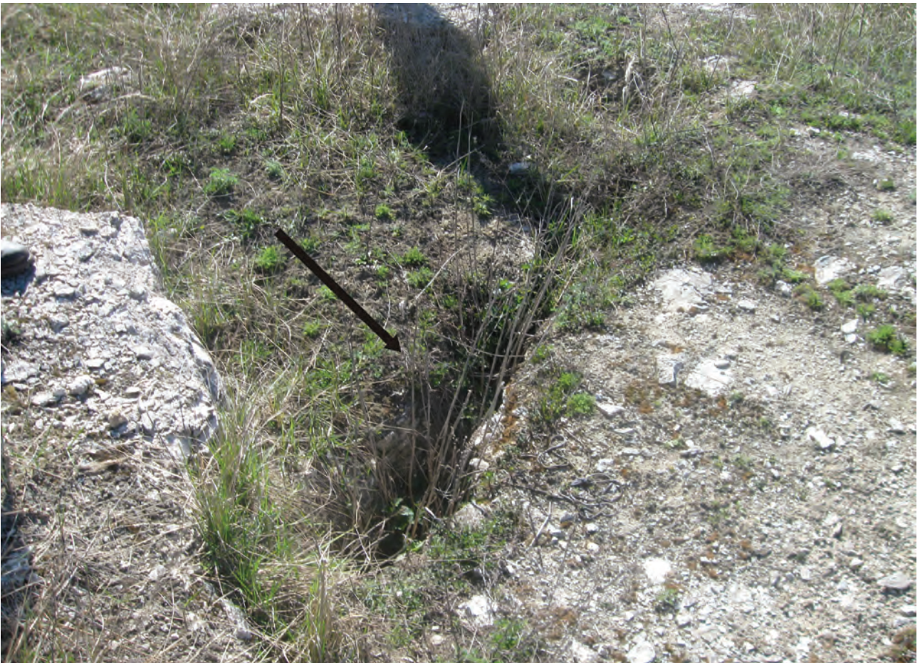
Рис. 5. Фотография карровой трещины на поверхности доломитовой плиты серии «подлужник».
