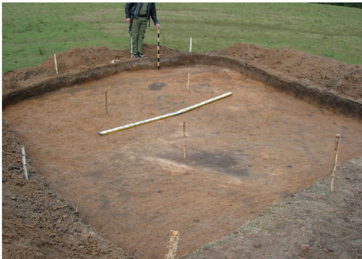
Рис. 9. Стена северо-западного склона.
