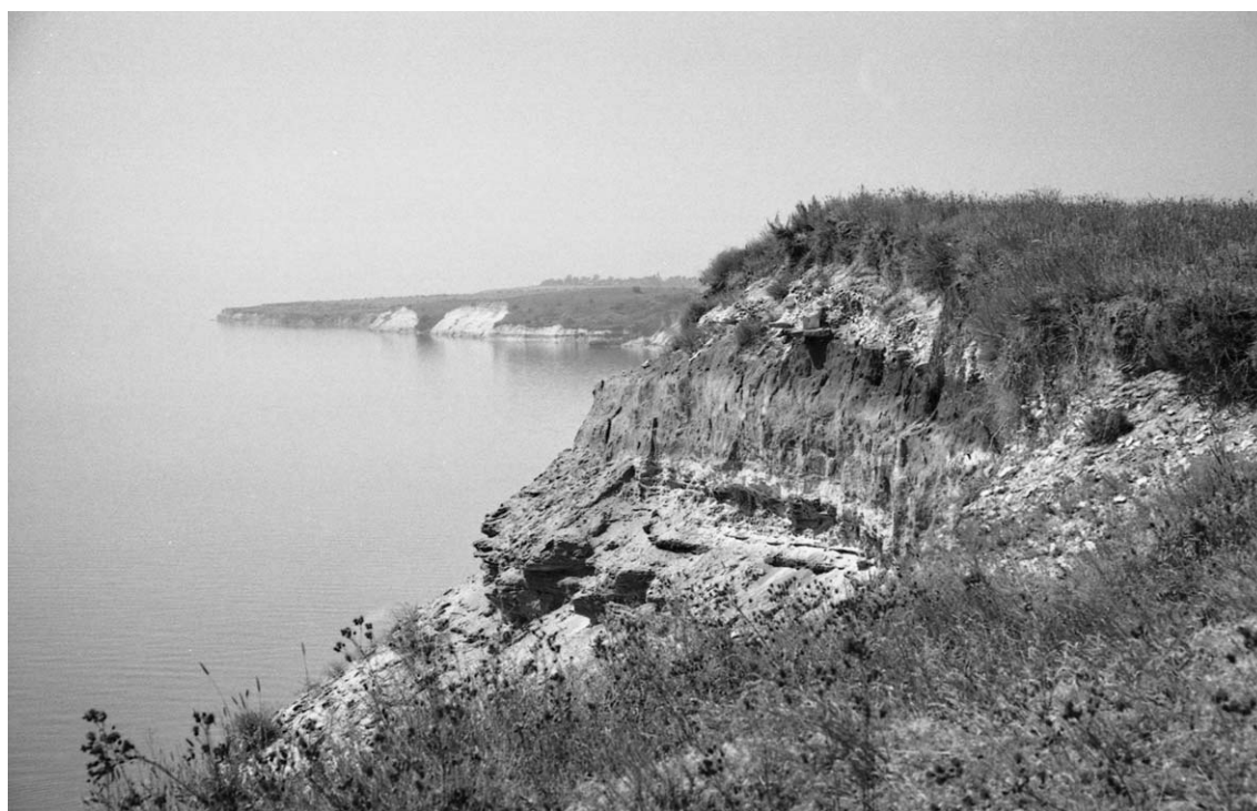
Рис. 5. Картина разрушения Правобережного Цимлянского городища водохранилищем. Фото 2003 г.
