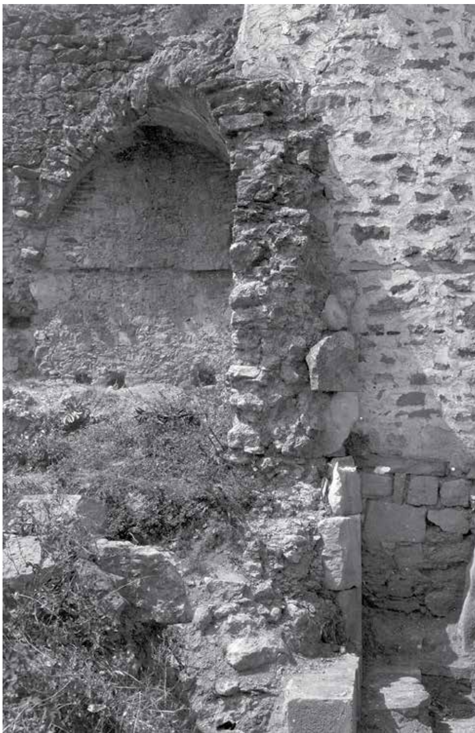
Рис. 132. Старый Крым. Фото 1925 г. Медресе, северо-восточный угол, вид с востока (ОПИ ГИМ. Ф. 598. Д. 28. Л. 28).
