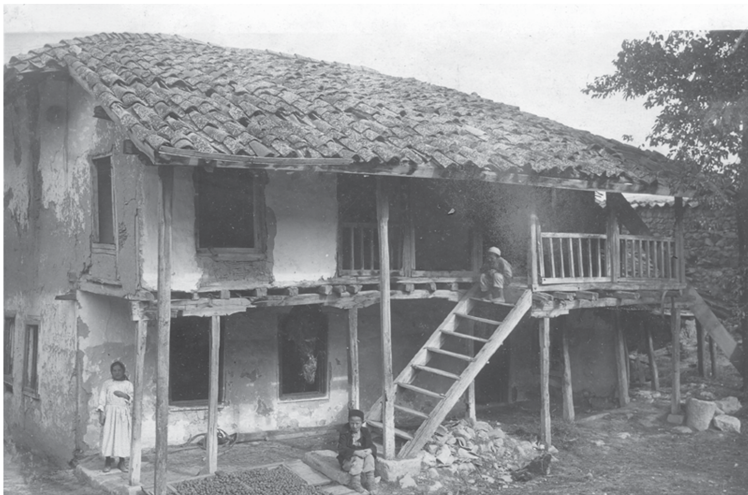
Рис. 53. Бахчисарай. Фото 1924 г. Дом No 41 в приходе Асма-Кую с балконом и балюстрадой. Стены дома снаружи и внутри обмазаны глиной (ОПИ ГИМ. Ф. 598. Д. 26. Л. 1).
