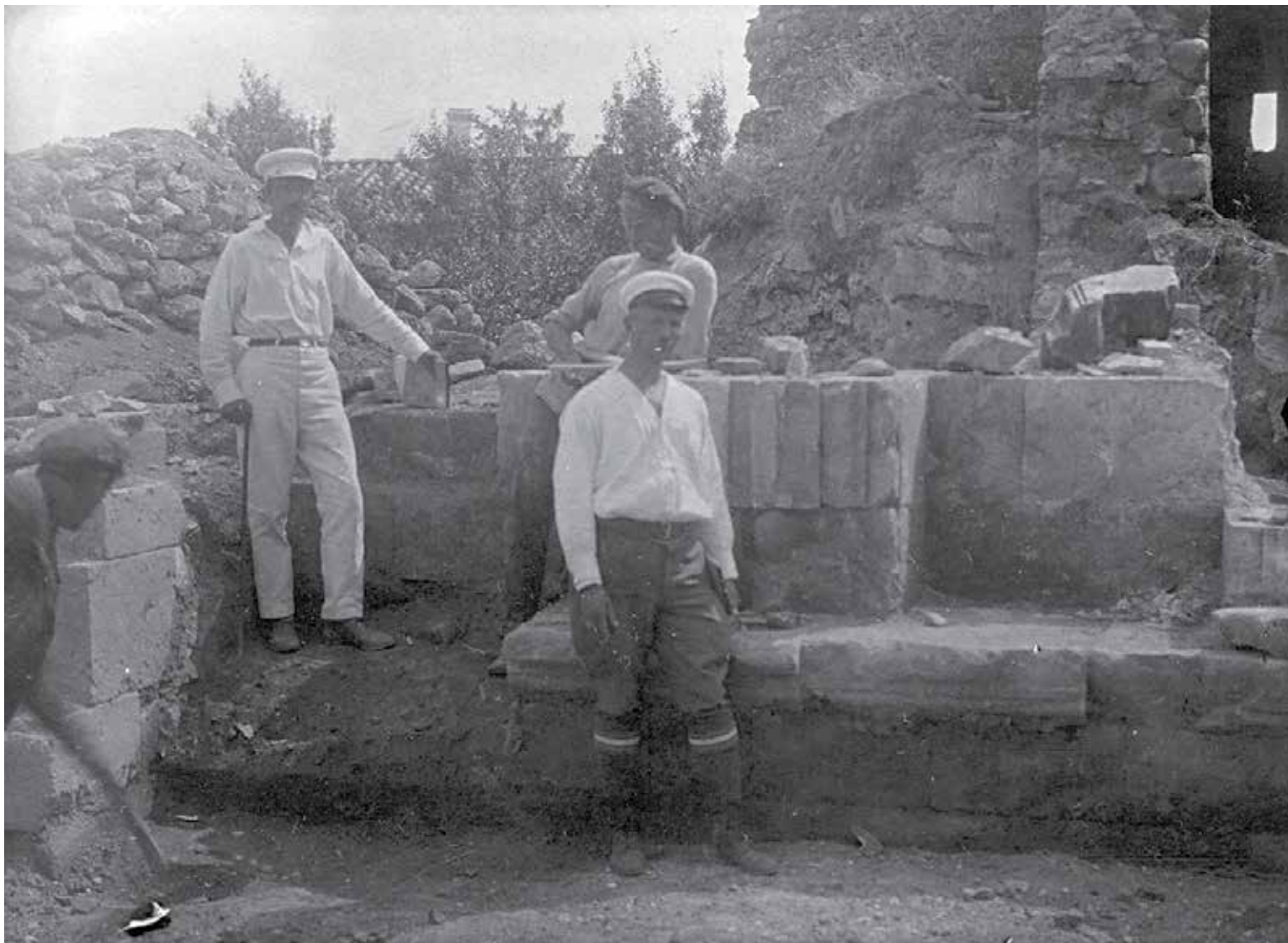
Рис. 324. Старый Крым. Фото 1925 г. Портал входа восточной стены. Вид с севера. Стоят А. С. Башкиров, И. Н. Бороздин (ОПИ ГИМ. Ф. 598. Д. 27. Л. 70).
