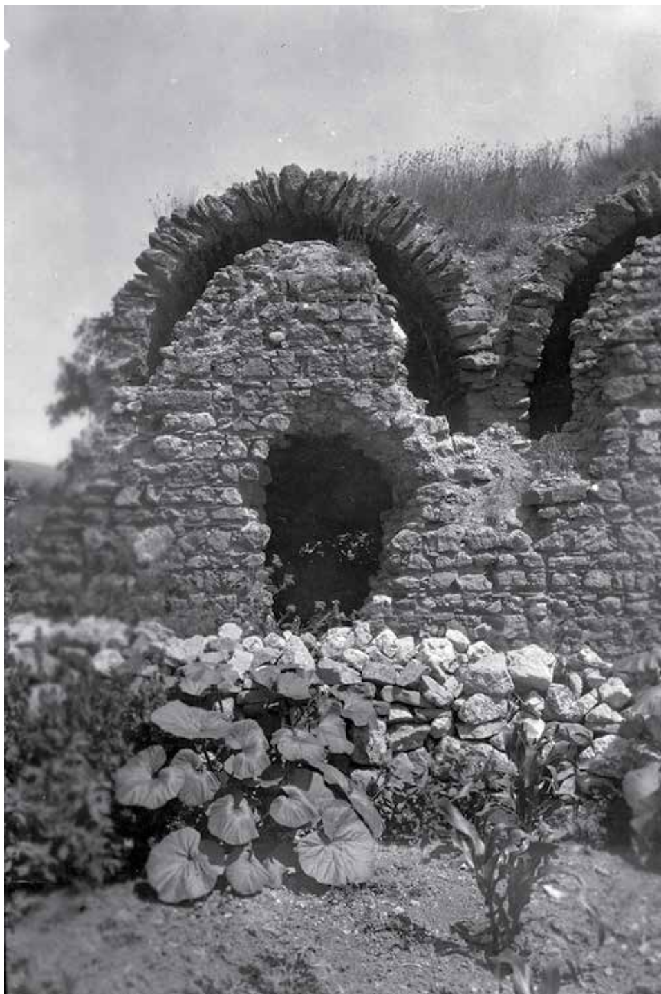
Рис. 127. Старый Крым. Фото 1925 г. Медресе, внешняя часть южной стены, вид с юга (ОПИ ГИМ. Ф. 598. Д. 29. Л. 10).
