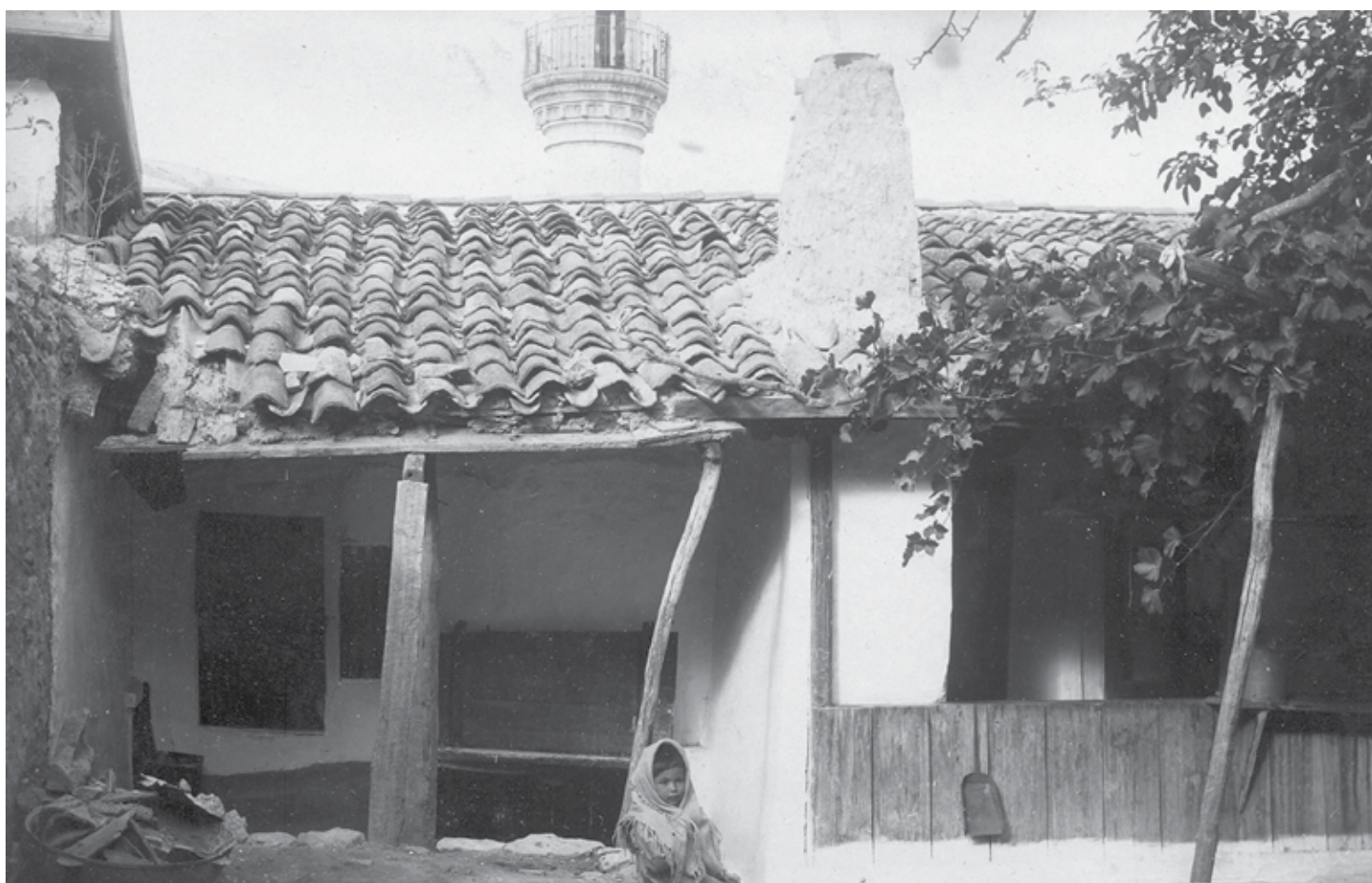
Рис. 61. Бахчисарай. Фото 1924 г. Дом No 63 в приходе Сарлы-Чишме. Постройка «Чатми-эф» – бревенчатый на деревянных гвоздях (ОПИ ГИМ. Ф. 598. Д. 26. Л. 3).
