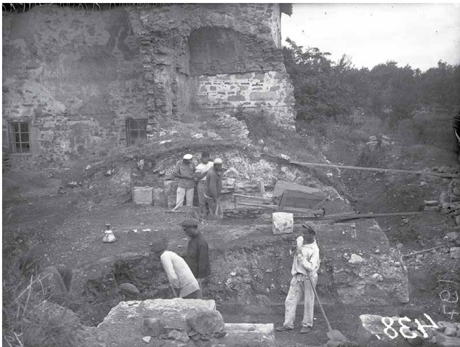
Рис. 308. Старый Крым. Фото 1926 г. Раскопки в восточной части медресе. Рабочий момент. Вид с юга (ОПИ ГИМ. Ф. 598. Д. 27. Л. 28).
