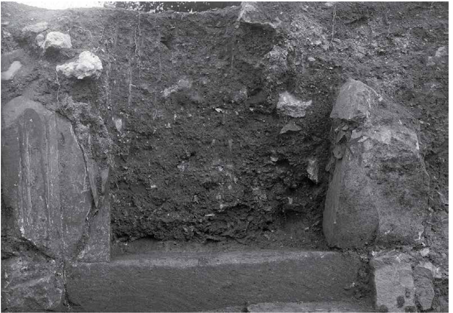
Рис. 208. Старый Крым. Фото 1925 г. Вход в северную худжру медресе (ОПИ ГИМ. Ф. 598. Д. 28. Л. 1).
