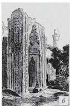
Рис. 206. Мечеть Узбека в Солхате (Крым, 1314 г.) – ближайший аналог Соборной мечети в Болгаре по принадлежности к зальному типу мечетей с несколькорядными опорами, скатной кровлей, выносным порталом, большей схожести ряда деталей, близости времени возведения: а, б) фасад; в) фрагмент интерьера.
