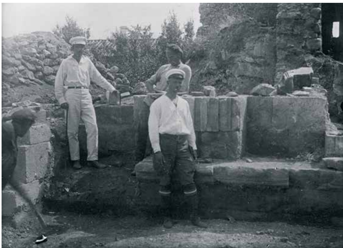
Рис. 20. Старый Крым. Фото 1925 г. Портал входа восточной стены. Вид с севера. Стоят А. С. Башкиров, И. Н. Бороздин (ОПИ ГИМ. Ф. 598. Д. 27. Л. 70).
