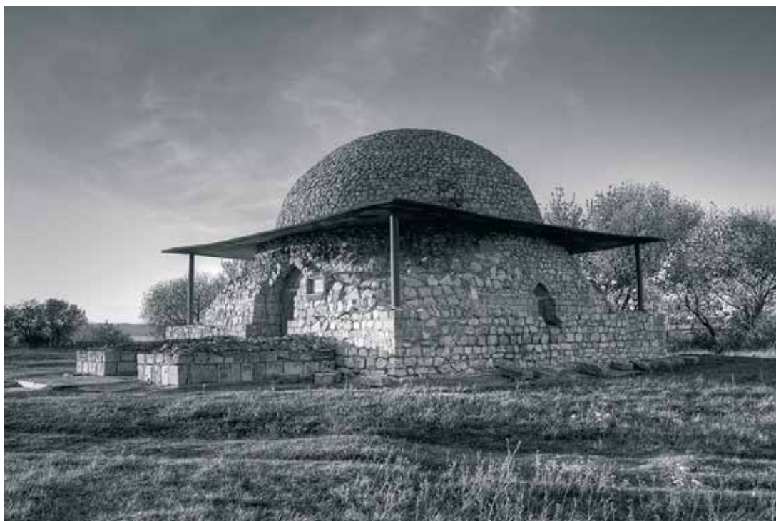
Рис. 194. Северный мавзолей. XIV в. Б) После реставрации и консервации 1970-х гг. Вид с юго-востока.
