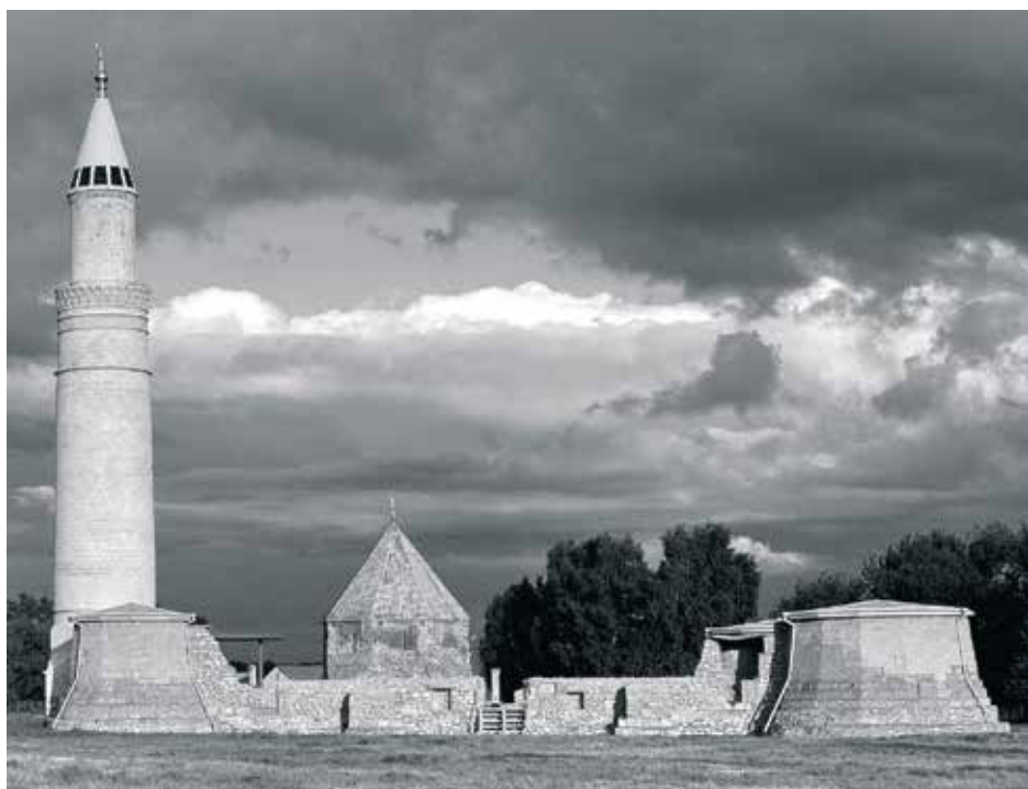
Рис. 200. Соборная мечеть и Большой минарет со стороны восточного фасада. Фото после консервационных работ начала 2000-х гг.
