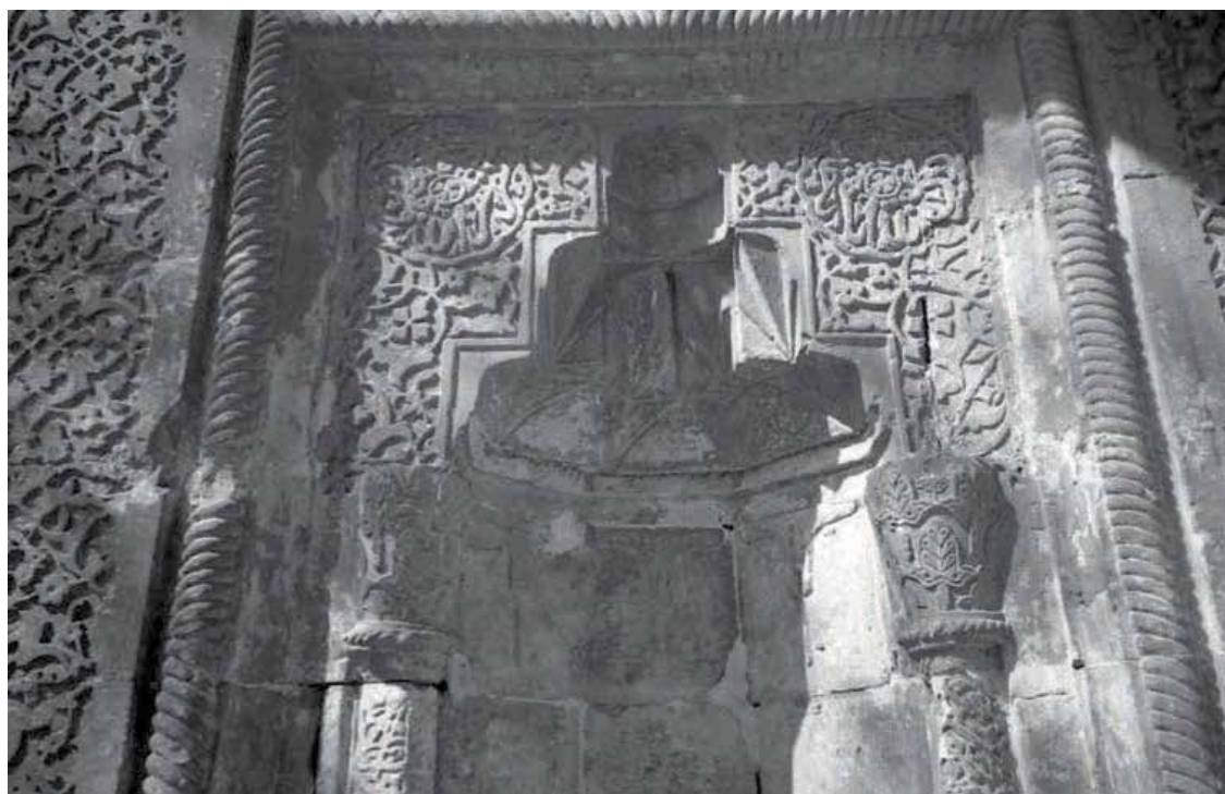
Рис. 432. Верхняя часть западной ниши портала дюрбе Хаджи Гирея.
