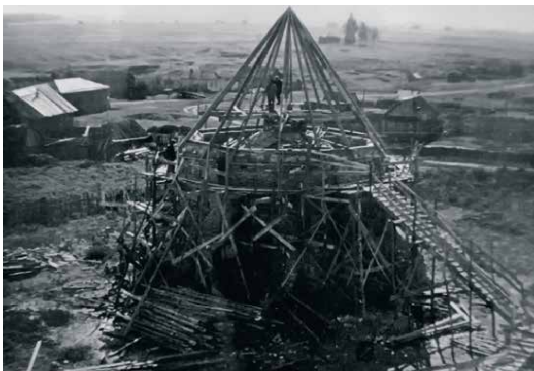
Рис. 187. Установка шатрового покрытия во время реставрационных работ на Восточном мавзолее. Вид с колокольни Успенской церкви. Фото начала 1970-х гг.
