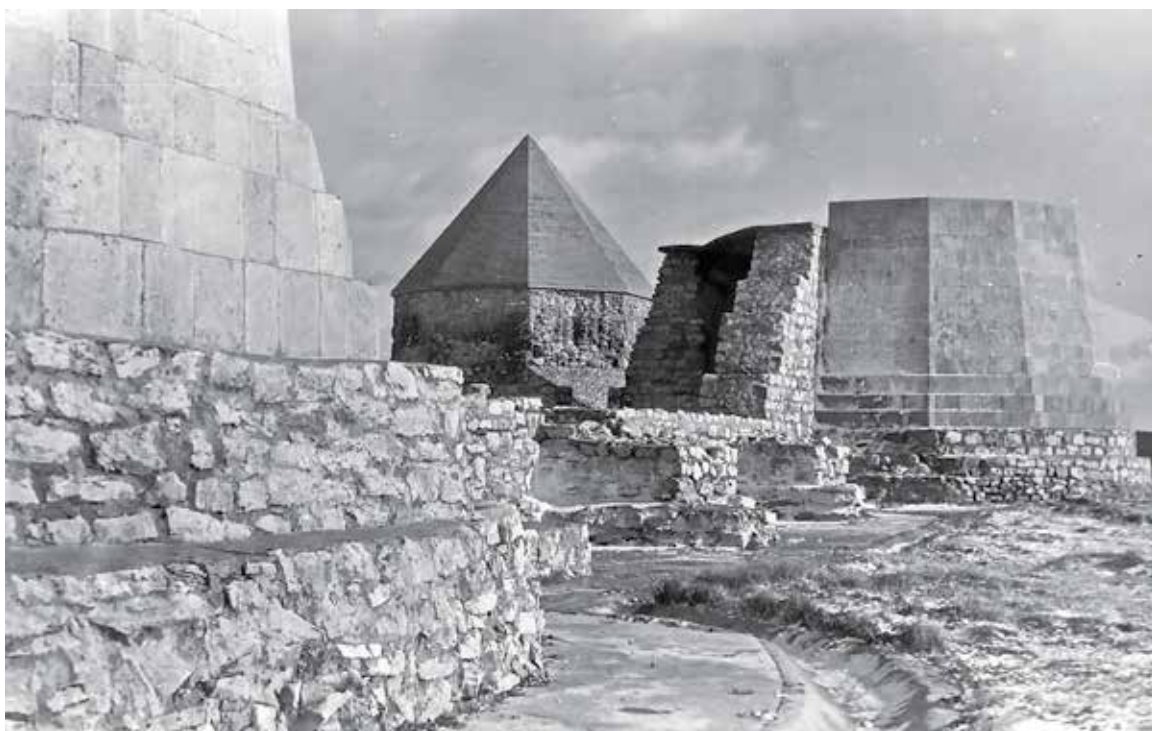
Рис. 192. Консервация и реставрация Соборной мечети. Вид на южный фасад со стороны юго-запада. На втором плане – здание Восточного мавзолея. Фото 1973 г.
