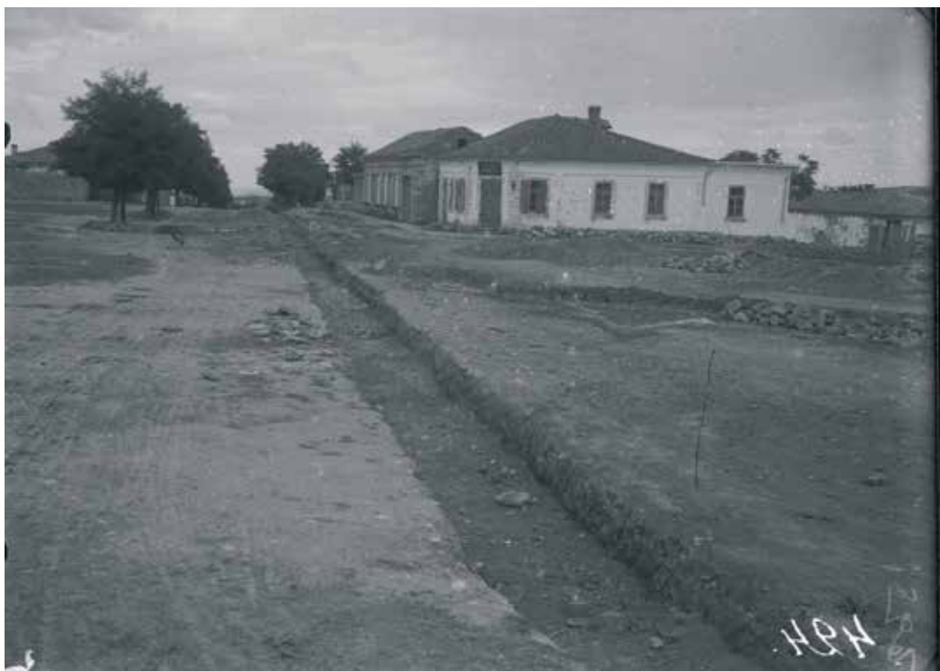
Рис. 34. Старый Крым. Фото 1926 г. Земляные работы по укладке покрытия Греческой и Крестьянской улиц, в ходе которых был выявлен гончарный горн (ОПИ ГИМ. Ф. 598. Д. 28. Л. 75).
