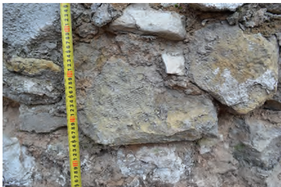
45. Известняк со следами обработки в кладке южной стены. Фото 2011 г.
