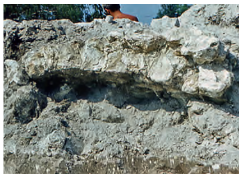
27. Фрагмент рухнувшей кладки в завале
