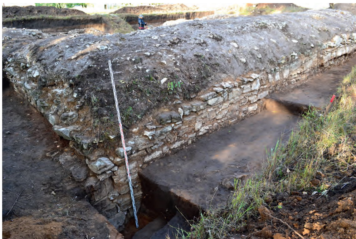
44. Южное здание. Внешний фасад южной стены. Общий вид с юга. Фото 2011 г.
