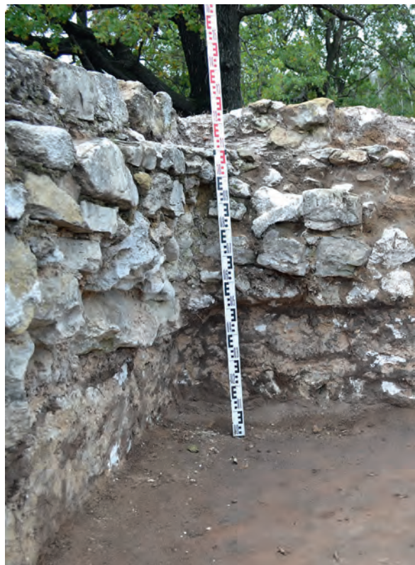
42. Южное здание. Западная стена, юго-западный внутренний угол. Фото 2011 г.
