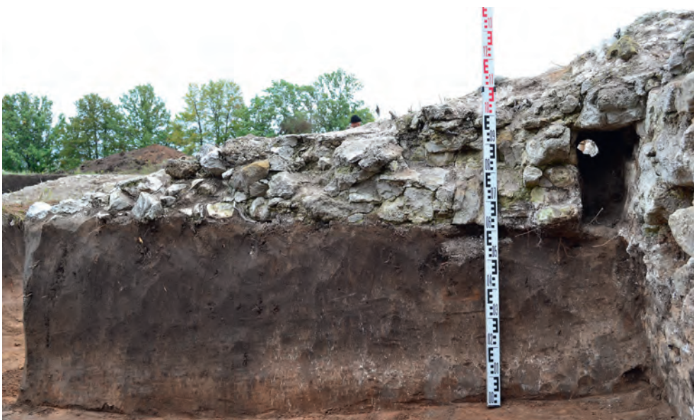
38. «Южное здание». Внутренняя перегородка. В углу (справа от рейки) видна прямоугольная пазуха – след от сваи (?). Вид с запада. Фото 2011 г.
