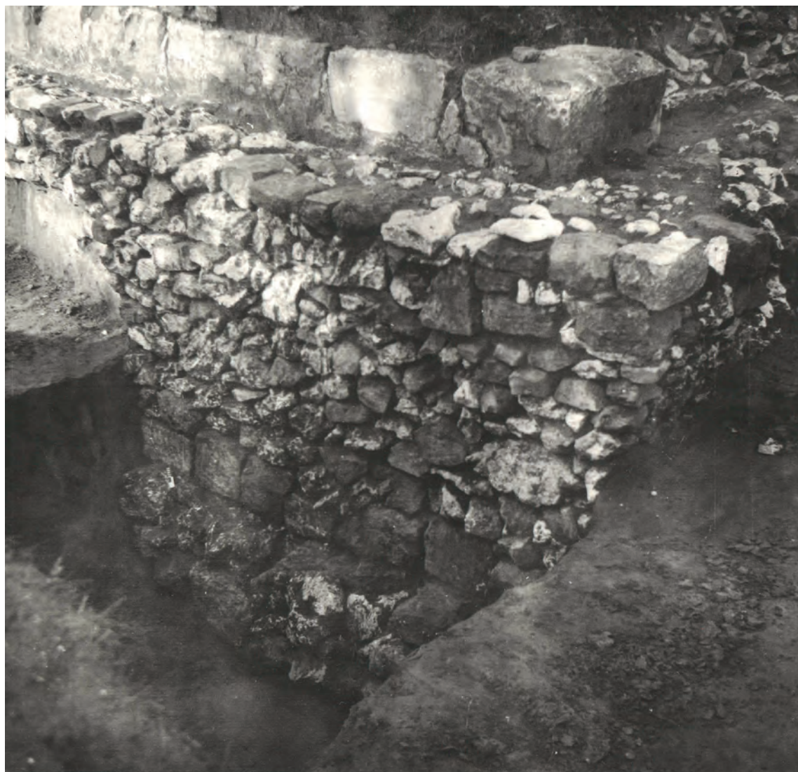
28. Въездные ворота. Нижняя часть южного фасада
