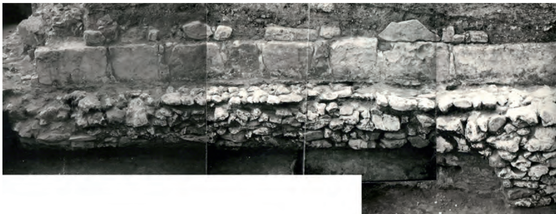
30. Восточный пилон. Кладка фундамента и цоколя восточной стены
