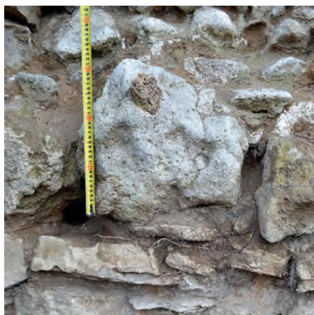
48. Крупные обломки застывшего раствора в кладке южной стены. Фото 2011 г.
