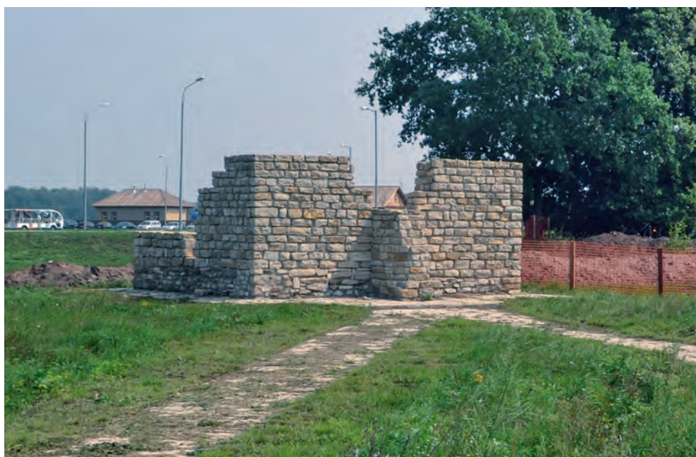
59. Здание с водоемом до реконструкции
