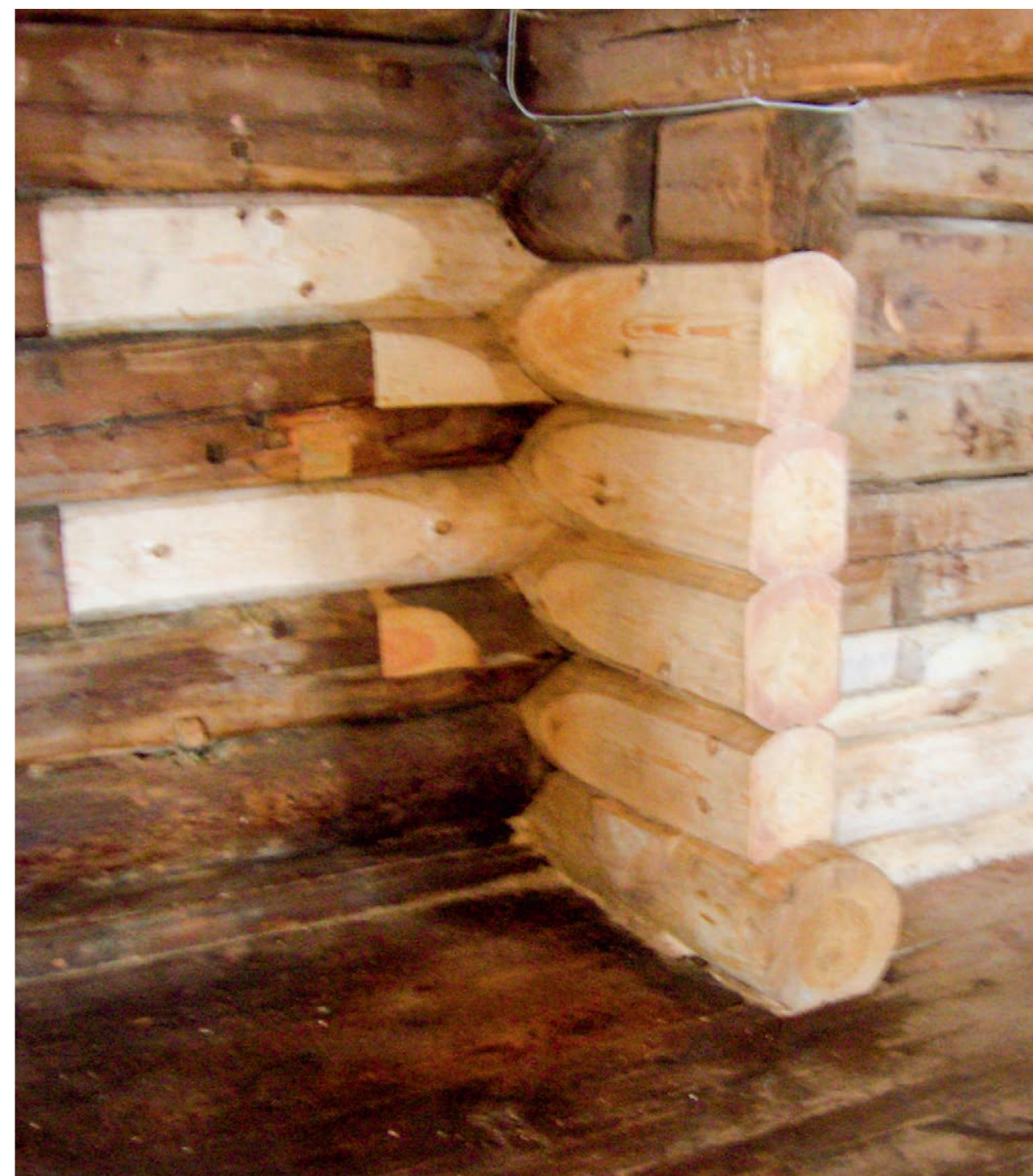
Рис. 122. Врубка для опирания скамьи в новой вставке. Северо-восточный угол трапезной. Фото 2014 г.
