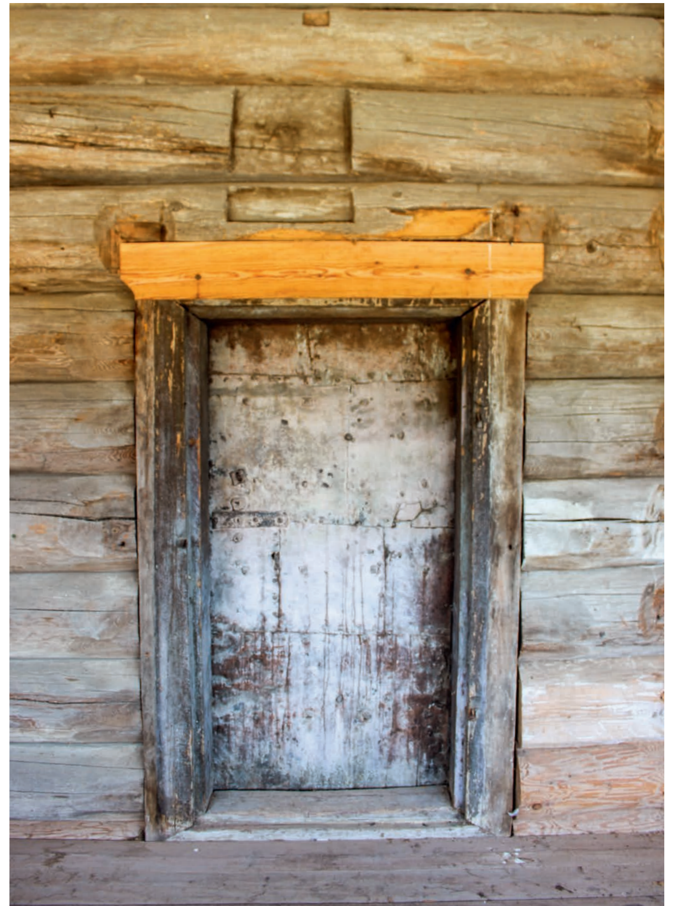
Рис. 101. Северная дверь храма со стороны экстерьера. Над дверью вырубленная ниша для установки иконы. Фото 2015 г.
