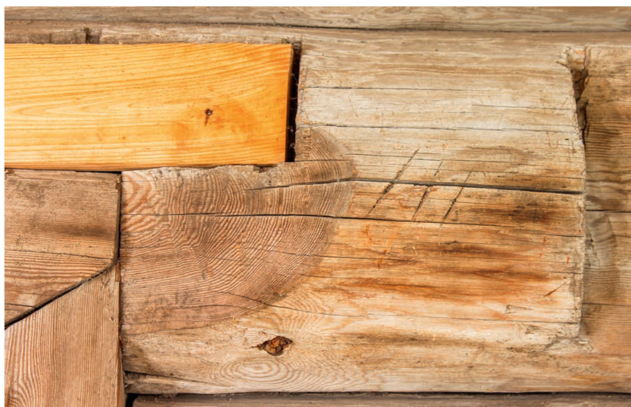
Рис. 22. Марка справа от двери на западной стене трапезной. Затески возле верхнего правого угла дверной колоды. Фото 2016 г.
