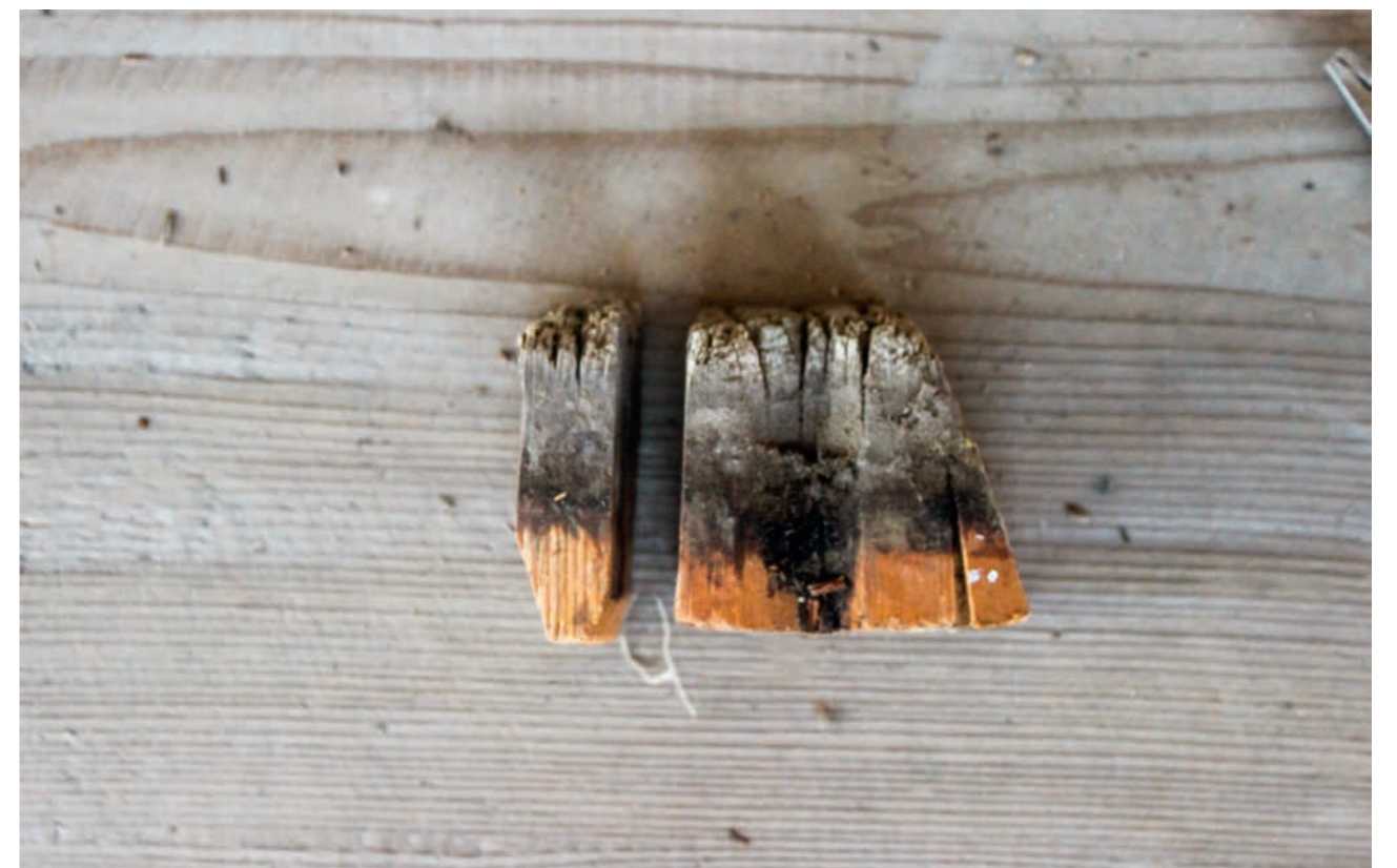
Рис. 38. Остатки опоры-«пальца», сохранившиеся в гнезде. Фото 2015 г.
