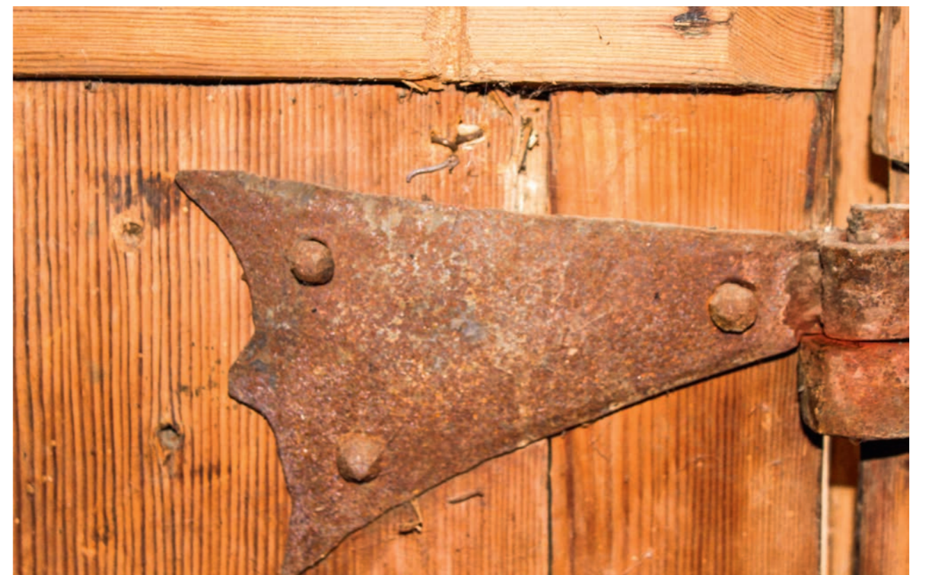
Рис. 99. Дверь трапезной. Петля в виде гусиной лапки. Фото 2015 г.
