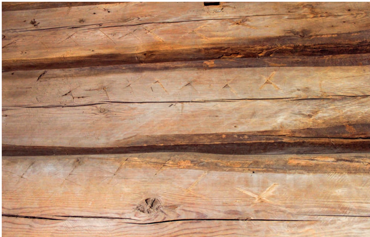
Рис. 17. Марки в юго-восточном углу со стороны трапезной на стене между основными объемами церкви. Фото 2016 г.
