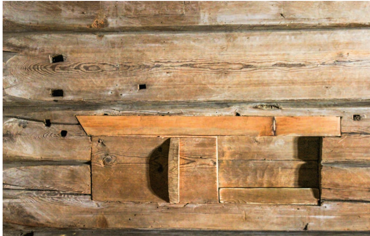
Рис. 83. Волоковое окно (южная стена трапезной, в юго-восточном углу). Фото 2015 г.
