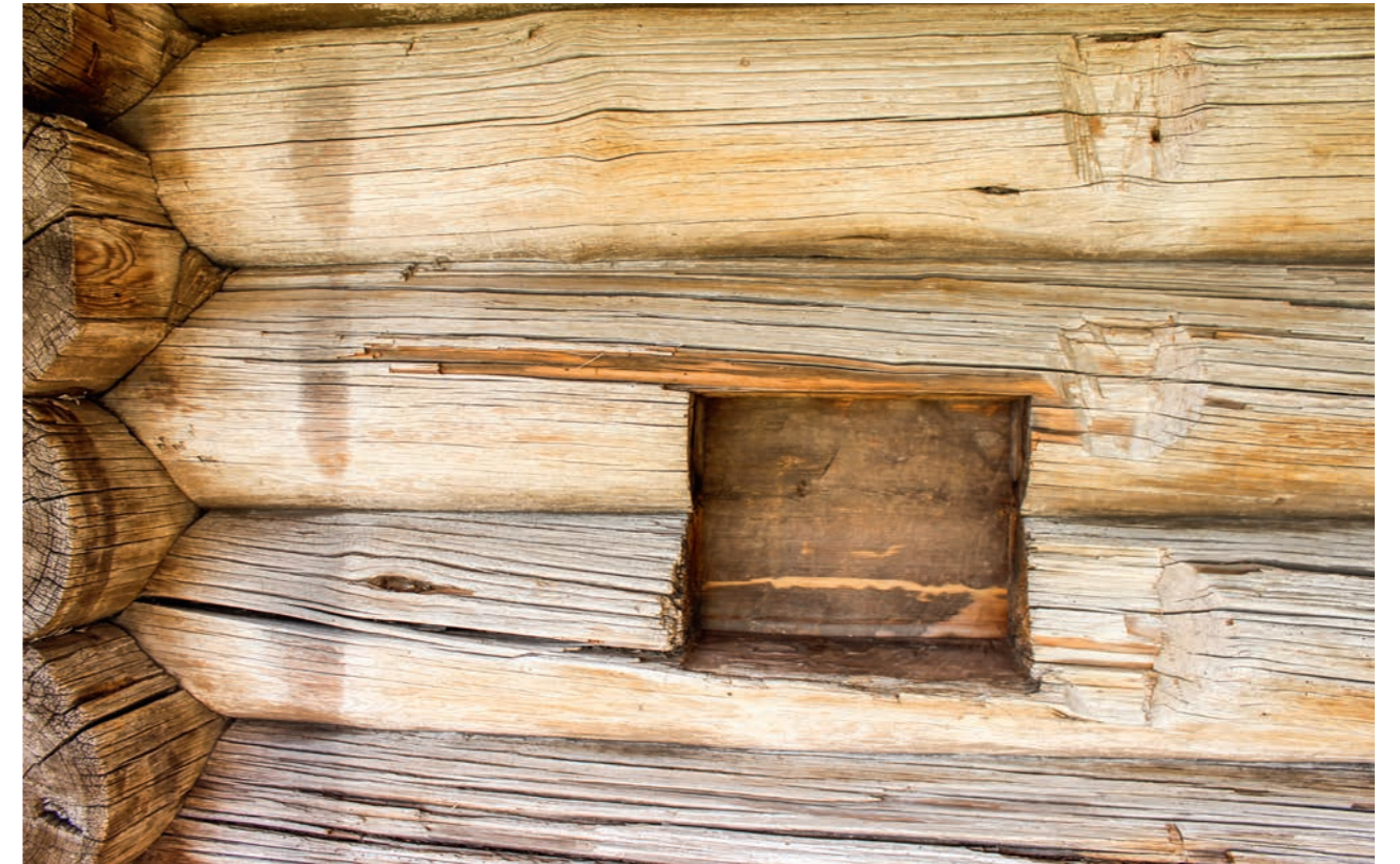
Рис. 85. Волоковое окно со стороны экстерьера (южная стена трапезной, в юго-западном углу). Фото 2015 г.
