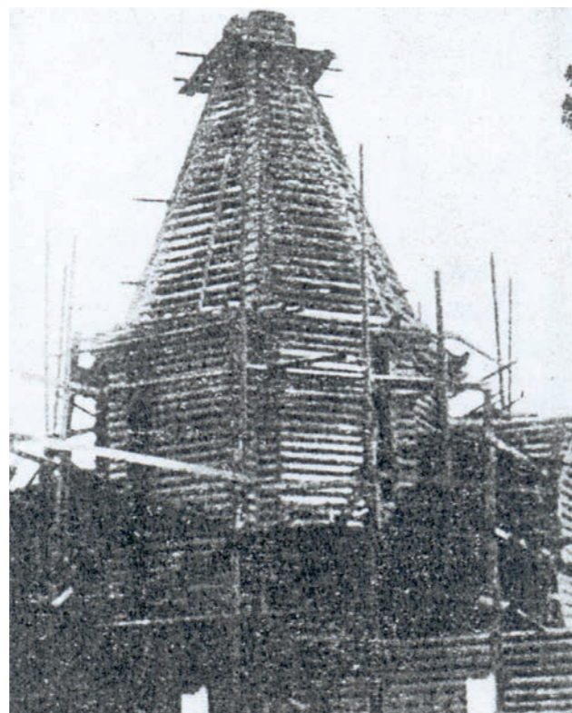
Рис. 205. Никольская церковь в с. Панилово. В процессе реставрации. ИИАК. Начало XX в.
