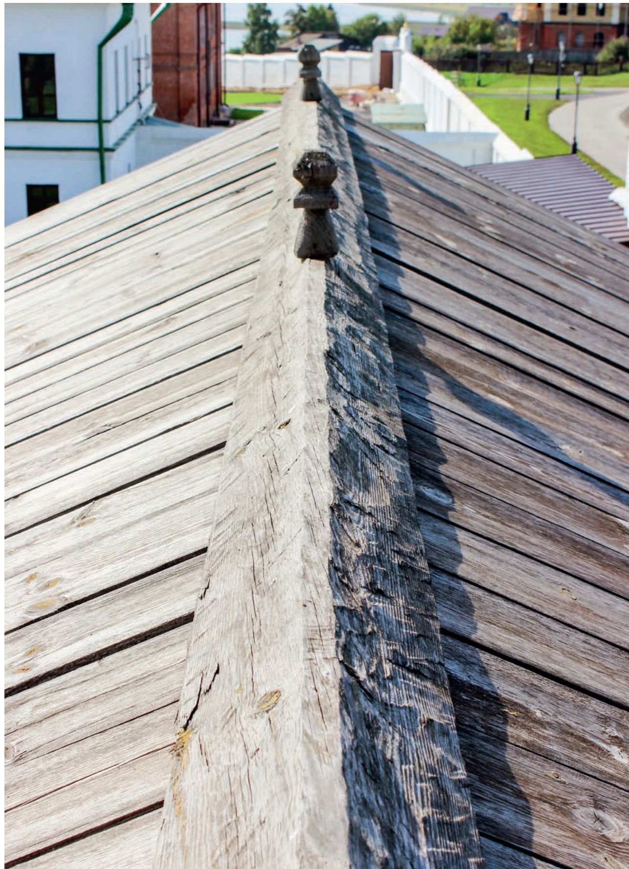
Рис. 72. Крыша трапеznой после реставрации с установленным тесаным охлупнем и декоративными стамиками. Фото 2015 г.
