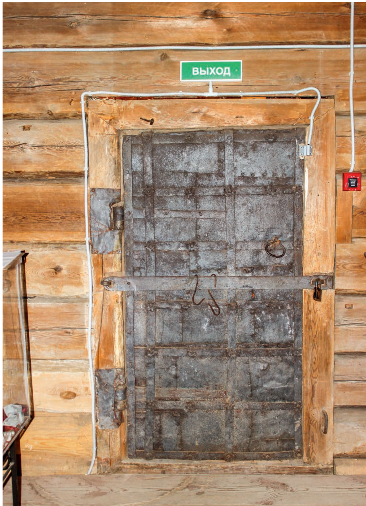
Рис. 100. Северная дверь храма со стороны интерьера. Фото 2015 г.
