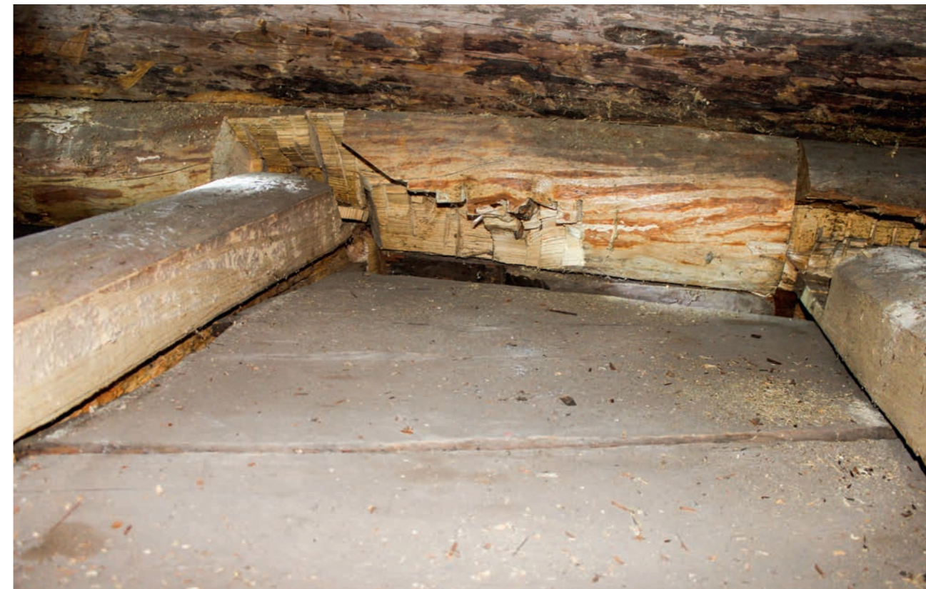
Рис. 62. Место врубки балки. Фото 2016 г.
