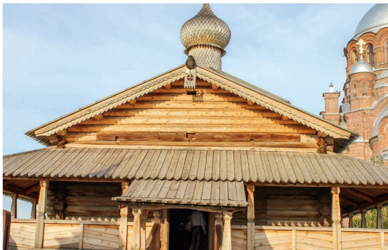
Рис. 69. Западный рубленый фронтон после ремонтных работ 2011 года. Гнезда от конструкции западной паперти. Фото 2015 г.
