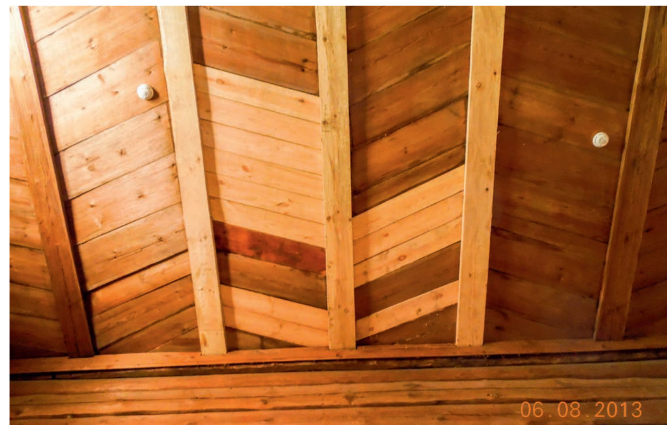
Рис. 63. Конструкция потолка трапезной. Фото 2013 г.
