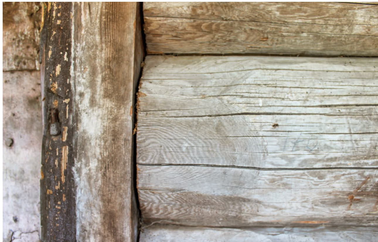
Рис. 102. Тройные затески возле северного дверного проема. Фото 2015 г.
