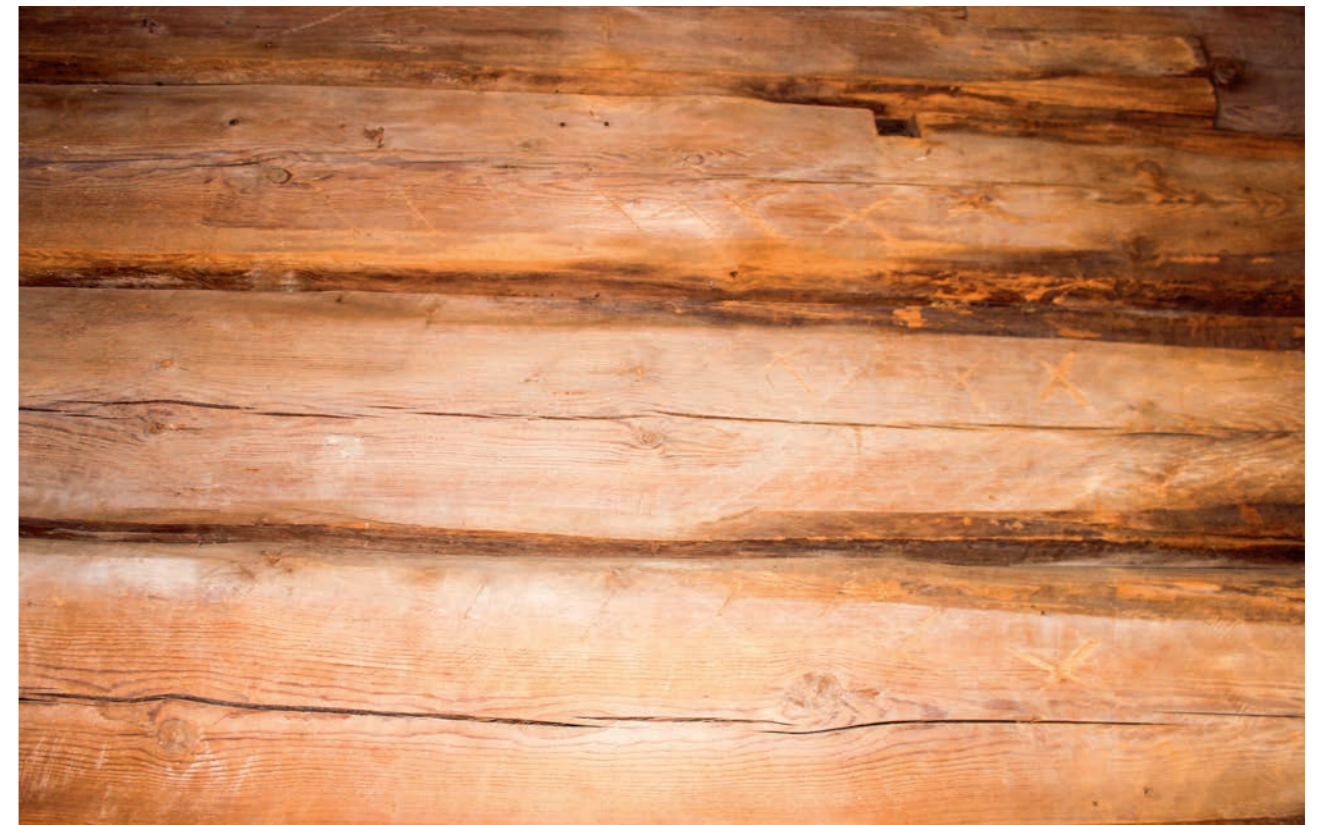
Рис. 15. Марки в юго-восточном углу со стороны трапезной на стене между основными объемами церкви. Фото 1016 г.
