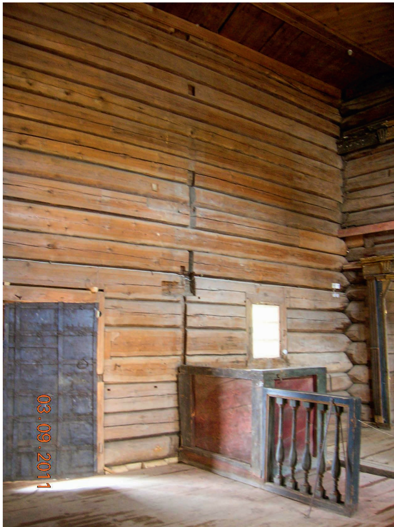
Рис. 127. Врубка примыкания первоначального иконостаса на северной стене храма. Фото 2011 г.
