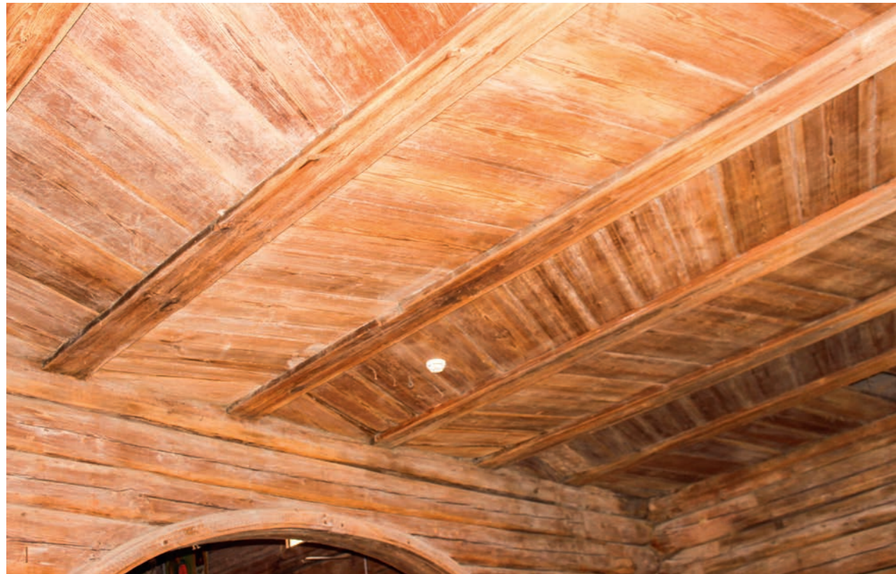
Рис. 64. Конструкция потолка трапезной. Фото 2015 г.
