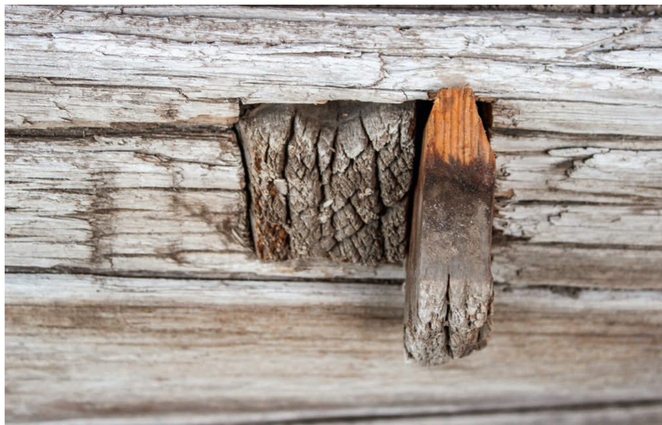
Рис. 36. Остатки опоры-«пальца» для подмостей. Фото 2015 г.
