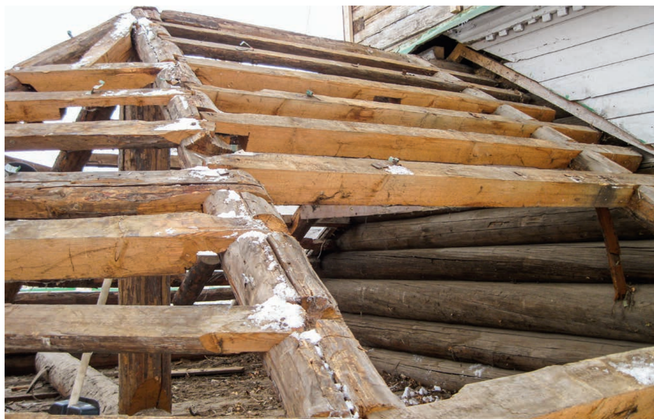
Рис. 53. Подкровельные конструкции алтаря. Слеги и врубленные в них прогоны из бруса. Фото 2011 г.
