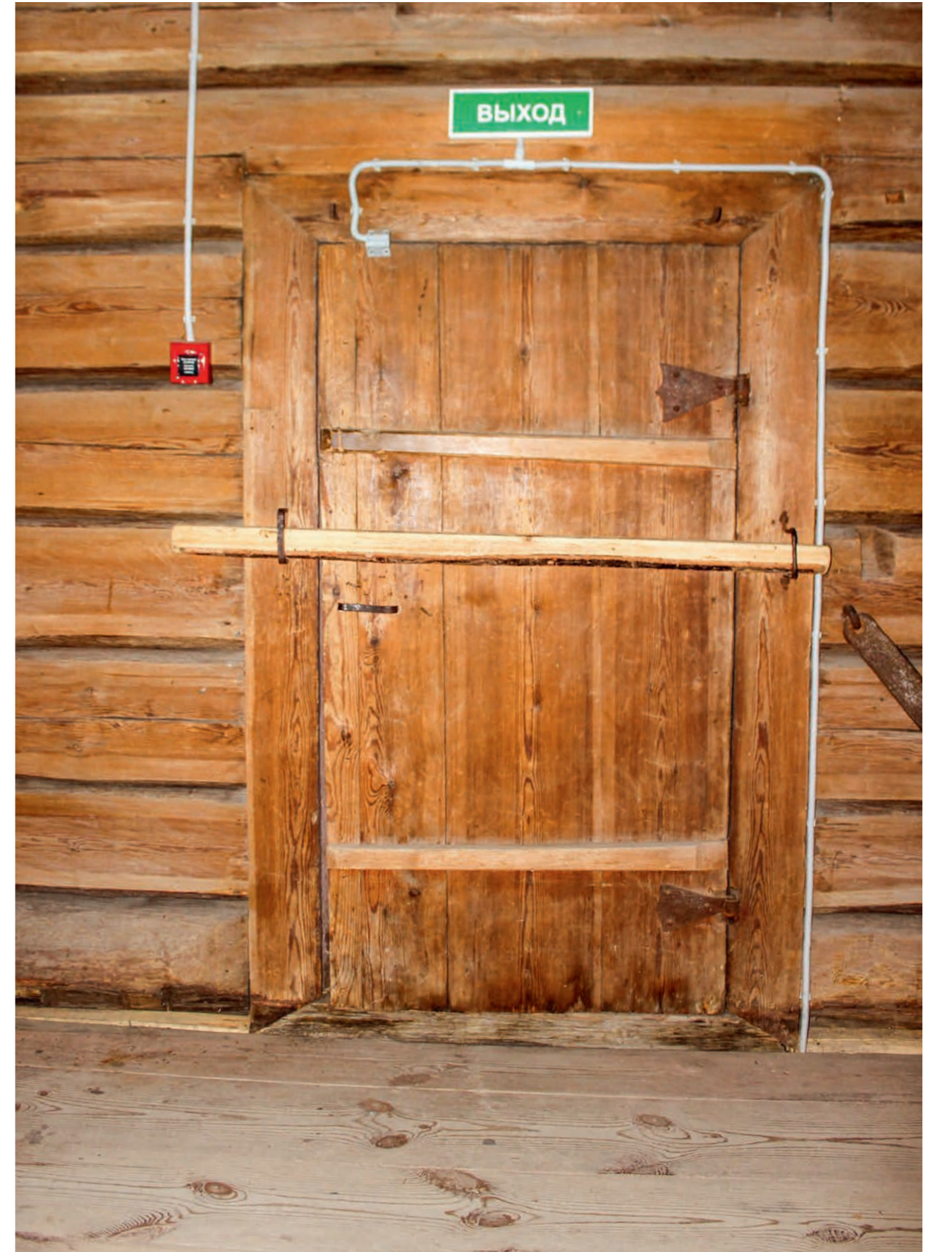
Рис. 95. Южная дверь храма со стороны интерьера, следы заложенного «красного» окна. Фото 2015 г.
