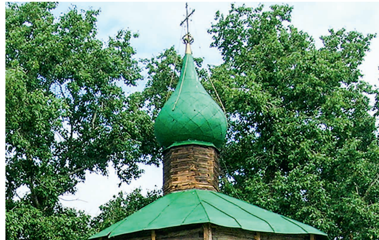
Рис. 73. Глава Троицкой церкви до реставрации. Фото 2008 г.
