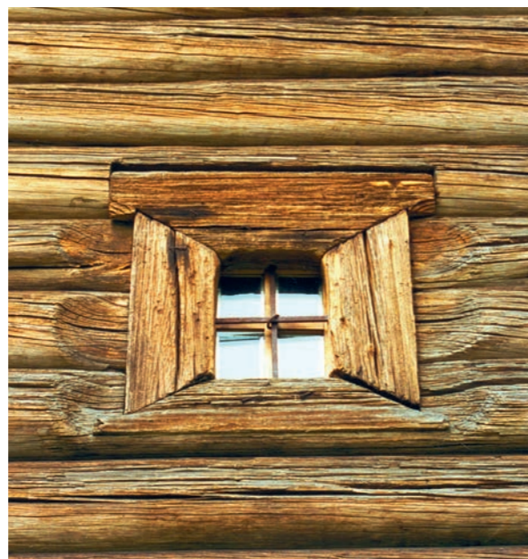
Рис. 198. Успенская церковь в с. Лявля (1584 г.). Косячатое окно. Вид снаружи. Фото И.Н. Шургина, 2007 г.
