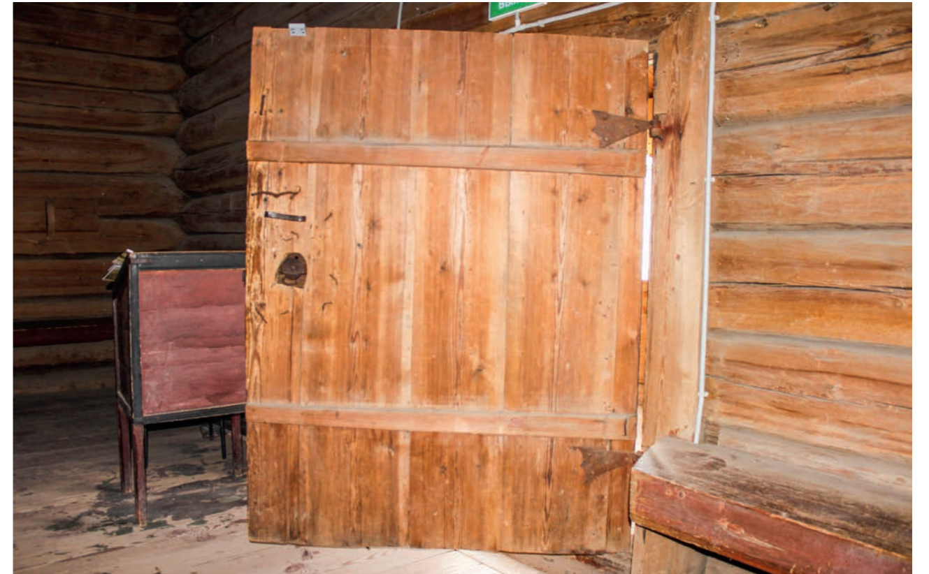
Рис. 98. Дверь трапезной. Вид изнутри. Фото 2015 г.
