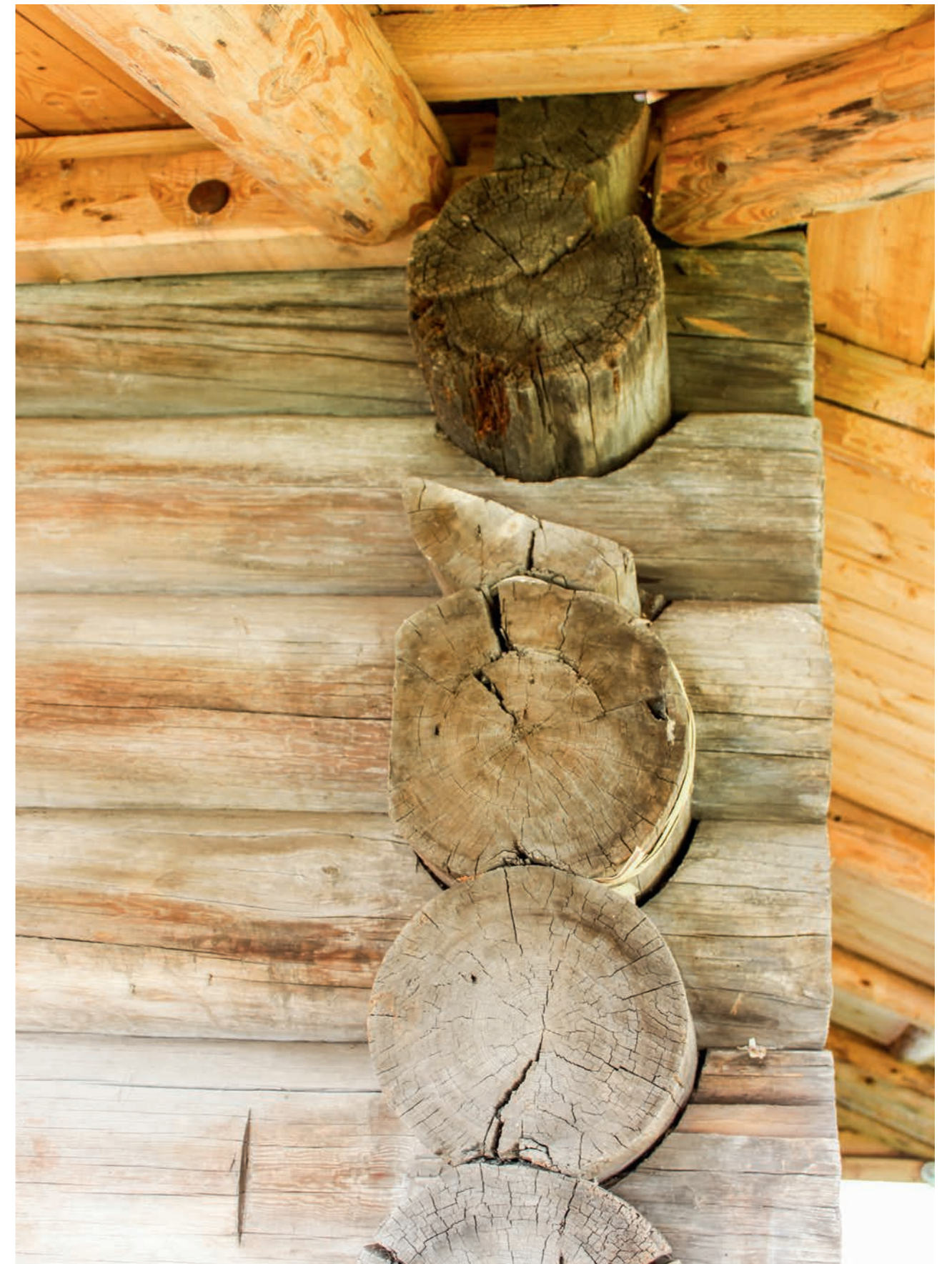
Рис. 107. Подтески для установки стоек паперти на бревнах западной стены трапезной справа от входного проема. Фото 2015 г.
