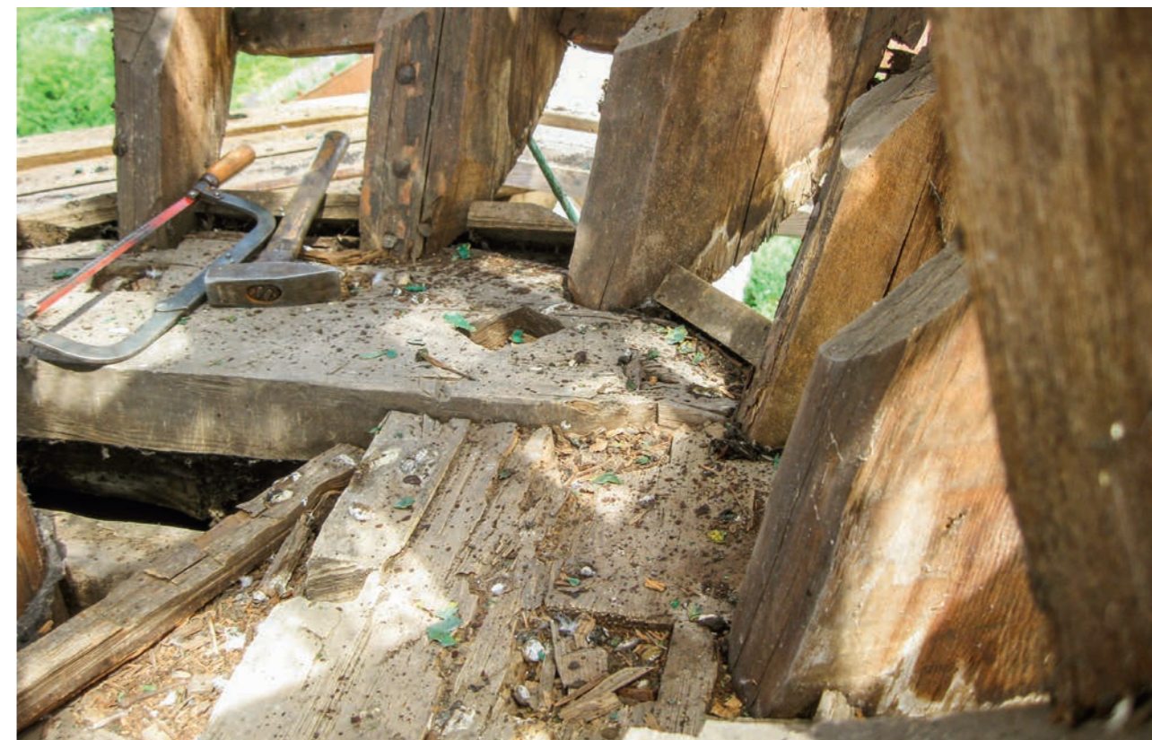
Рис. 77. Журавцы, установленные в гнезда. Фото 2011 г.
