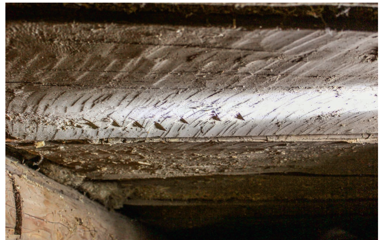
Рис. 34. Маркировка на тесинах потолка со стороны чердака. Фото 2016 г.
