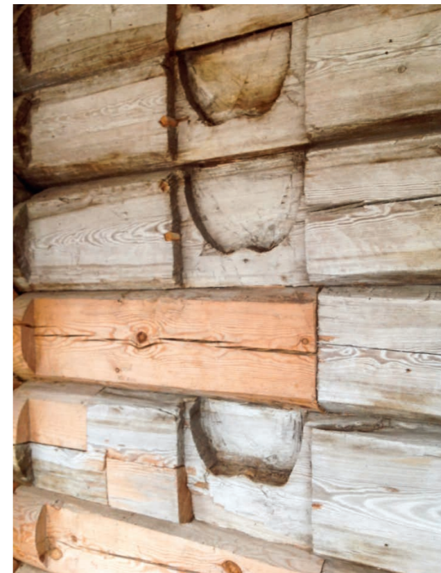
Рис. 12. Чаши на северной стене трапезной от прирубленного придела. Фото 2015 г.
