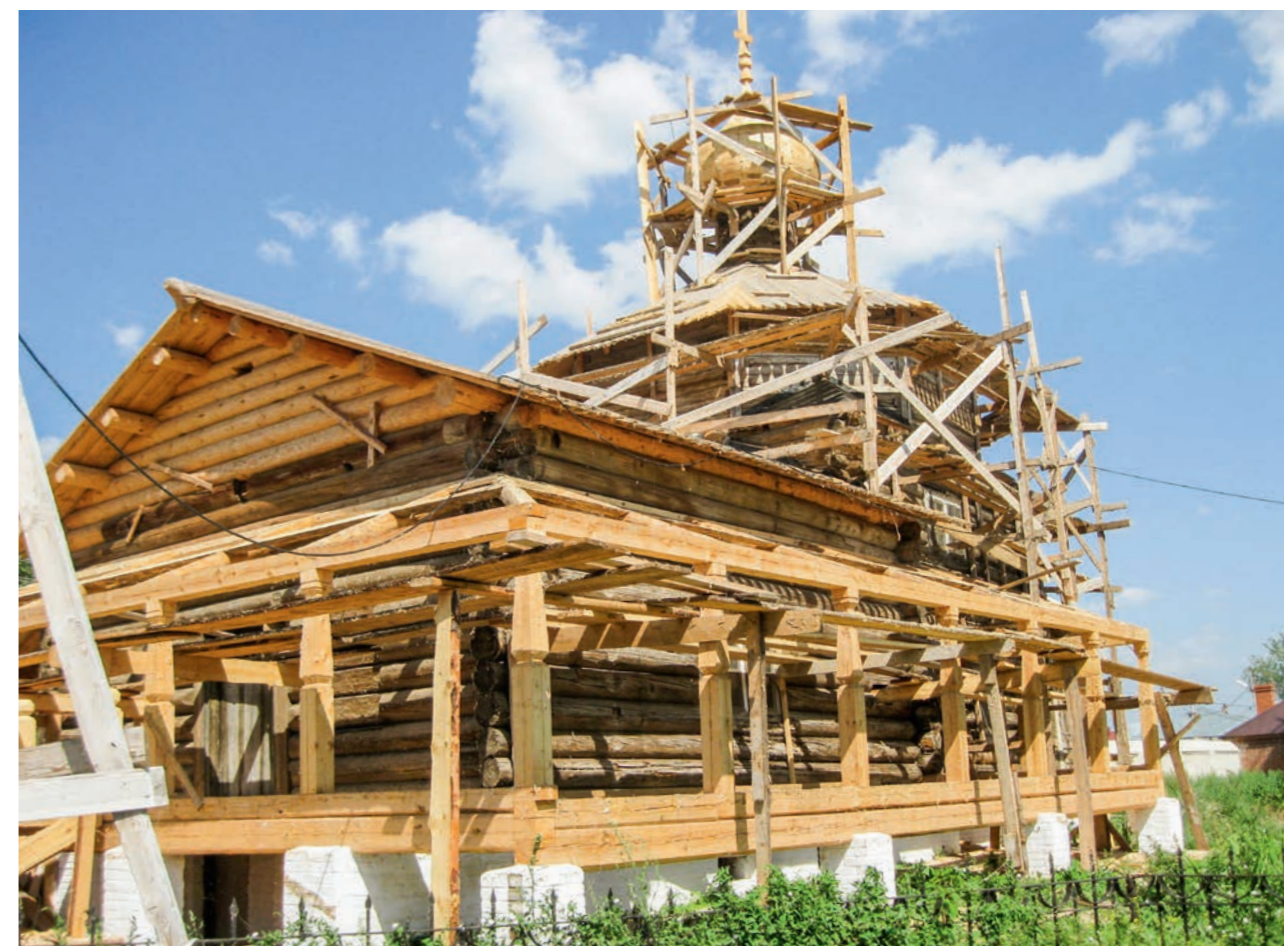
Рис. 131. Троицкая церковь в процессе ремонтных работ. Фото 2011 г.
