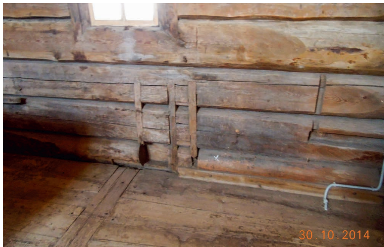
Рис. 124. Следы конструкции для разжигания угля в интерьере первоначального алтаря. Фото 2014 г.
