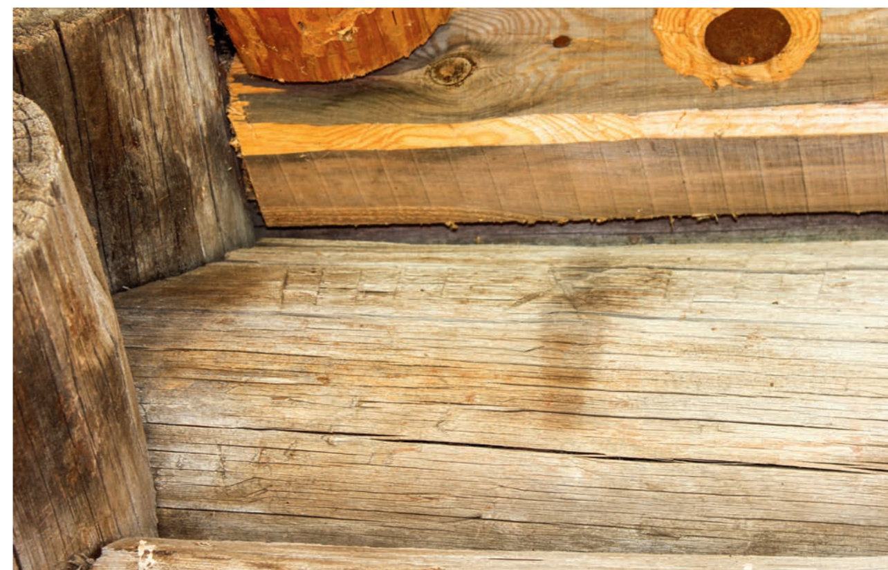
Рис. 27. Маркировка на южной стене трапезной. Крепление с помощью болтов галереи к срубу. Фото 2016 г.
