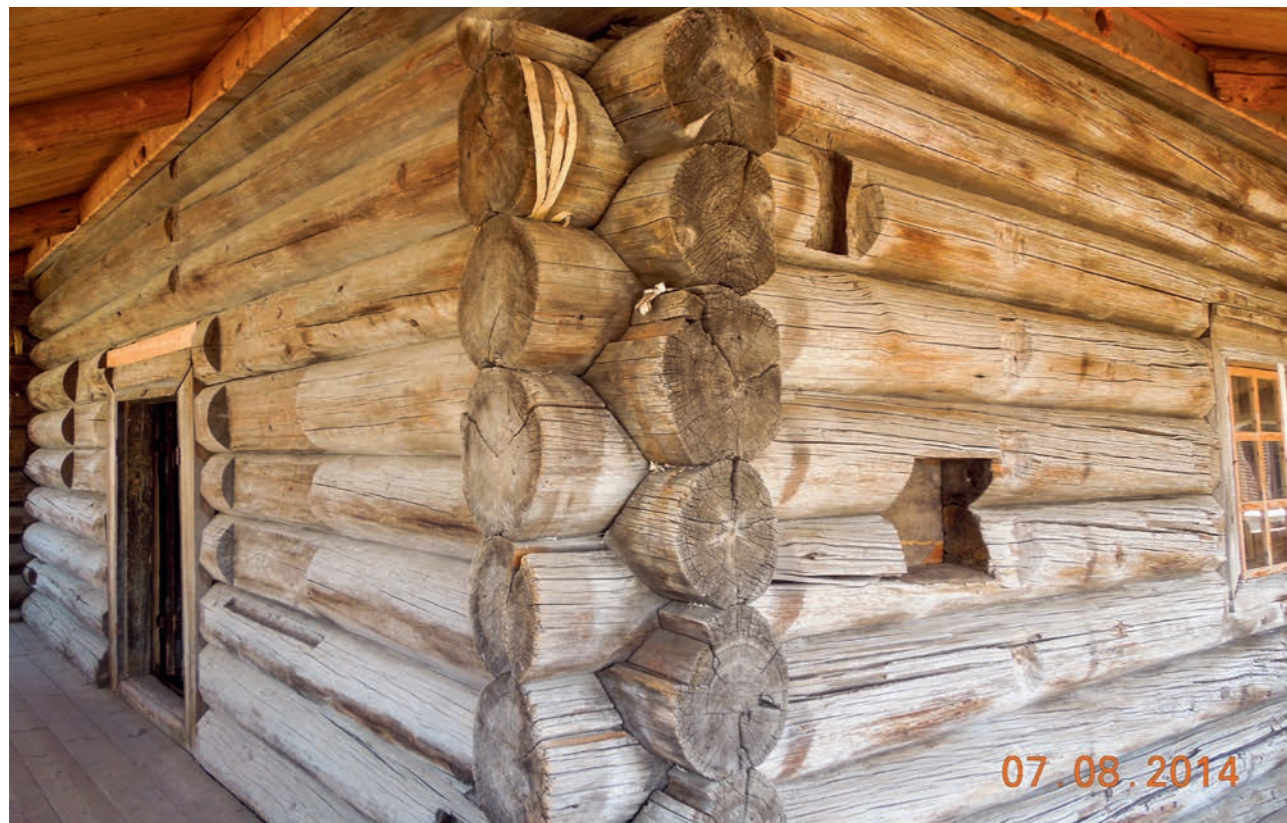
Рис. 8. Юго-западный угол трапезной Троицкой церкви. Фото 2014 г.
