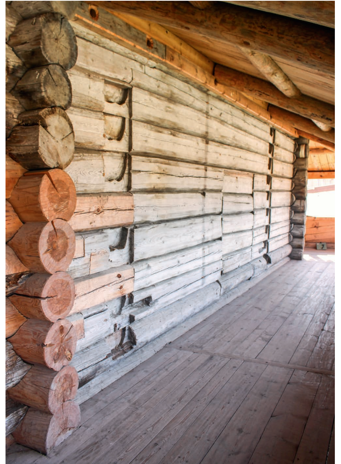
Рис. 9. Северная стена трапезной со следами примыкания придела и заложенной дверью. Фото 2015 г.
