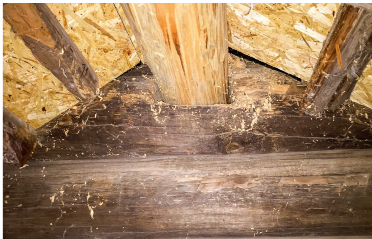
Рис. 57. Врубка коневой слези крыши алтаря в восточную стену храма. Фото 2016 г.
