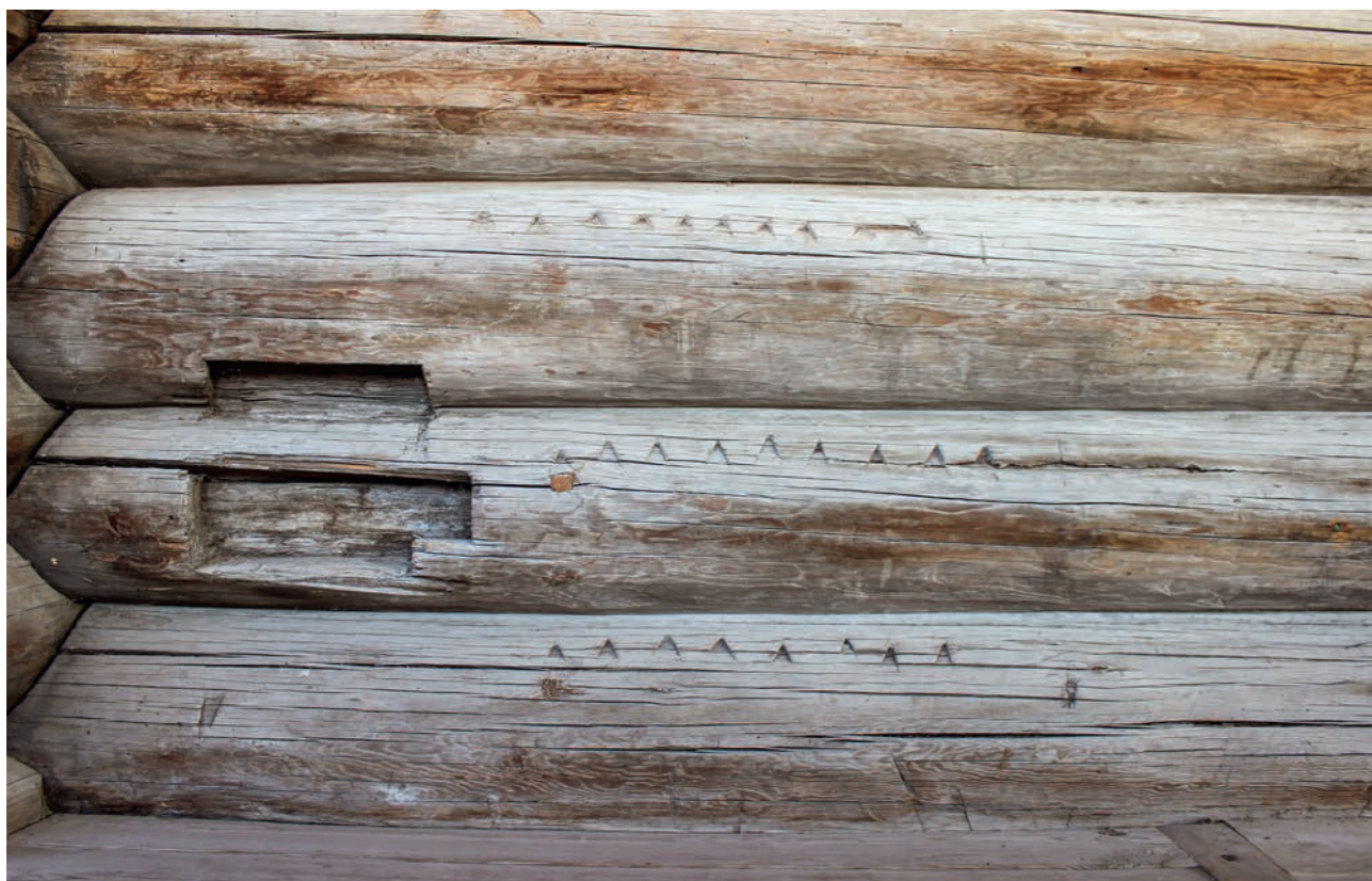
Рис. 18. Марки на западной стене трапезной. Фото 2016 г.
