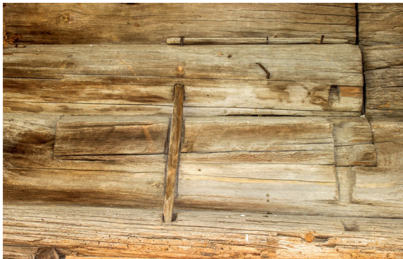
Рис. 94. Конструкция для крепления иконы над южной дверью. Фото 2015 г.
