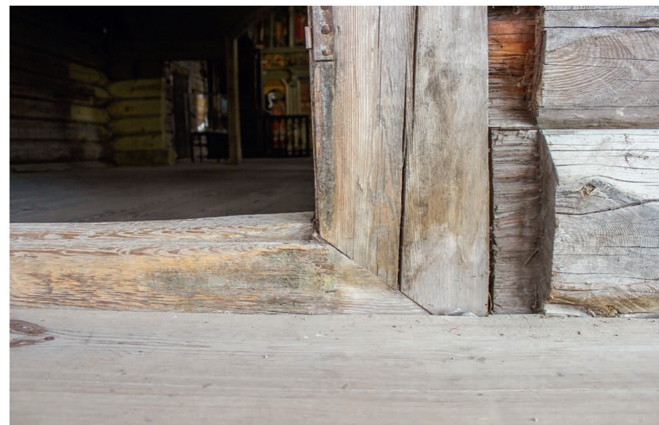
Рис. 113. Врубка для установки вертикальной опоры лавки возле западной двери справа (два уровня). Фото 2015 г.
