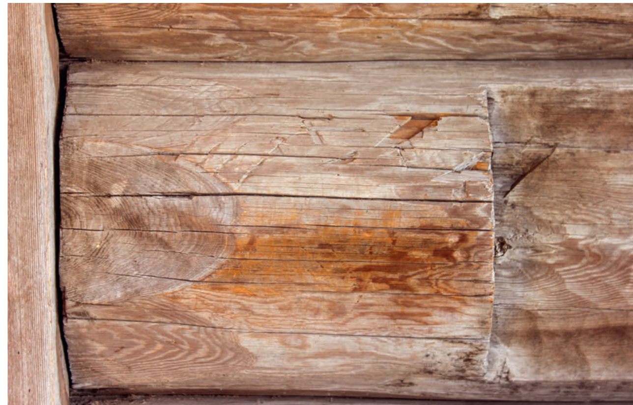
Рис. 19. Марки справа от двери на западной стене трапезной. Тройные затески возле западного дверного проема, частично уничтожившие маркировку. Фото 2016 г.
