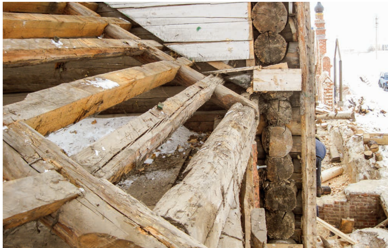
Рис. 52. Подкровельные конструкции алтаря. Фото 2011 г.
