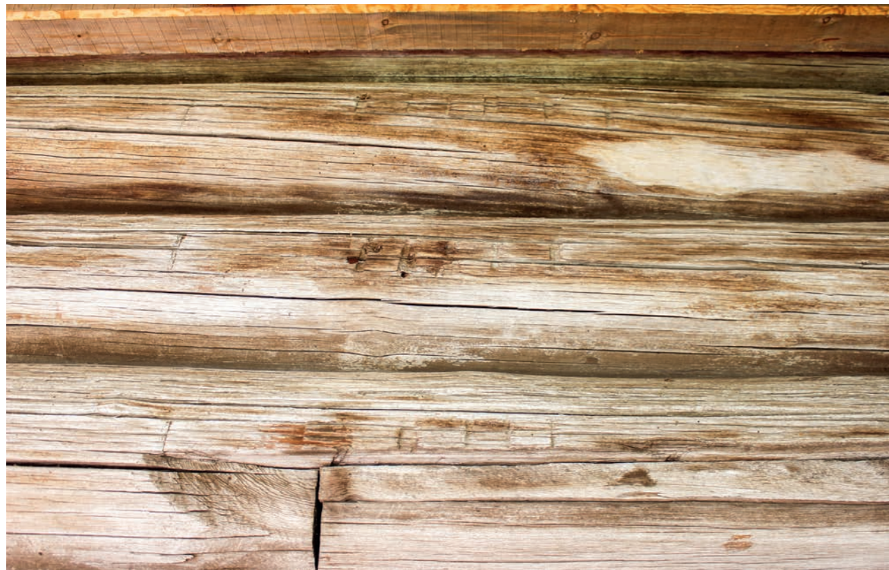
Рис. 25. Маркировка на южной стене трапезной с обозначением стопы
