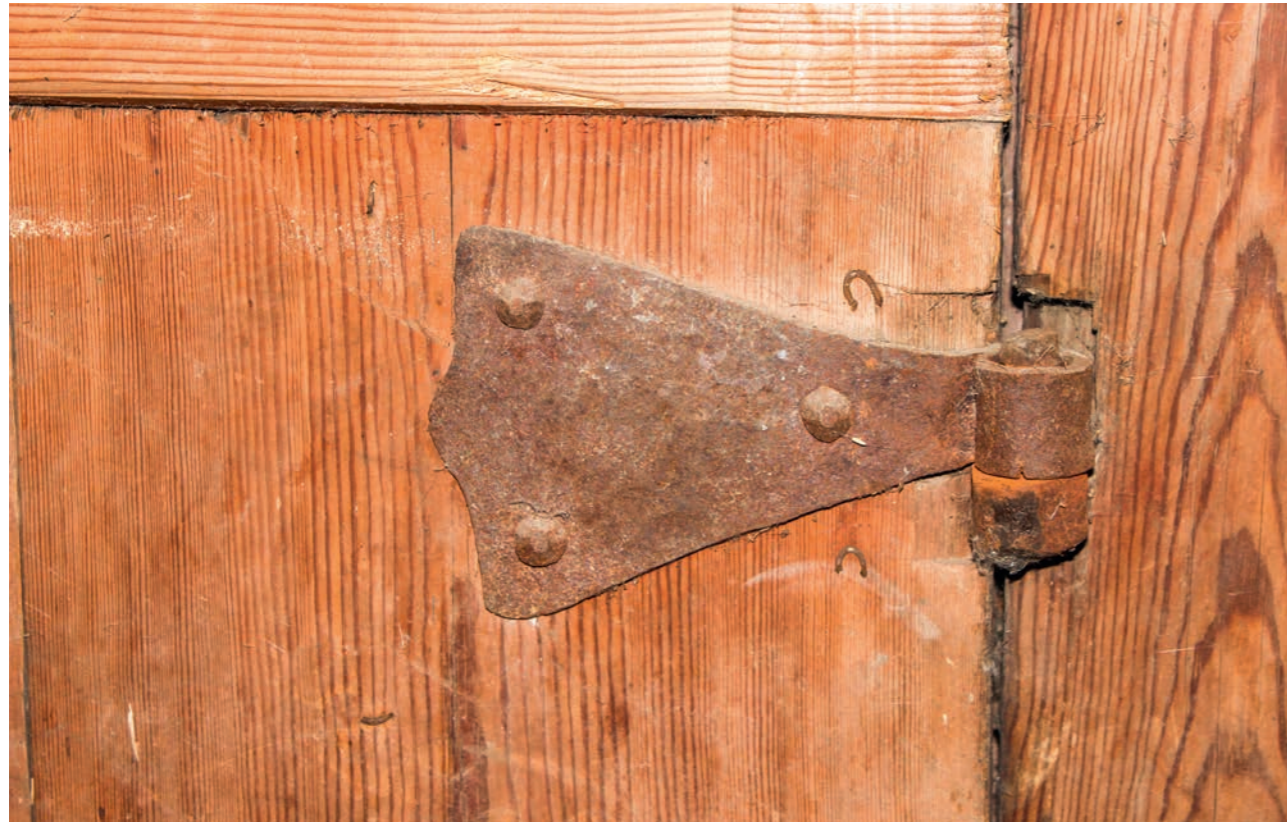
Рис. 96. Петля в виде гусиной лапки южной двери. Фото 2015 г.
