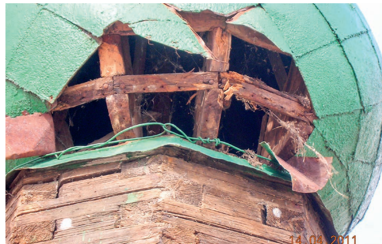
Рис. 74. Демонтаж металлического покрытия главы Троицкой церкви. Фото 2011 г.
