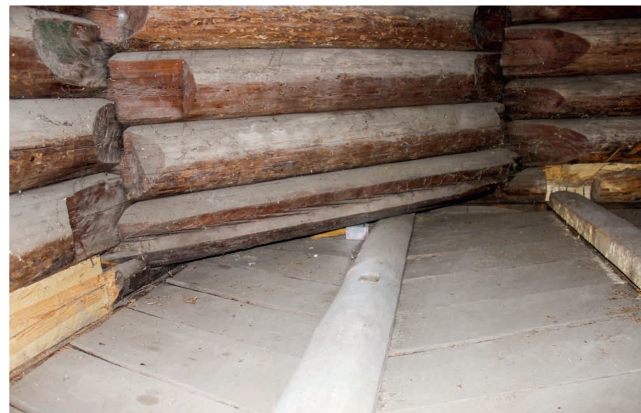
Рис. 45. Материал вторичного использования в конструкции большого восьмерика. Фото 2015 г.
