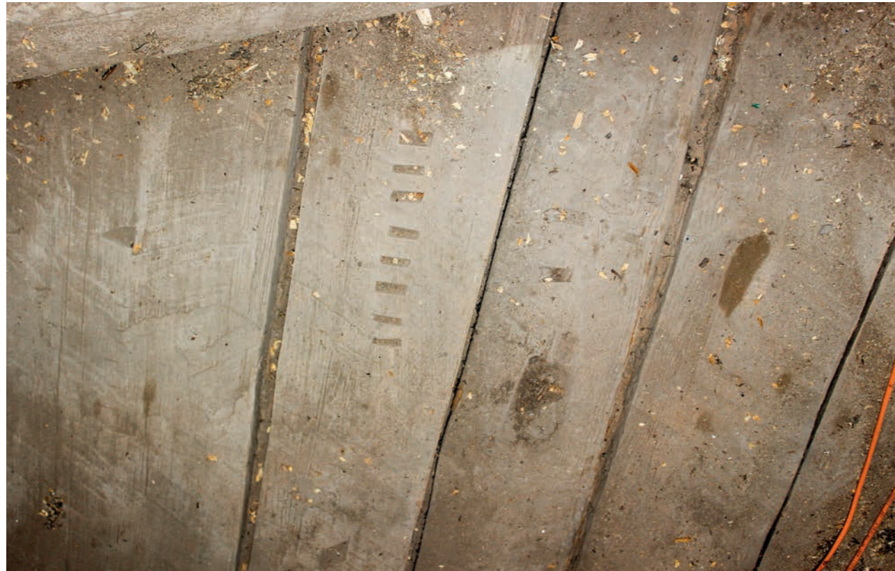
Рис. 35. Маркировка на тесинах потолка со стороны чердака. Фото 2016 г.
