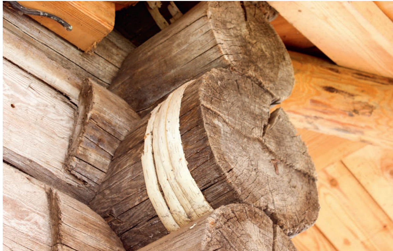
Рис. 7. Берестяные пояски на выпусках бревен сруба трапезной. Следы подтески для установки стоек западной паперти. Фото 2016 г.
