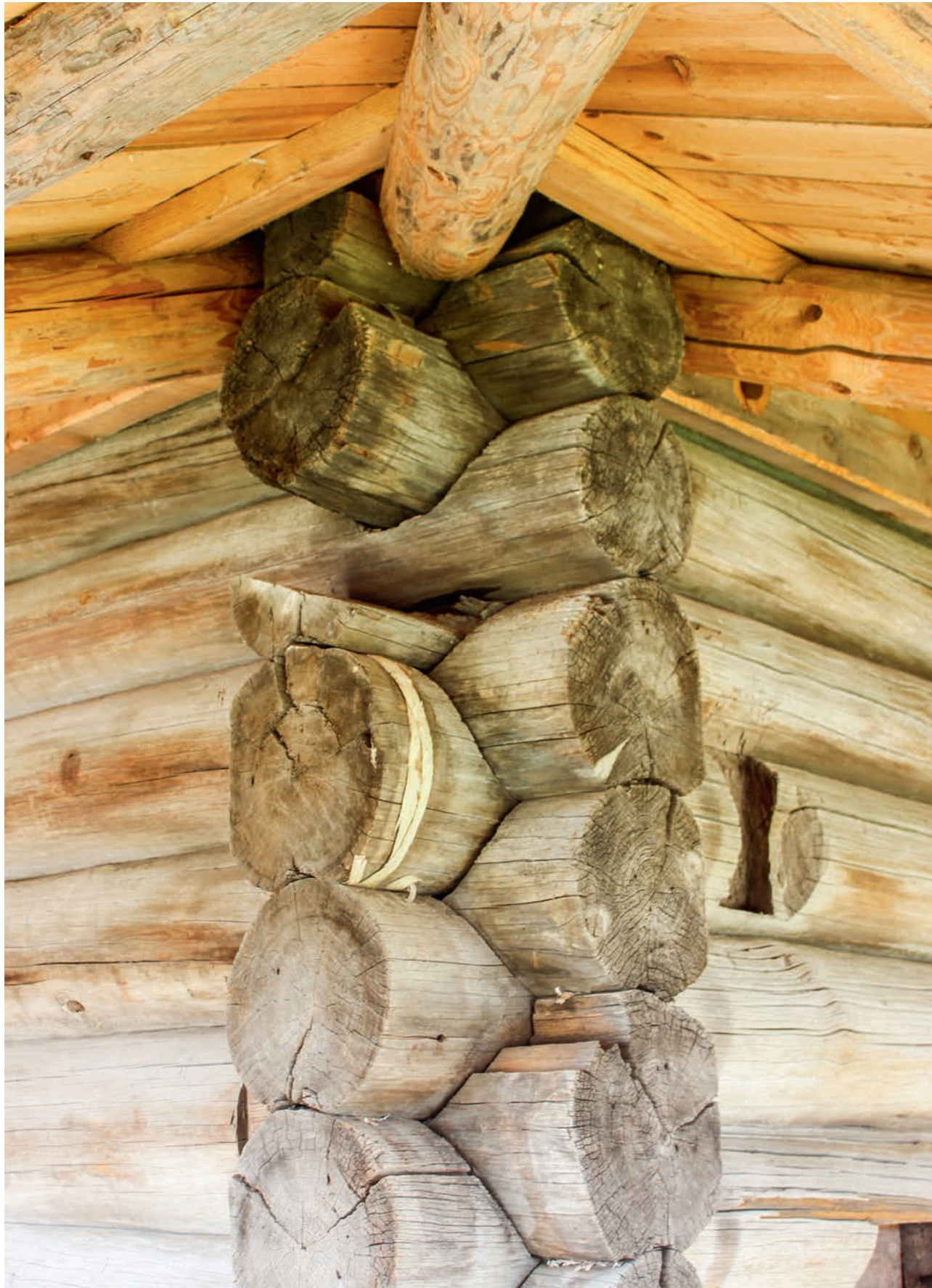
Рис. 106. Вырубленный выпуск бревна на юго-западном углу сруба трапезной для пропуска крыши первоначального крыльца. Фото 2015 г.
