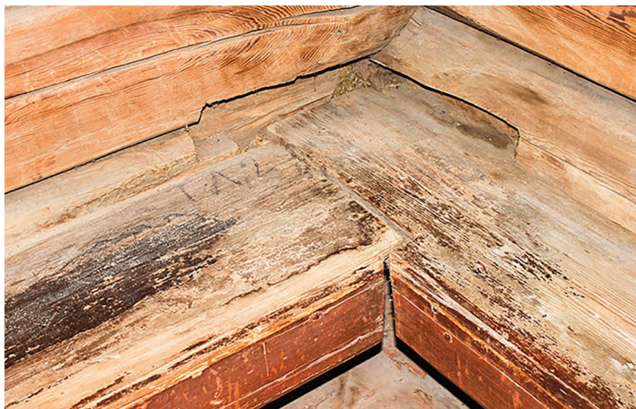
Рис. 119. Пристенные лавки в трапезной. Угловое соединение. Фото 2015 г.
