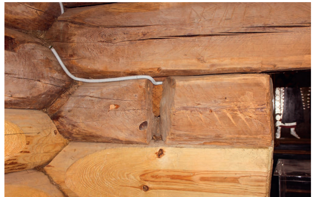
Рис. 16. Марки в северо-восточном углу со стороны трапезной на стене между основными объемами церкви. Попытка разруба стены между кафоликеном и трапезной. Фото 2016 г.
