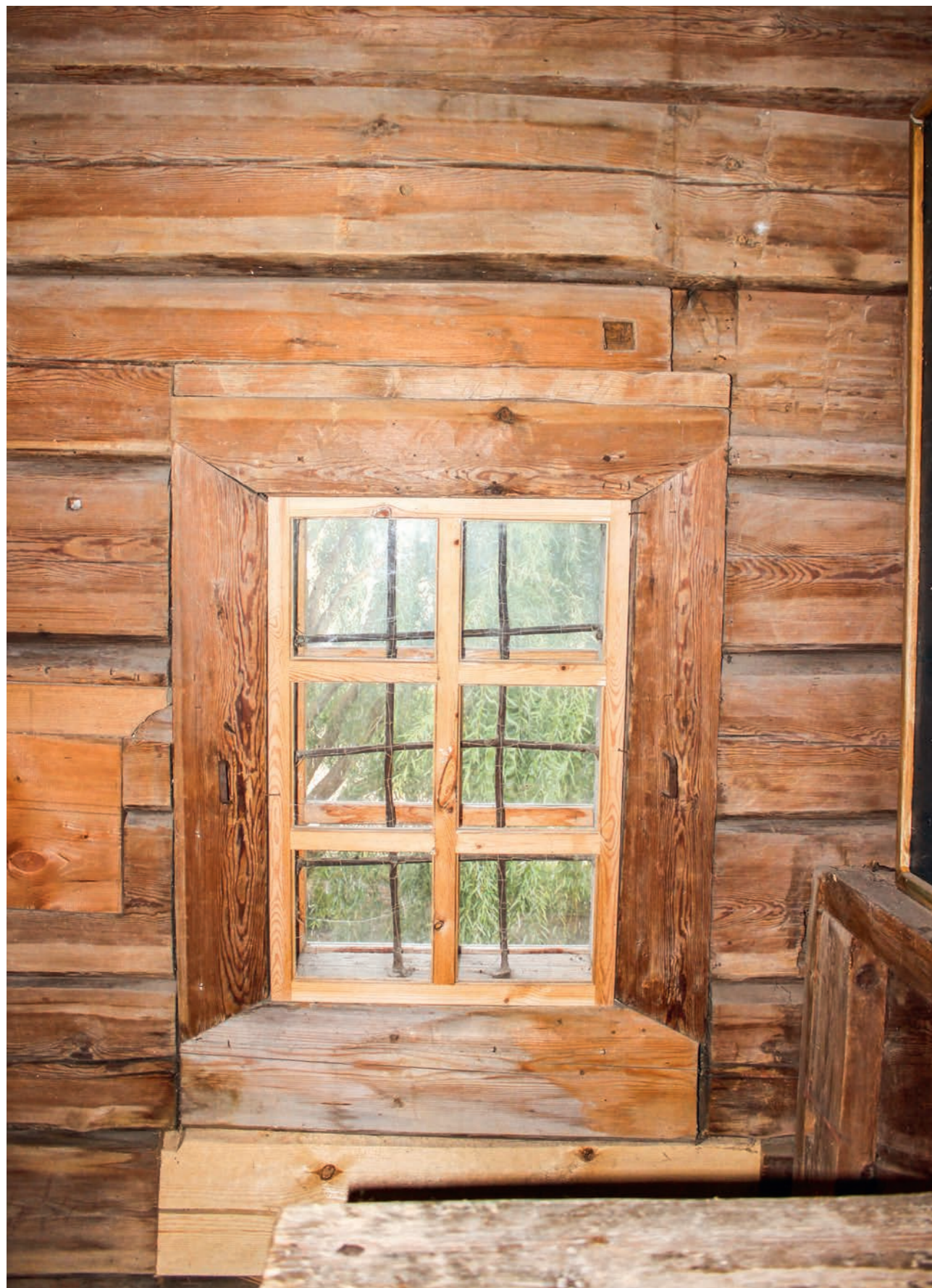
Рис. 90. Косячатое окно в южной стене храма. Фото 2015 г.
