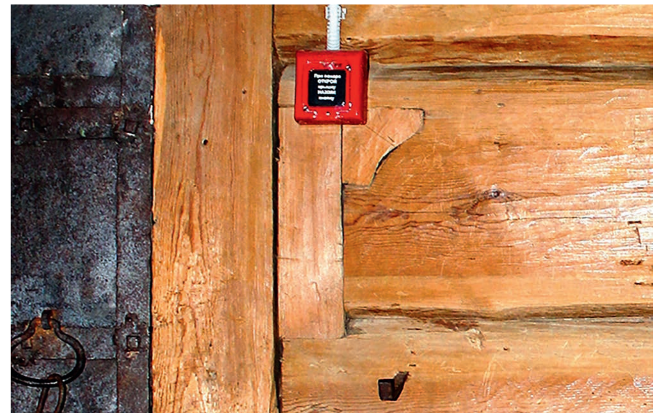
Рис. 86. Остаток волокового окна в северной стене кафоликона. Фото 2015 г.
