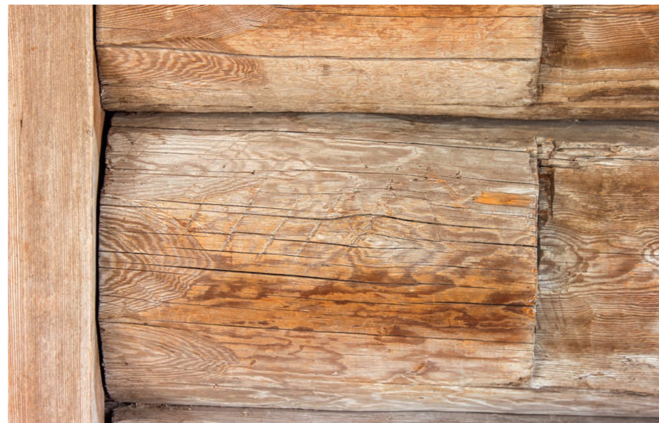
Рис. 20. Марки справа от двери на западной стене трапезной. Затески возле западного дверного проема. Фото 2016 г.
