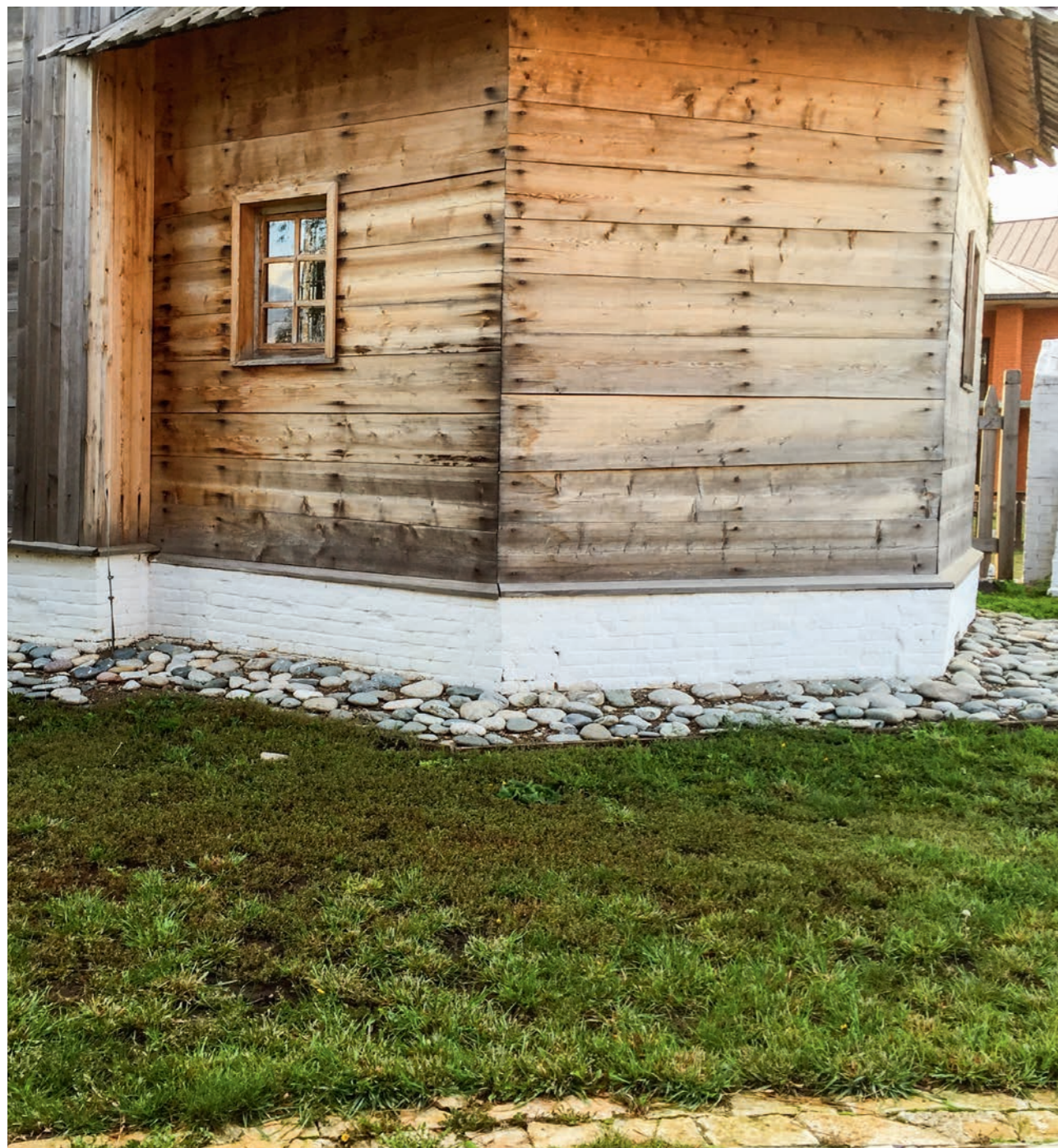
Рис. 43. Видимая часть цоколя Троицкой церкви с внешней стороны. Фото 2016 г.
