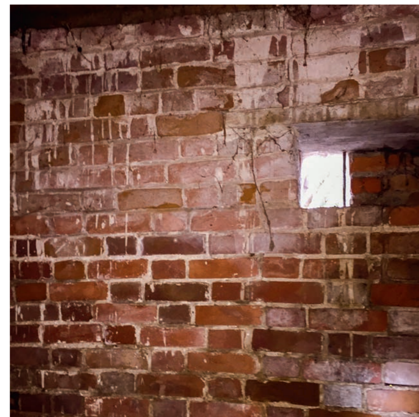
Рис. 42. Кирпичная кладка цоколя Троицкой церкви. Фото 2016 г.
