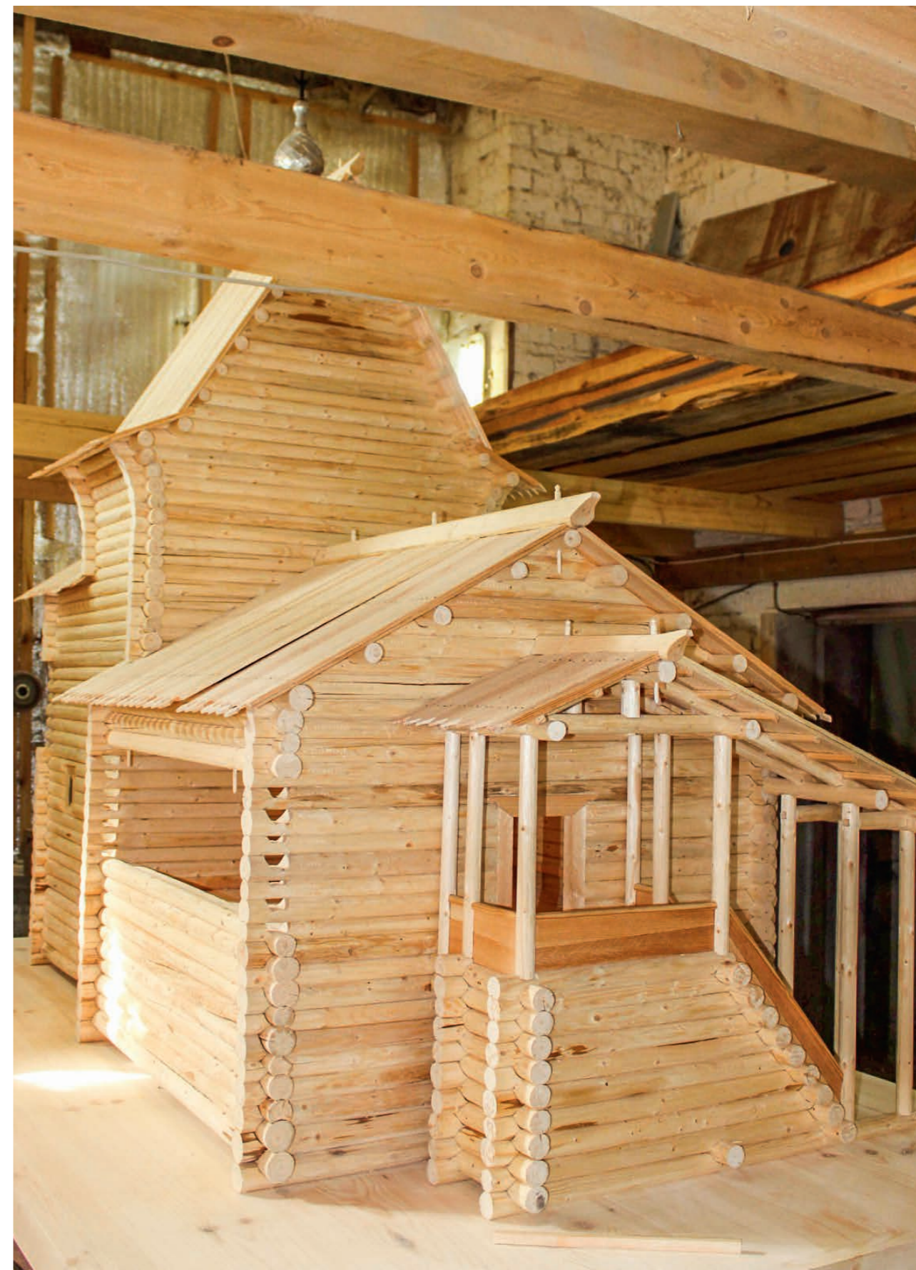
Рис. 109. Троицкая церковь с пристроенным с запада крыльцом. Реконструкция на первый этап строительства. Макет 1:10. Фото 2016 г.
