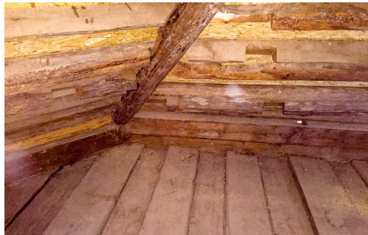
Рис. 58. Конструкция крыши алтаря с введенной страховочной кровлей из ОСП. Фото 2016 г.
