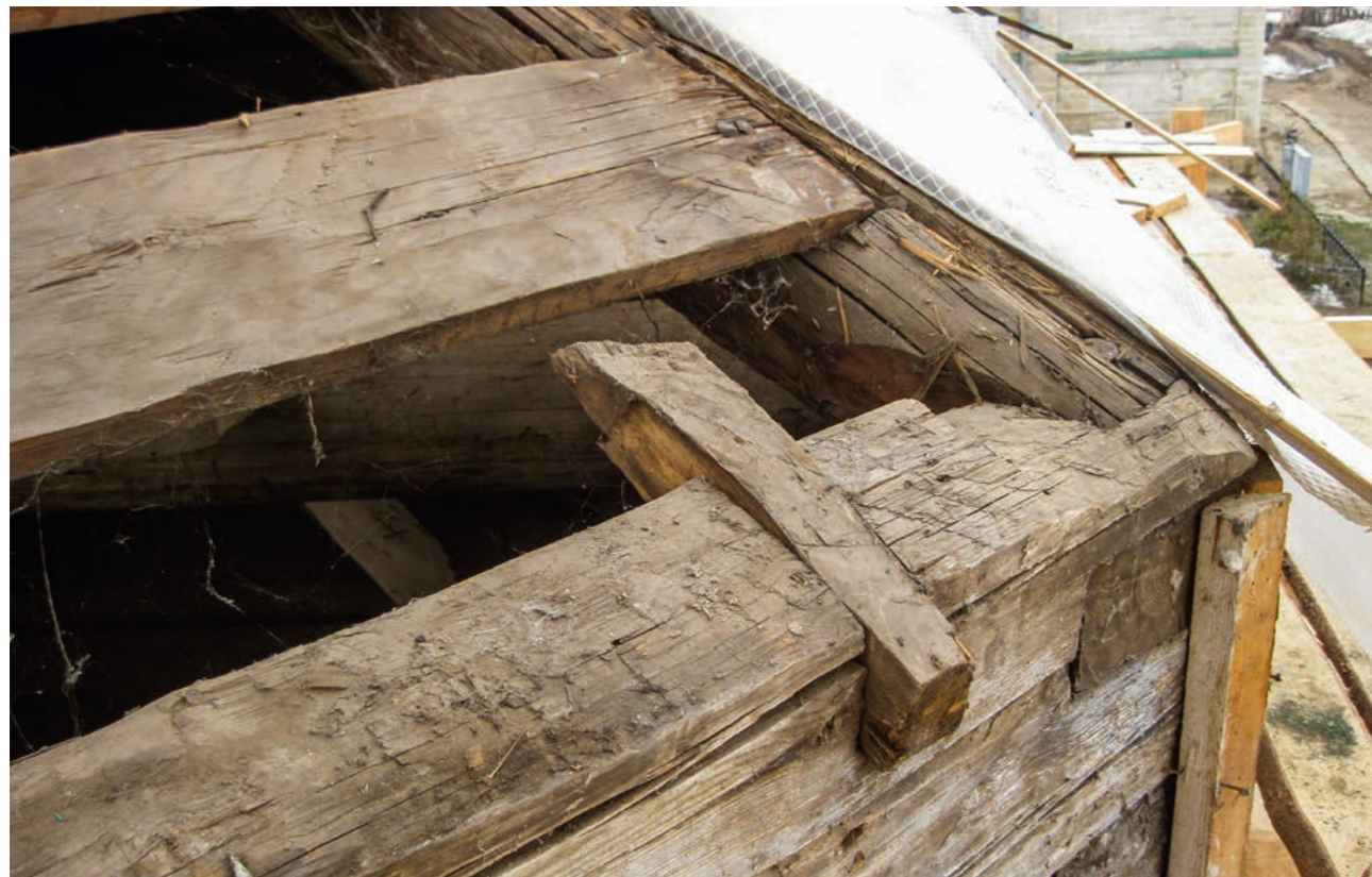
Рис. 56. Кобылка, вставленная в паз в обвязочном венце сруба алтаря. Фото 2011 г.
