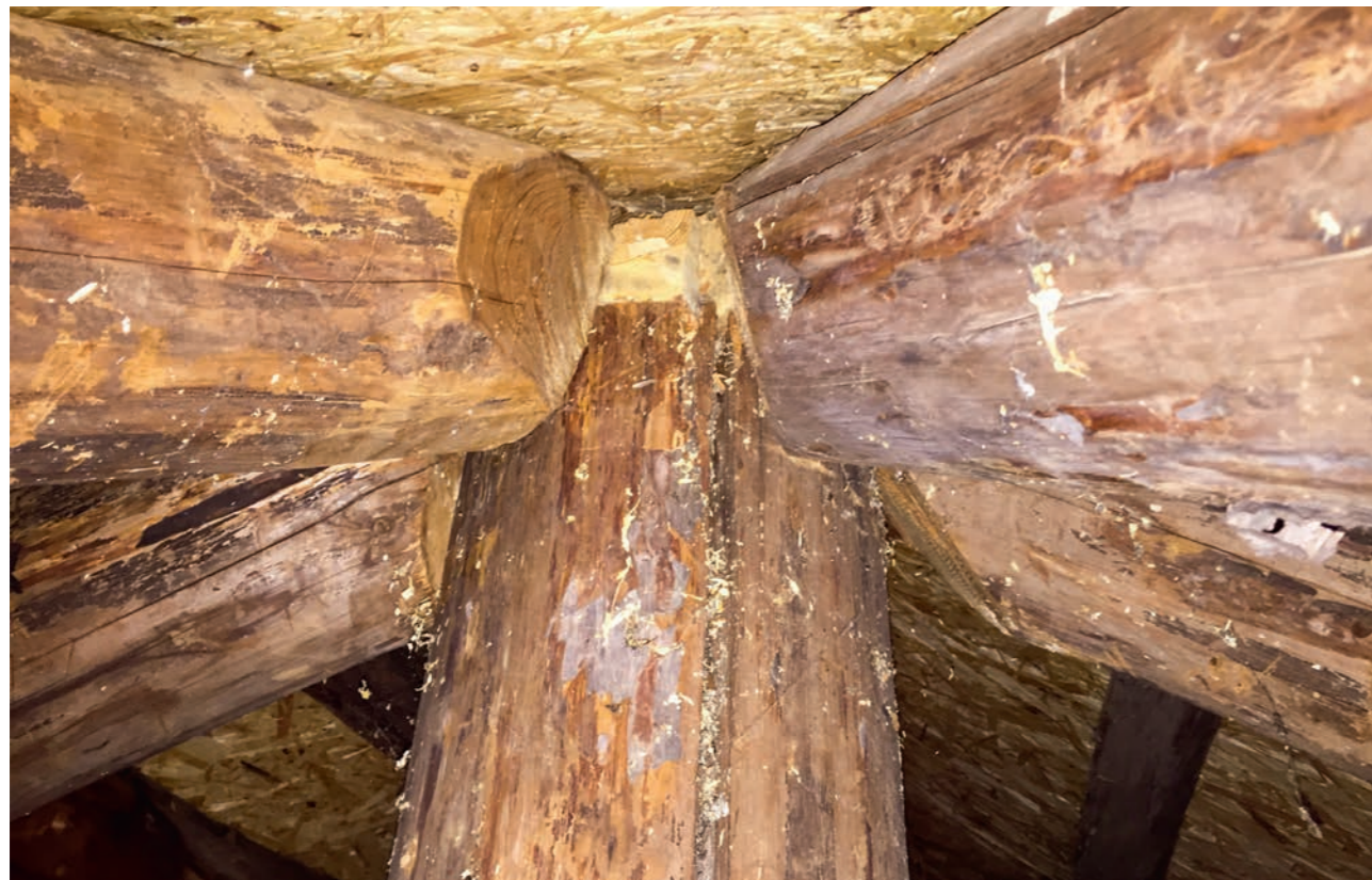
Рис. 60. Опора крыши алтаря и подходящие к ней слези. Фото 2016 г.
