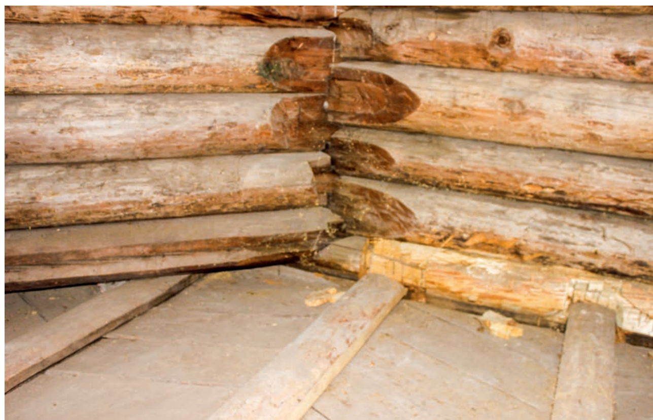
Рис. 61. Новые балки перекрытия кафоликона. Фото 2016 г.
