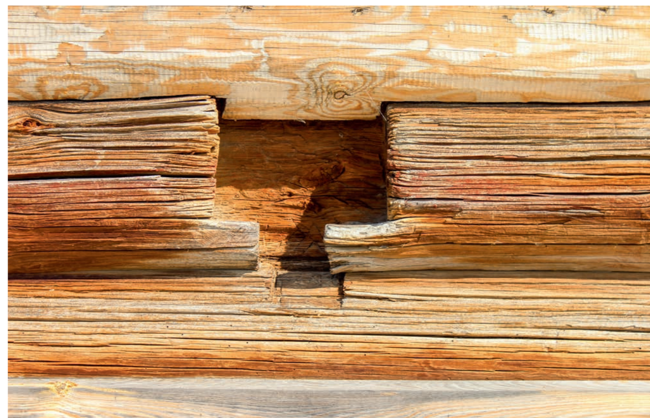
Рис. 105. Гнездо для коневой слеги крыльца на западном фасаде трапезной, позже разрубленное для установки слеги крыши паперти. Фото 2015 г.
