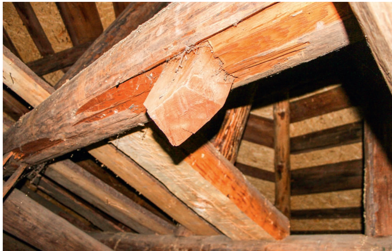
Рис. 49. Элементы конструкции в основании малого восьмигранника. Фото 2015 г.
