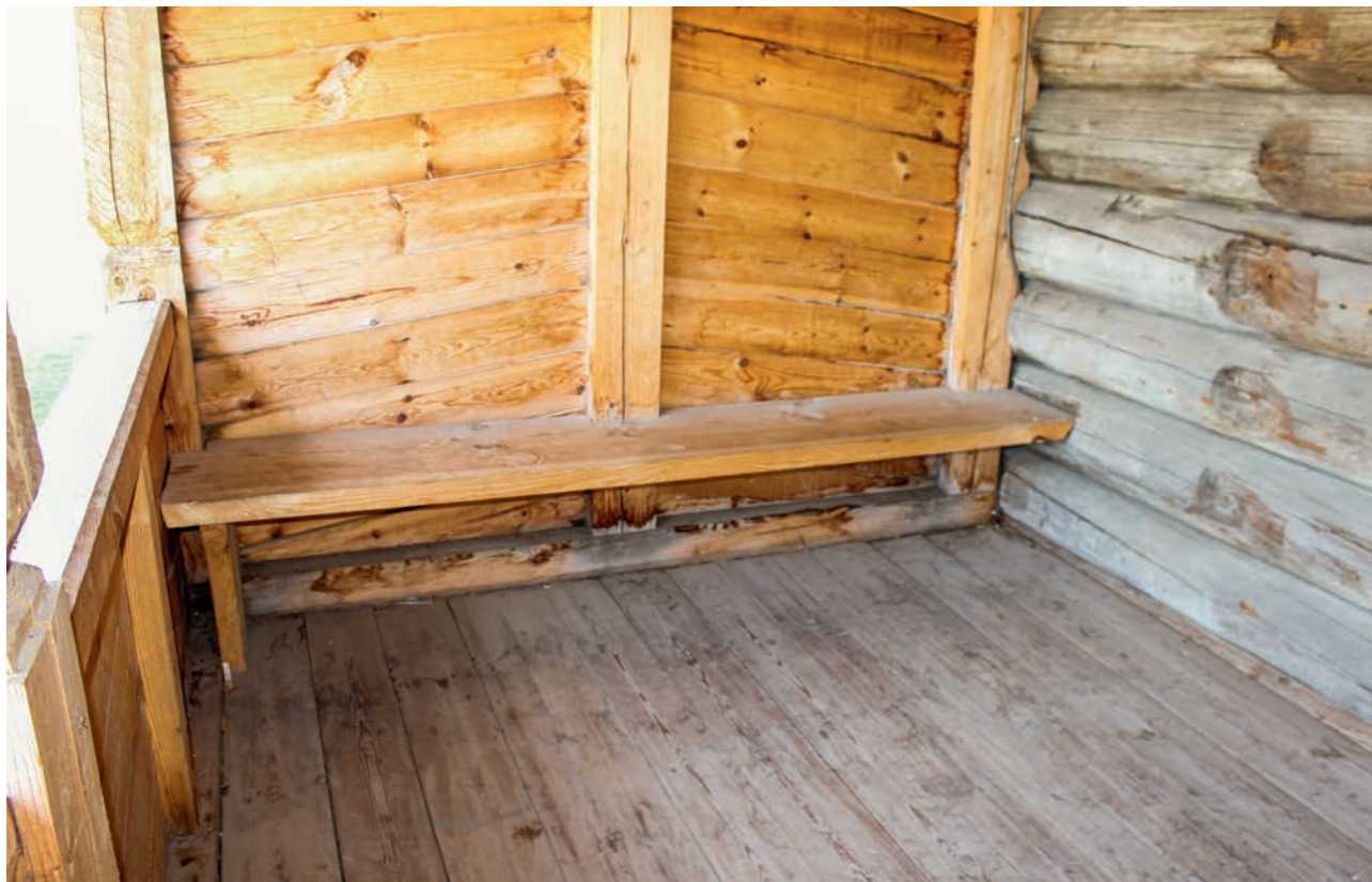
Рис. 114. Скамья в северном крыле галереи, установленная в имевшийся паз в бревне северной стены. Фото 2015 г.
