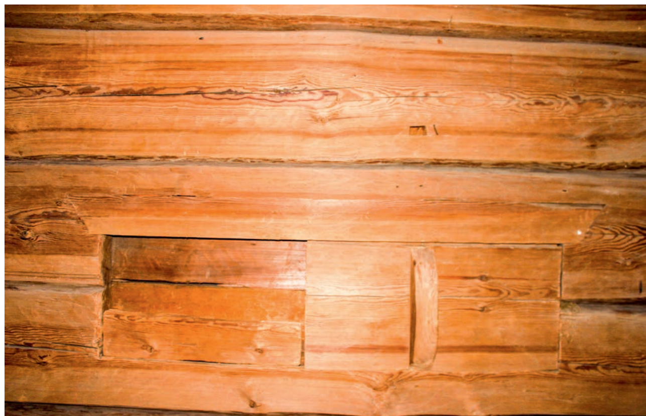
Рис. 84. Волоковое окно (южная стена трапезной, в юго-западном углу). Фото 2015 г.
