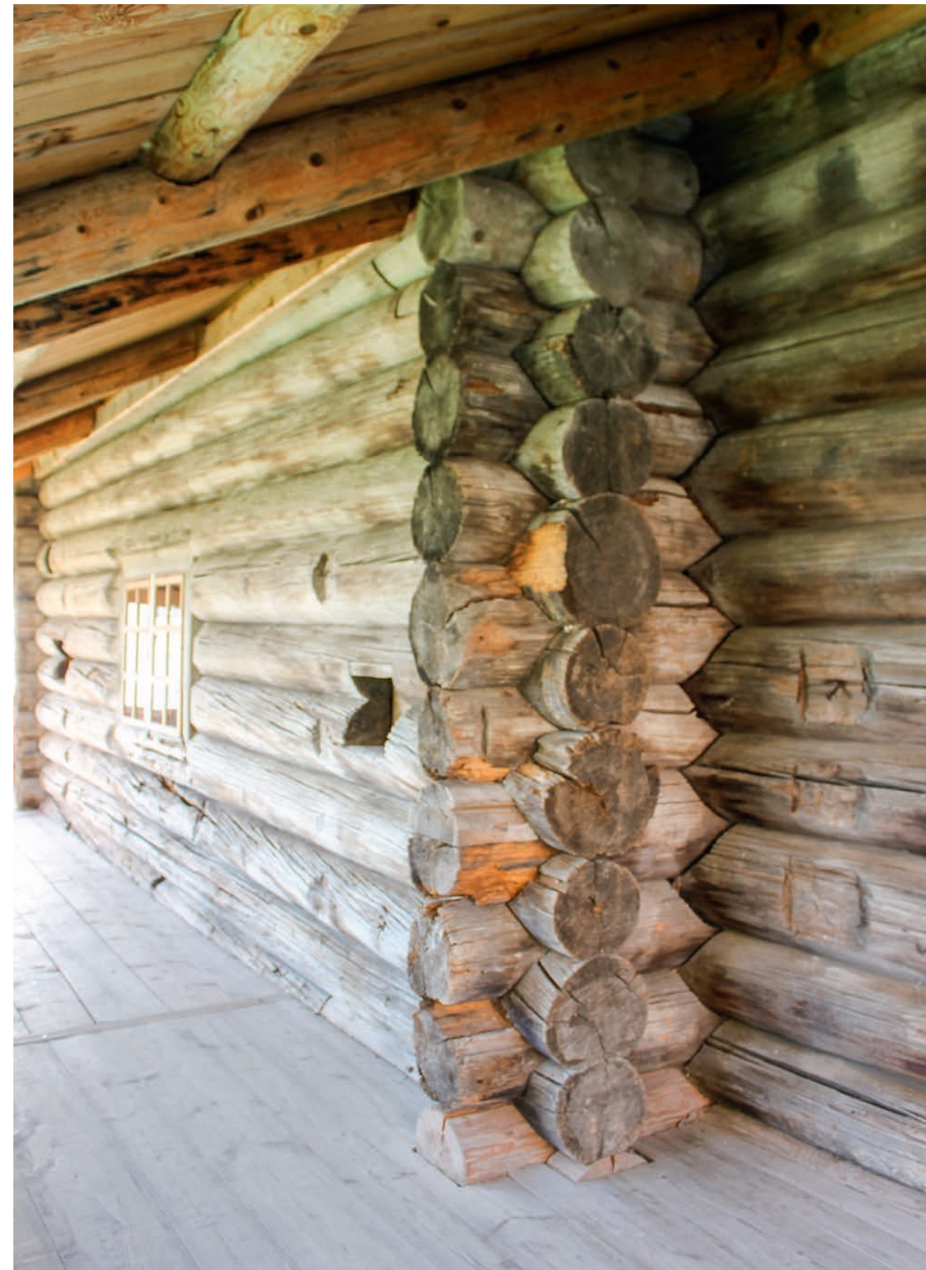
Рис. 6. Угловое соединение «в чашу с остатком» южной стены трапезной и стены, общей для кафоликона и трапезной. Фото 2016 г.
