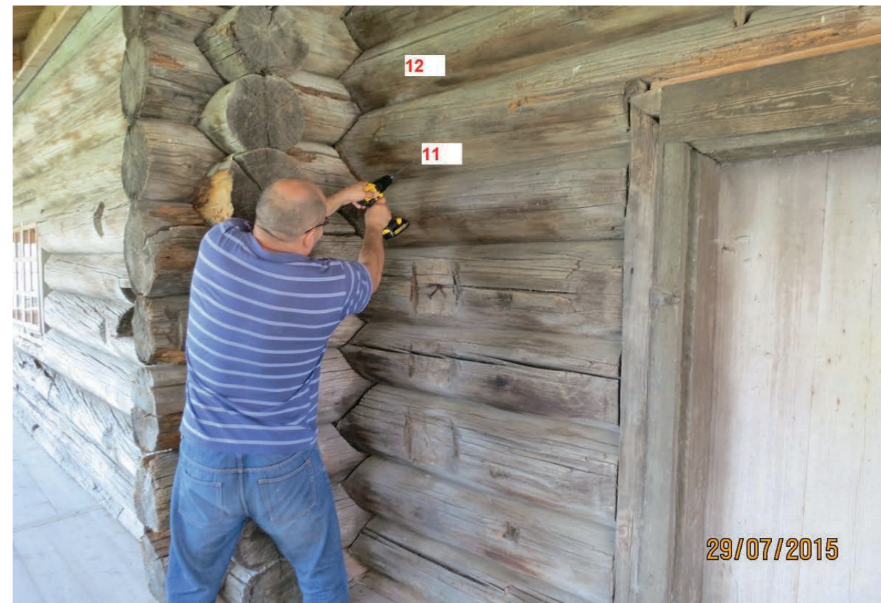
Рис. 7. Южный фасад храмовой части церкви, TR11, TR12 (фото 2015 года)
