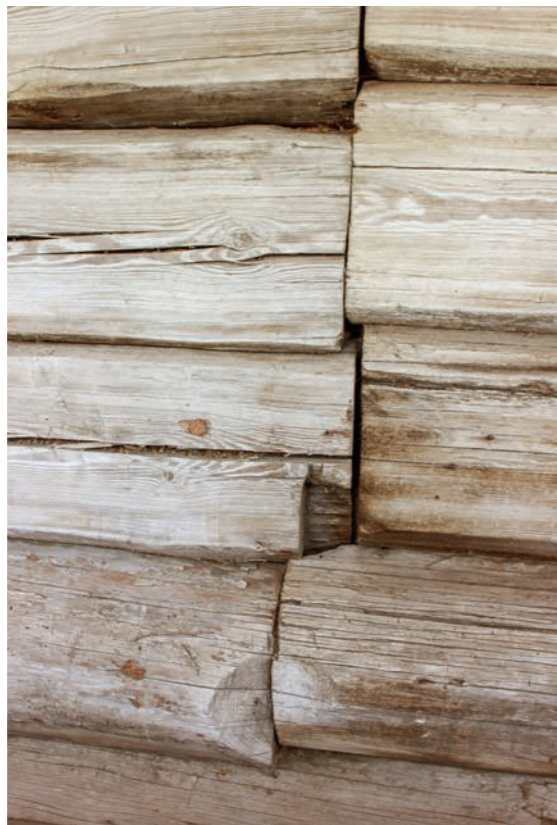
Рис. 10. Вырубка возле левого косяка двери придела для установки вертикальной опоры лавки, шедшей вдоль внешней стороны северной стены трапезной. Фото 2015 г.
