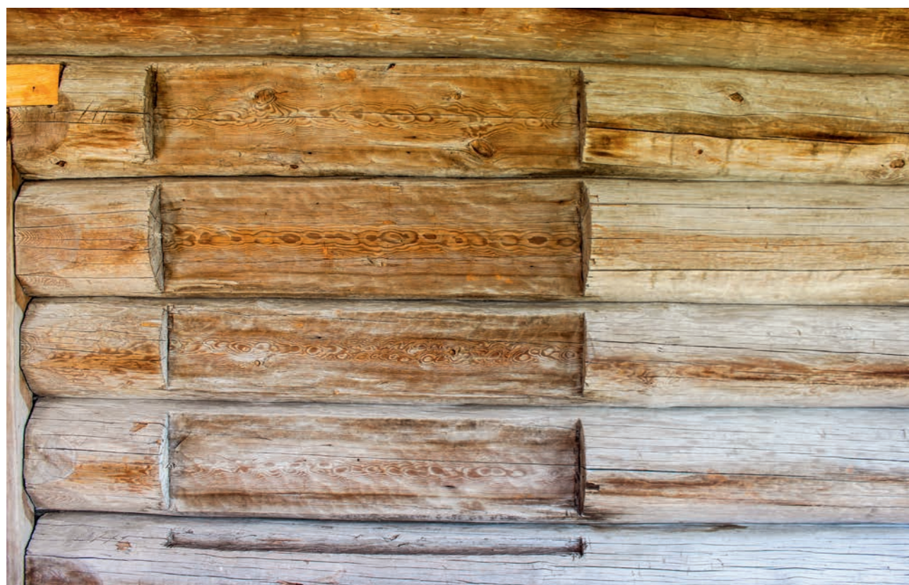
Рис. 111. Ниша для установки киота с иконой на западной стене трапезной, справа от дверного проема. Фото 2015 г.
