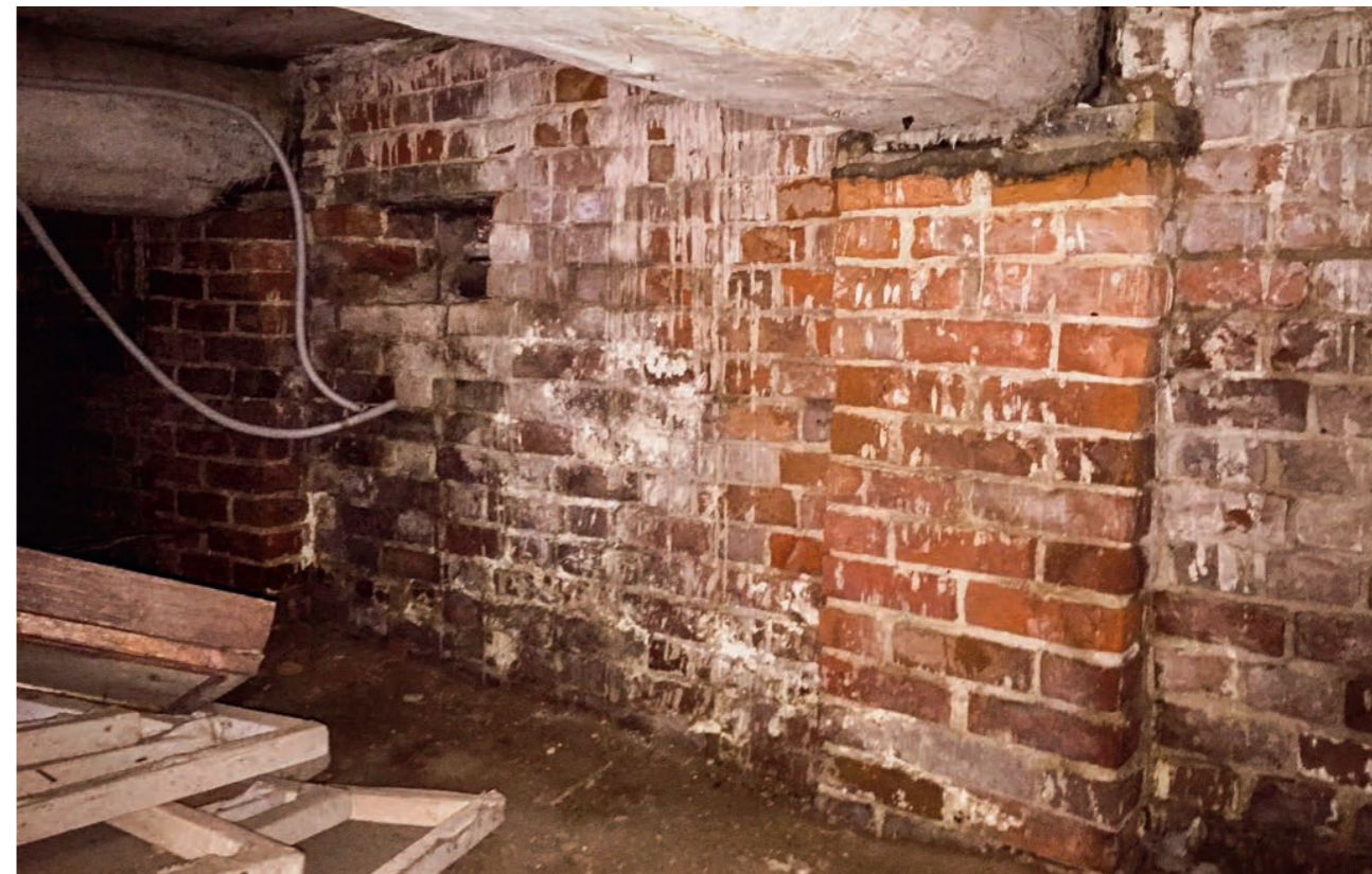
Рис. 41. Троицкая церковь. Цоколь. Вынос кладки для опоры балок перекрытия. Фото 2016 г.
