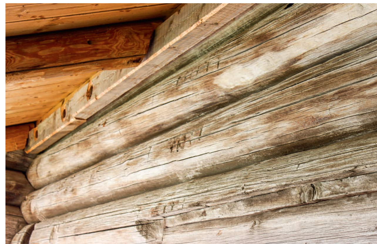
Рис. 24. Маркировка на южной стене трапезной. Фото 2016 г.
