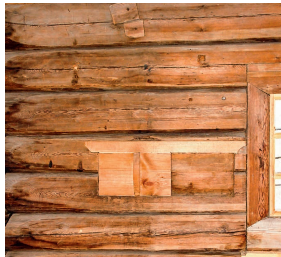
Рис. 82. Волоковое окно (южная стена кафоликона). Фото 2015 г.
