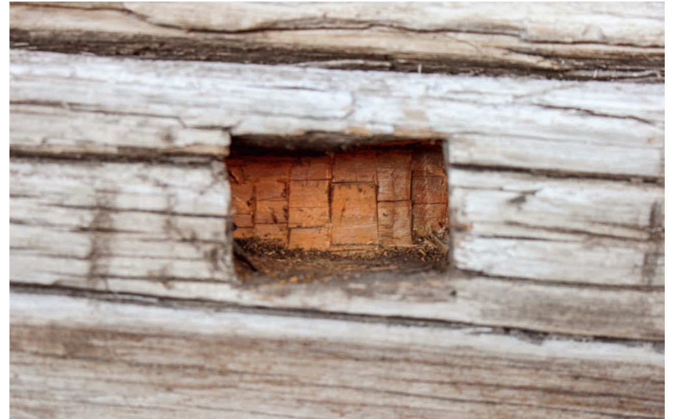
Рис. 37. Гнездо для опоры-«пальца» подмостей. Фото 2015 г.
