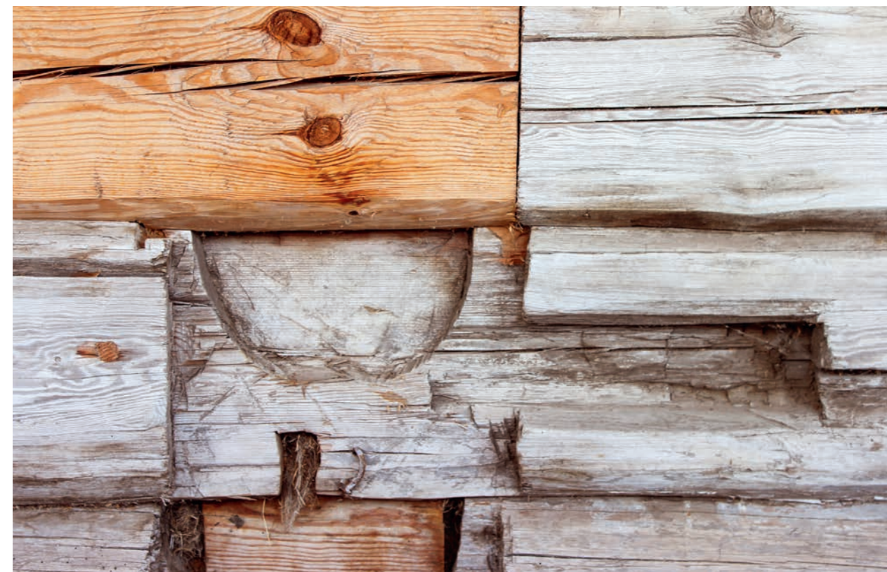
Рис. 13. Северная стена трапезной. Паз для установки лавки в приделе, шедшей вдоль его восточной стены. Фото 2015 г.
