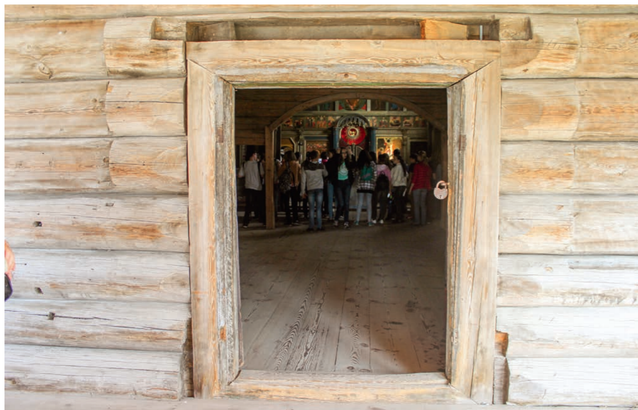
Рис. 97. Западный дверной проем. Затески. Врубки для установки опор лавок. Фото 2011 г.
