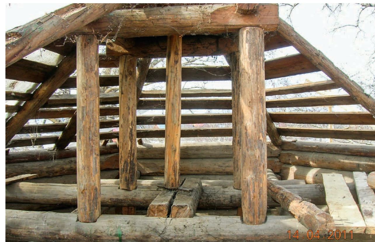
Рис. 48. Конструкция в основании малого восьмика. Фото 2011 г.
