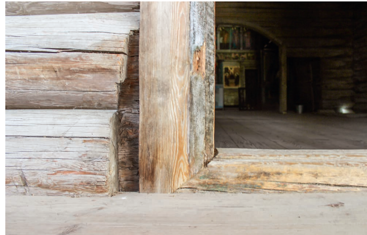
Рис. 112. Врубка для установки опоры лавки возле западной двери слева (два уровня). Фото 2015 г.
