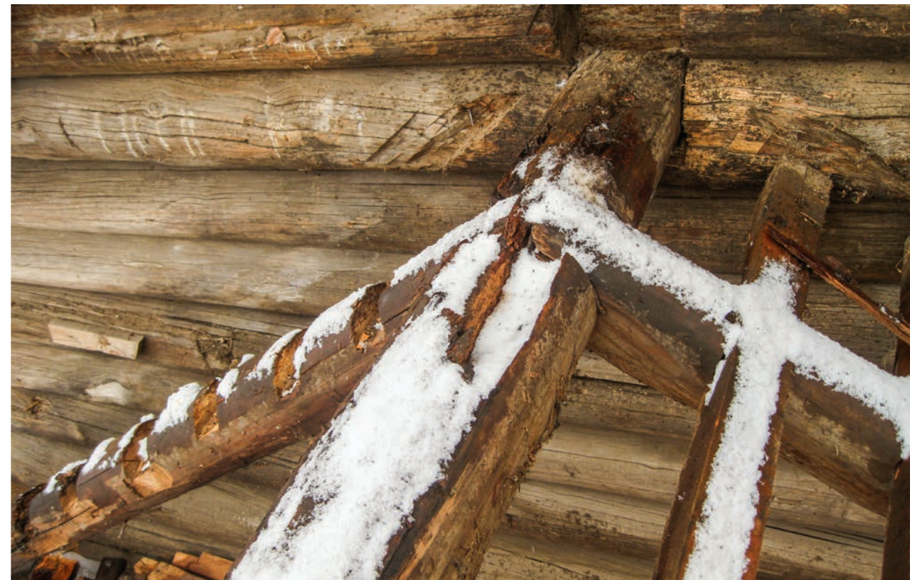
Рис. 54. Новый уровень коневой слеги крыши алтаря. Фото 2011 г.
