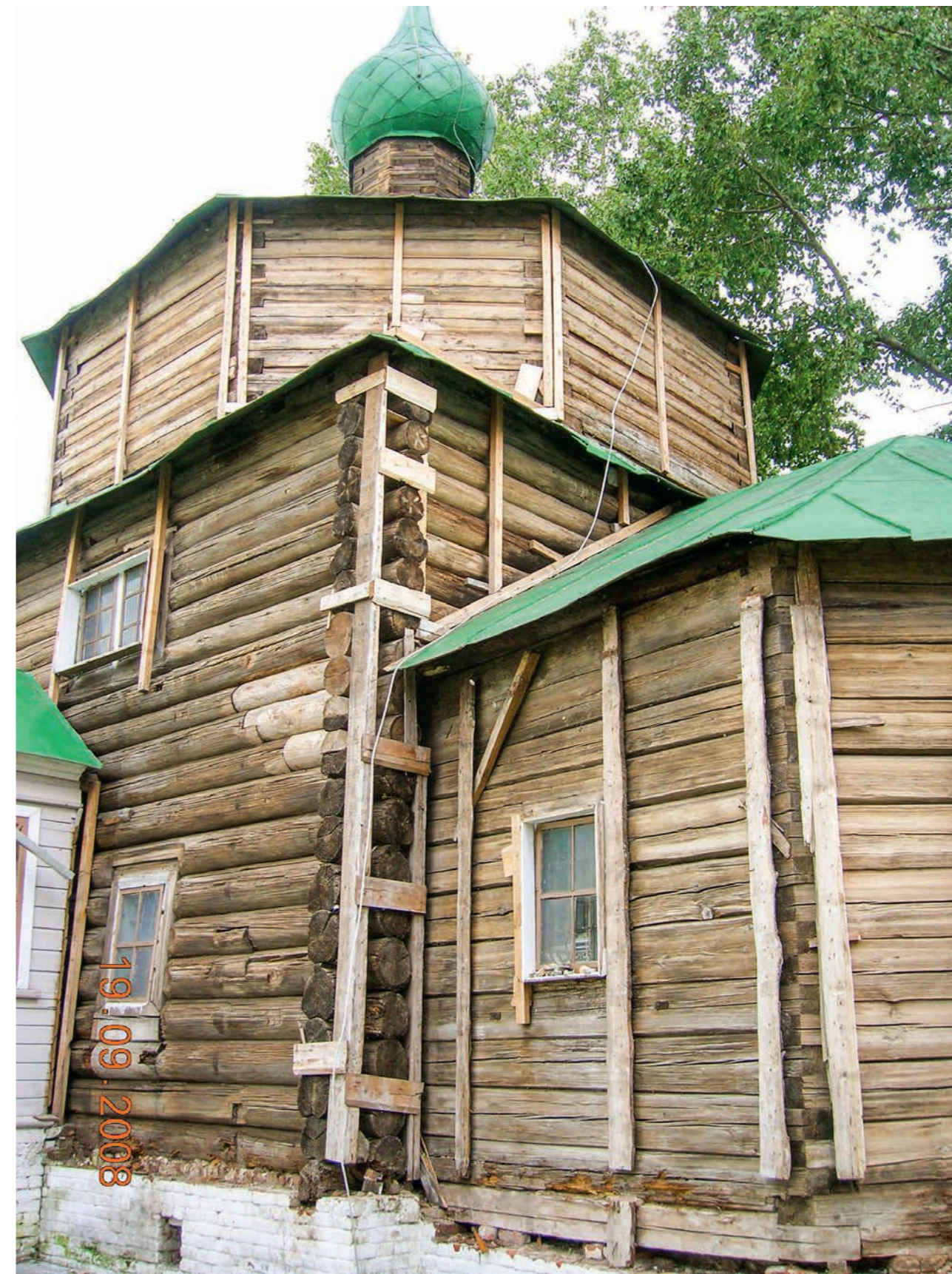
Рис. 128. Различие в обработке материала первоначальной храмовой части и пристроенных алтарной апсиды и восьмериков. Фото 2008 г.
