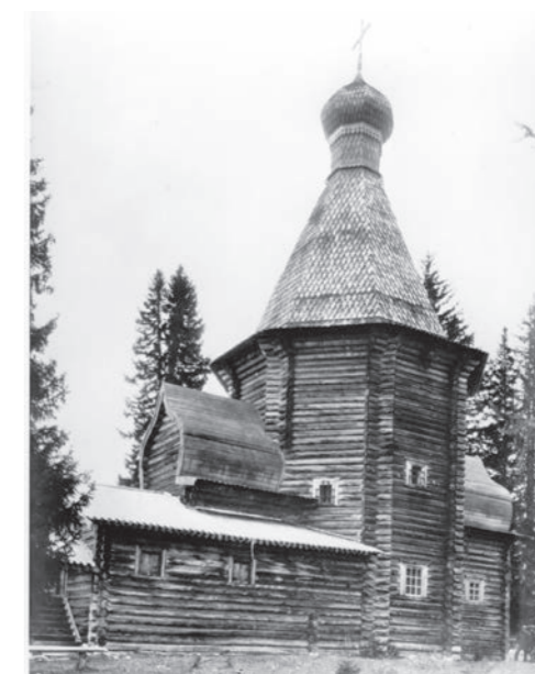
Рис. 203. Никольская церковь в с. Панилово. Вид с юго-запада. ИИАК. Начало XX в.
