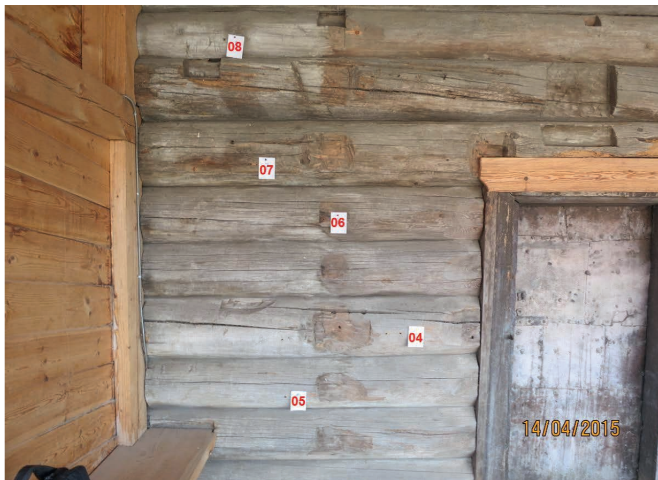
Рис. 6. Северный фасад храмовой части церкви, TR04-08 (фото 2015 года)
