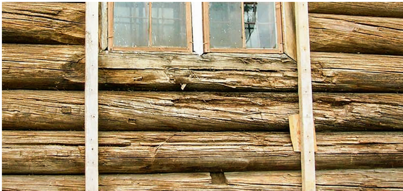
Рис. 39. Гнезда от вспомогательной строительной конструкции лесов (подмостей) под окном трапезной. Фото 2008 г.
