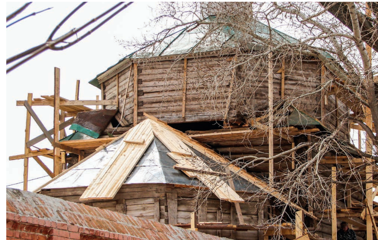
Рис. 70. Ремонт кровли над алтарем (ложные доски, ОСП, рубероид). Фото 2011 г.
