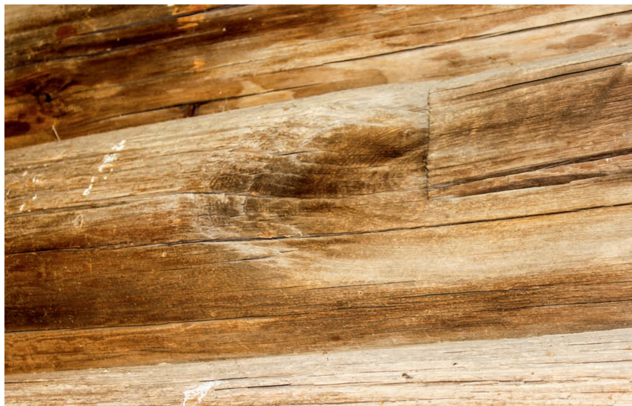
Рис. 88. Подтесок заложеного «красного» окна в южной стене кафоликона. Фото 2015 г.
