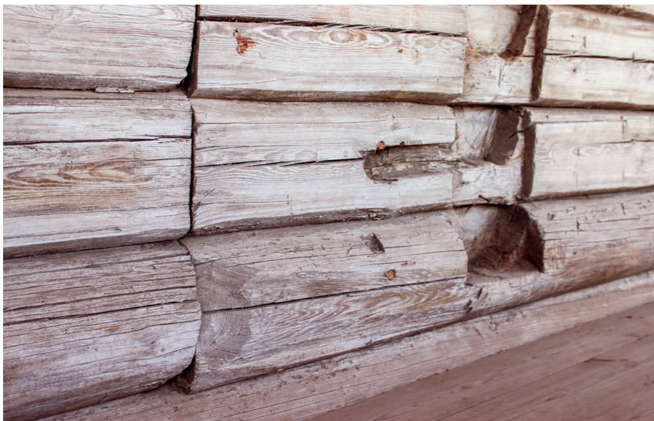
Рис. 11. Паз для установки лавки вдоль западной стены придела. Одинарная затеска на пороговом бревне северного дверного проема трапезной. Фото 2015 г.
