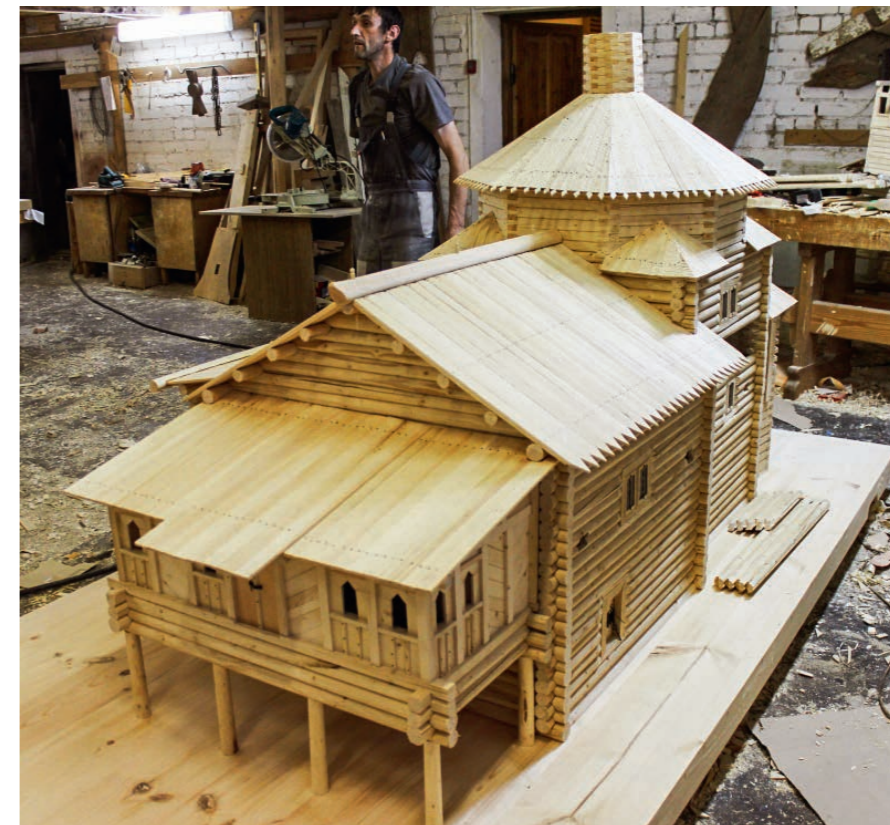
Рис. 81. Реконструкция. Троицкая церковь на момент перестройки с полной переборкой. Модель 1:10. Фото 2016 г.
