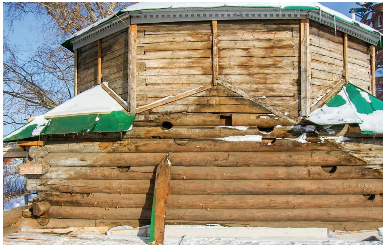
Рис. 68. Следы различных уровней подкровельных конструкций над трапеznой. Фото 2011 г.
