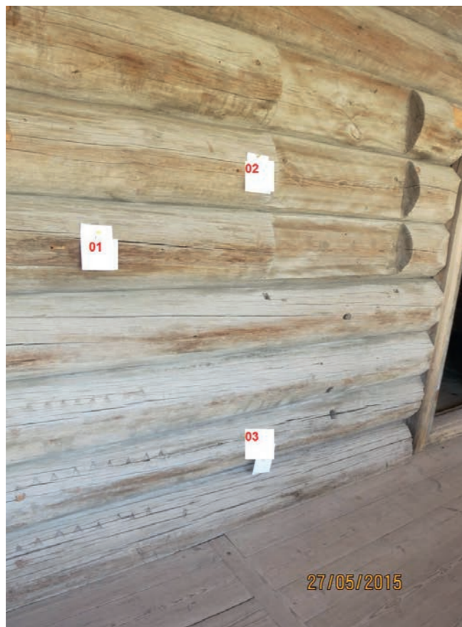
Рис. 5. Западный фасад трапезной части церкви, TR01–03 (фото 2015 года)
