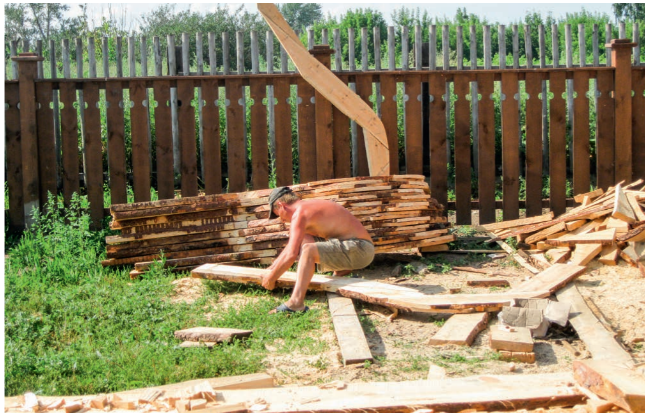
Рис. 79. Изготовление журавцов для новой главы. Фото 2011 г.
