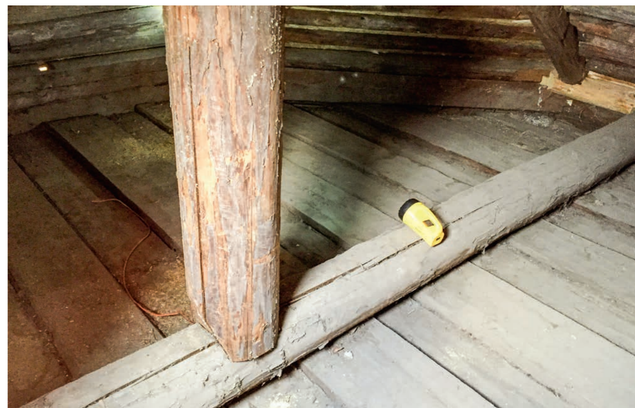
Рис. 59. Центральная опора крыши алтаря. Фото 2016 г.
