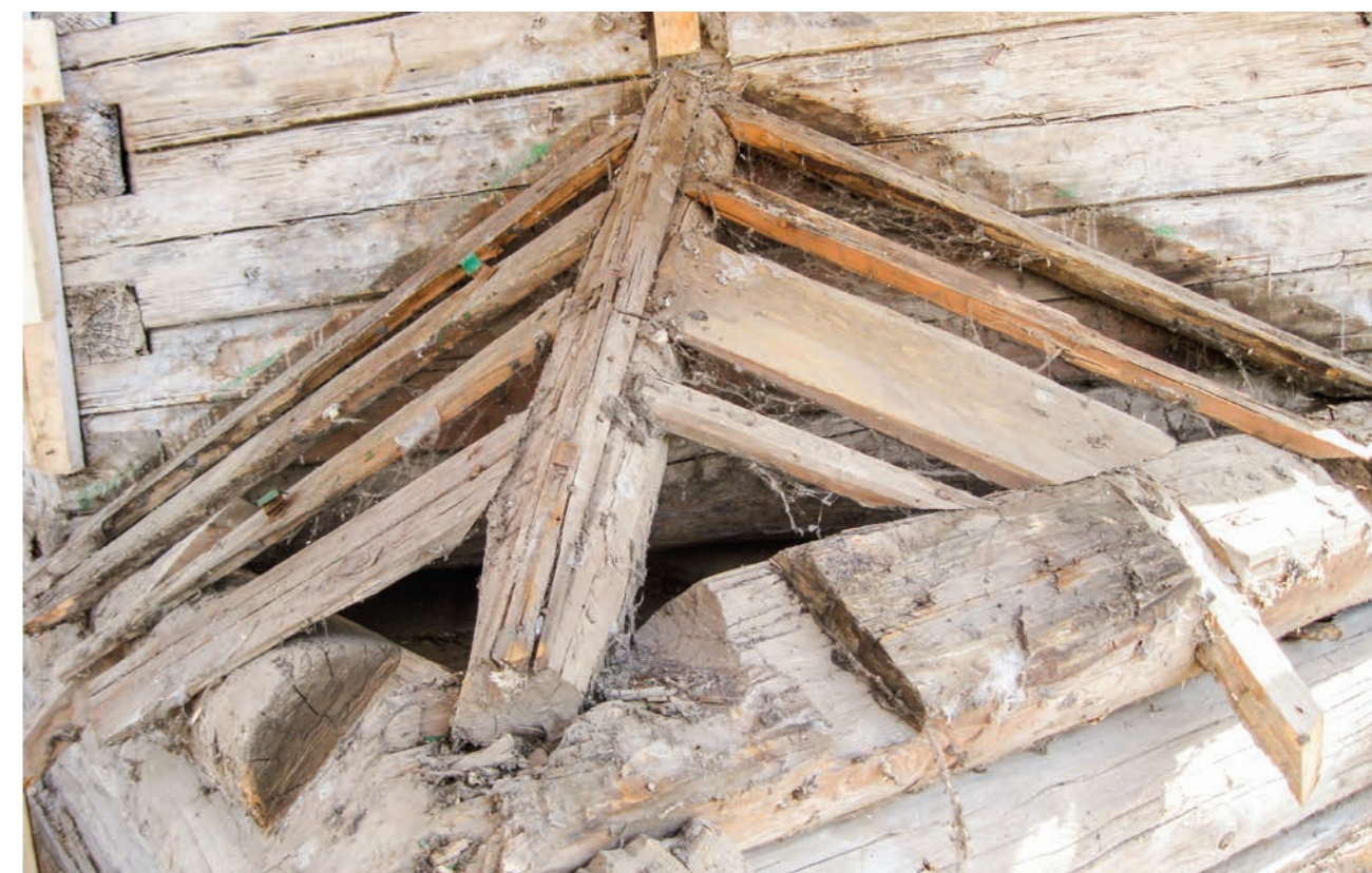
Рис. 71. Юго-западный угол четверика храма. Подкровельная конструкция
