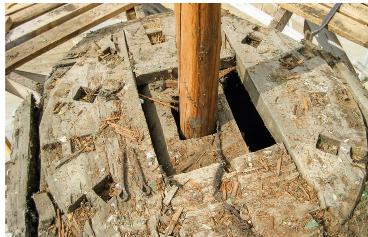
Рис. 78. Гнезда для установки журавцов. Фото 2011 г.
