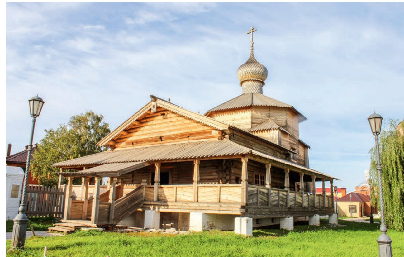
Рис. 116. Галерея после ремонтно-реставрационных работ 2011 года. Фото 2015 г.
