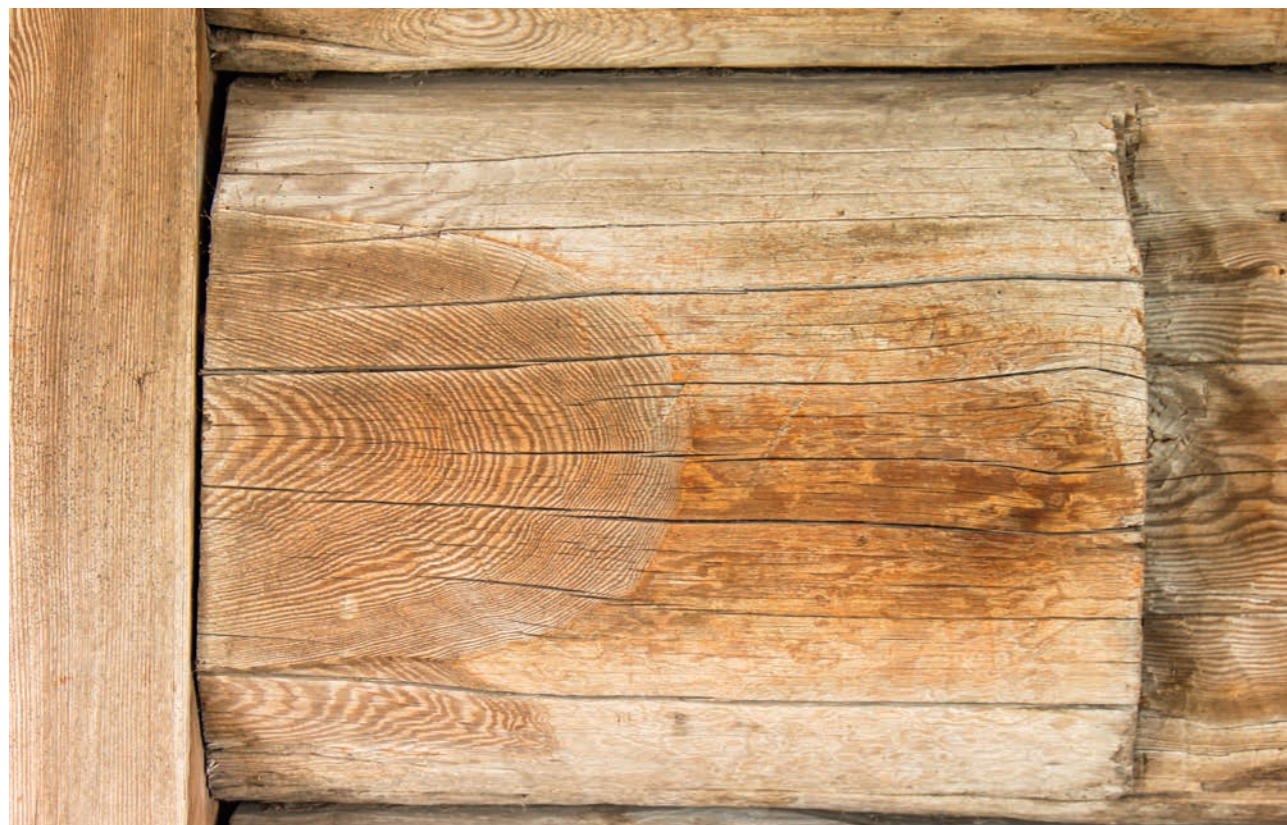
Рис. 21. Марки справа от двери на западной стене трапезной
