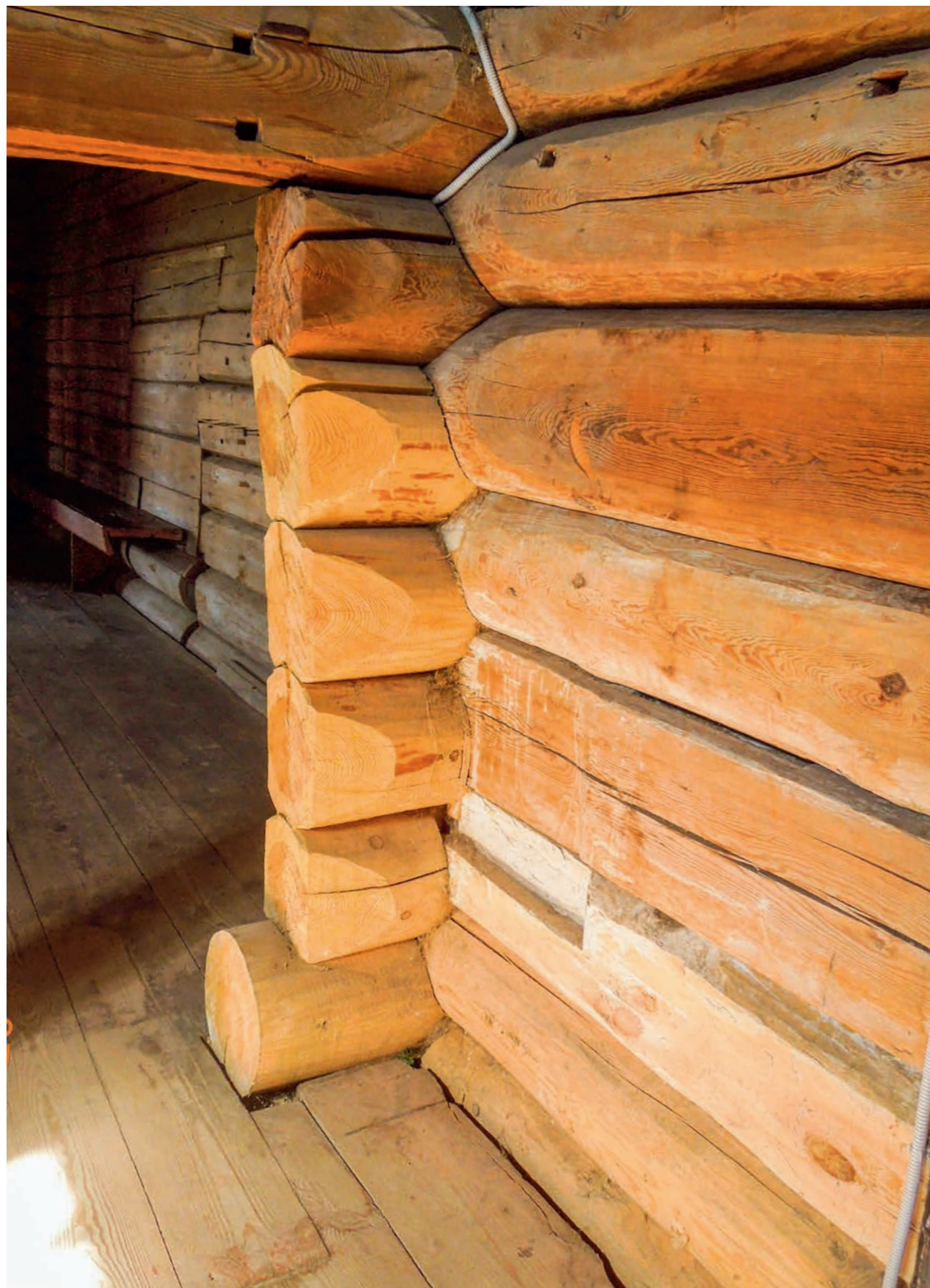
Рис. 121. Северо-западный угол кафоликона. Врубка для опирания скамьи в новой вставке. Затеска на конце подлинного бревна возле окна-«прозора». Фото 2014 г.
