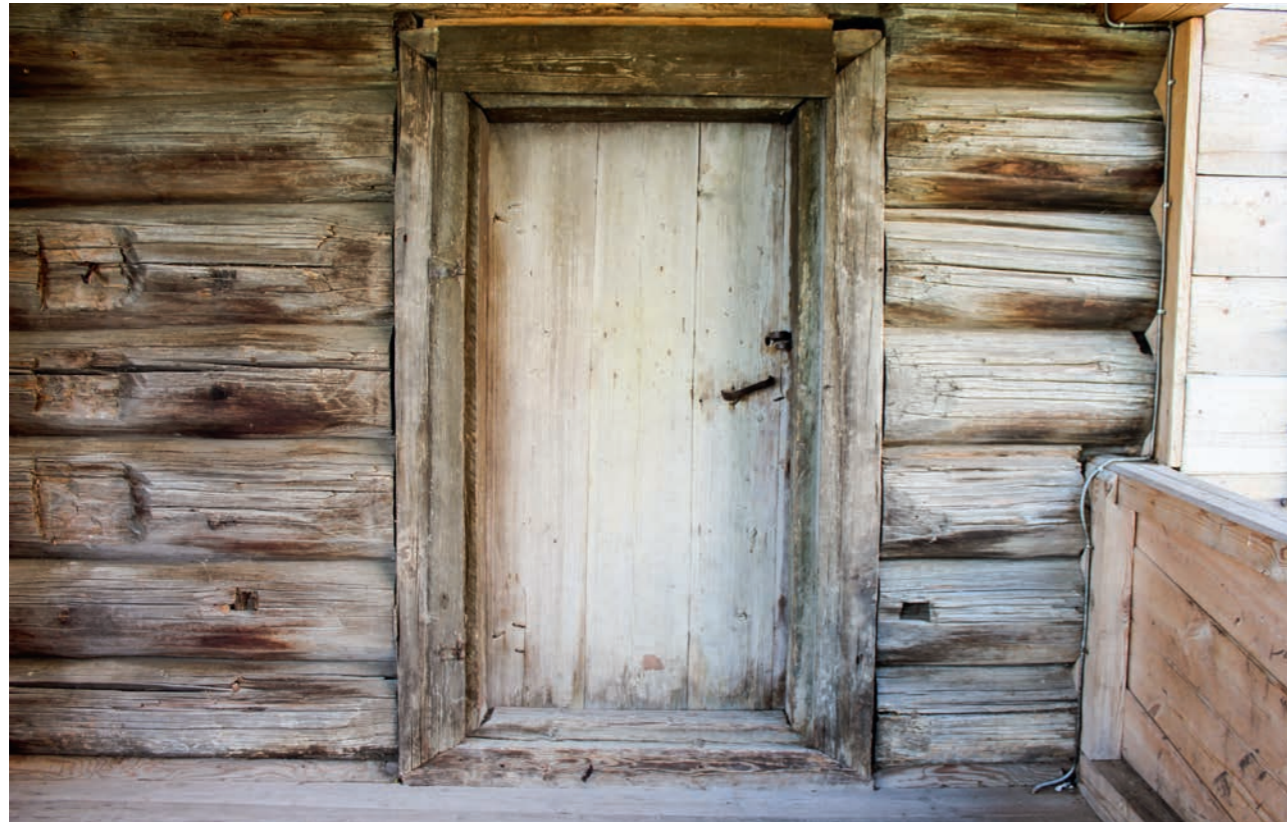
Рис. 93. Южная дверь. Гнезда от установки опор-«пальцев» подмостей. Фото 2015 г.
