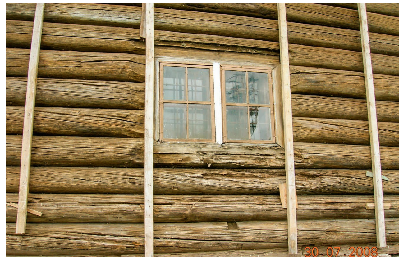
Рис. 92. Трехчастные подтесы возле окна трапезной. Гнезда от установки опор-«пальцев» подмостей. Фото 2008 г.
