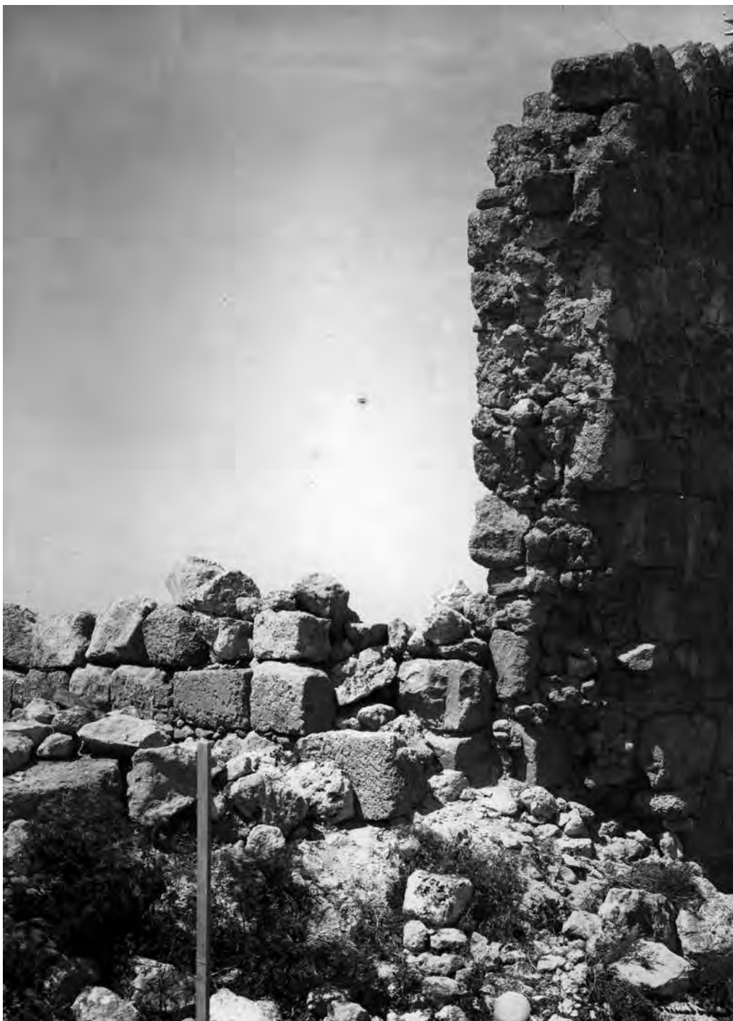
Рис. 841. Чуфут-Кале. Фото 1928 г. Северо-восточный угол мечети Хаджи-Гирея. Вид с востока (ГНИМА. ОФ 6079-020).
