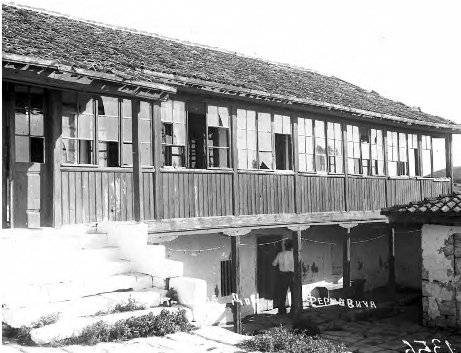
Рис. 810. Чуфут-Кале. Фото 1928 г. Дом А. С. Фирковича, вид с севера (Фонды БИКАМЗ. Ф-820).
