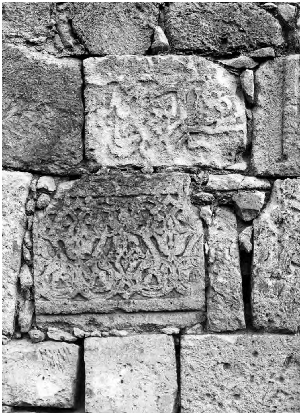
Рис. 938. Чуфут-Кале. Фото 1929 г. Резная архитектурная деталь, вторично использованная в кладке мечети Хаджи-Гирея (ГНИМА. ОФ 6079-044).
