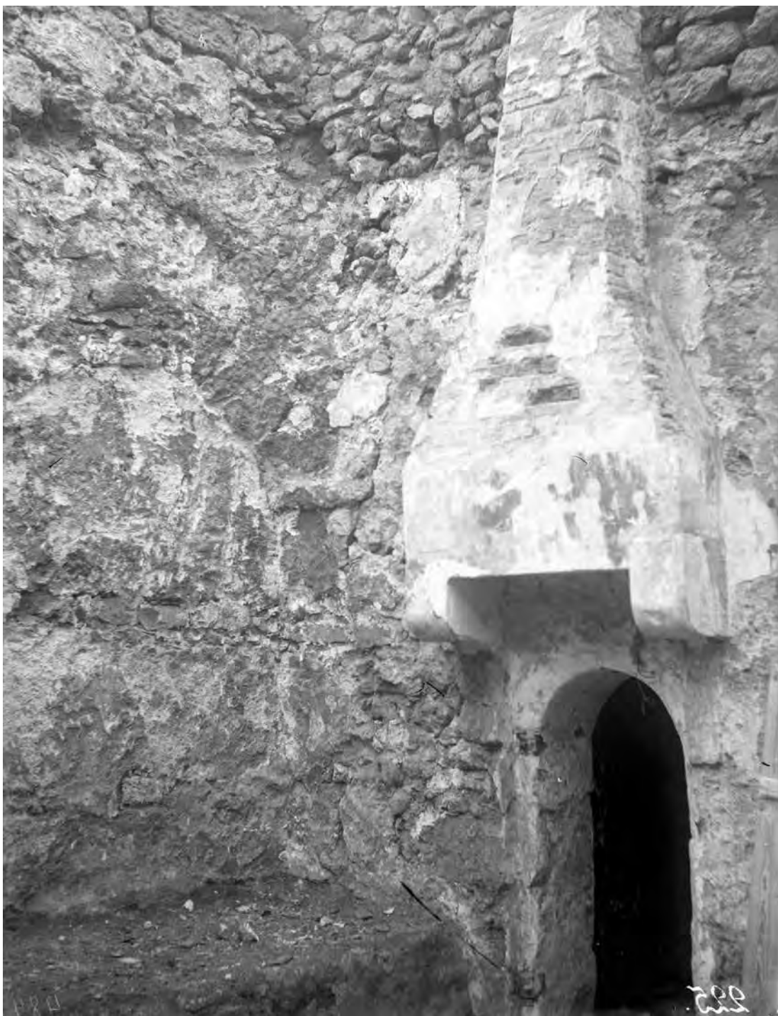
Рис. 725. Бахчисарай. Негатив 1928 г. Бани Сары-Гюзель. Вход в топочную камеру (Фонды БИКАМЗ. Ф-691).
