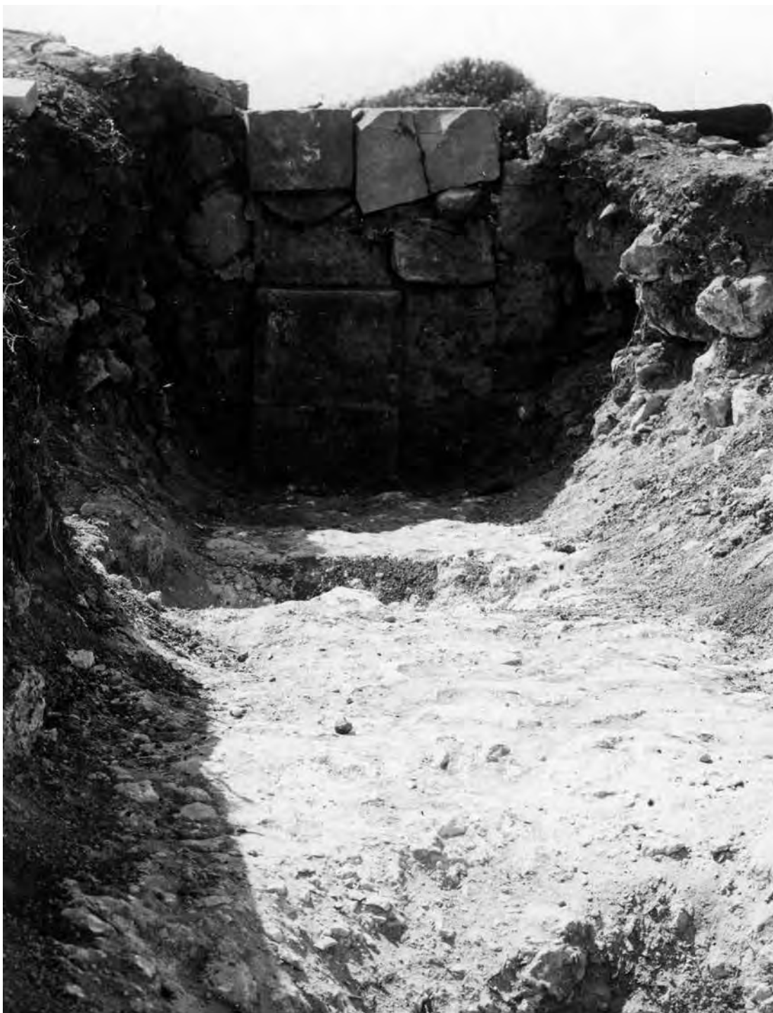
Рис. 871. Чуфут-Кале. Фото 1928 г. Траншея в центральной части мечети Хаджи-Гирея. Вид с севера (Фонды БИКАМЗ. Ф-866).
