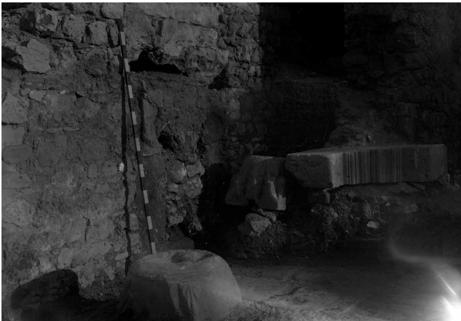
Рис. 798. Старый Крым. Фото 1928 г. Угол двора, база колонны, свалившаяся капитель и восточный пилон южной ниши медресе (Архив ИИМК. Ф. 2/1929. Д. 164. Л. 58).
