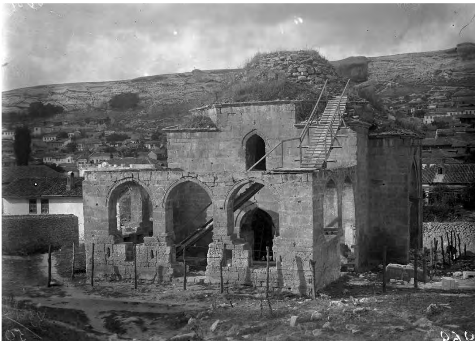
Рис. 584. Бахчисарай. Негатив 1928 г. Эски-Дюрбе. Реставрационные работы, вид с юго-востока (Фонды БИКАМЗ. Ф-611).
