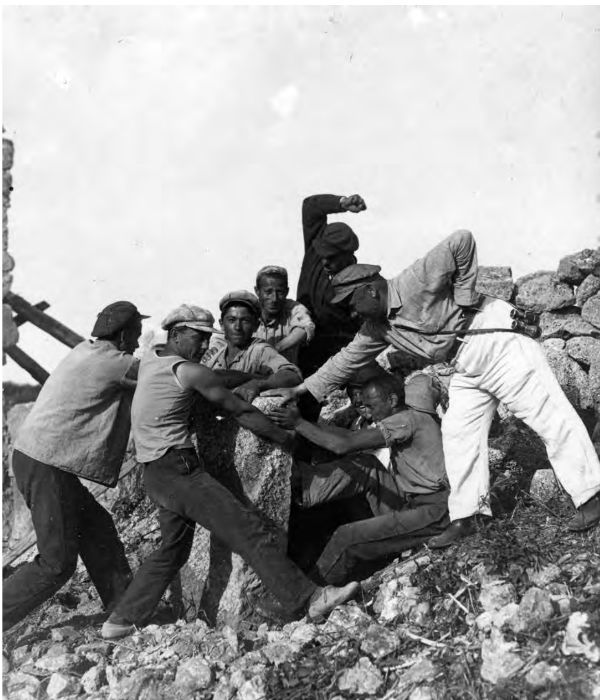
Рис. 974. Чуфут-Кале. Фото 1929 г. Подготовка блоков к транспортировке в музейное хранилище. Первый справа О. Н.-А. Акчокраклы (ГНИМА. ОФ 6079-074).
