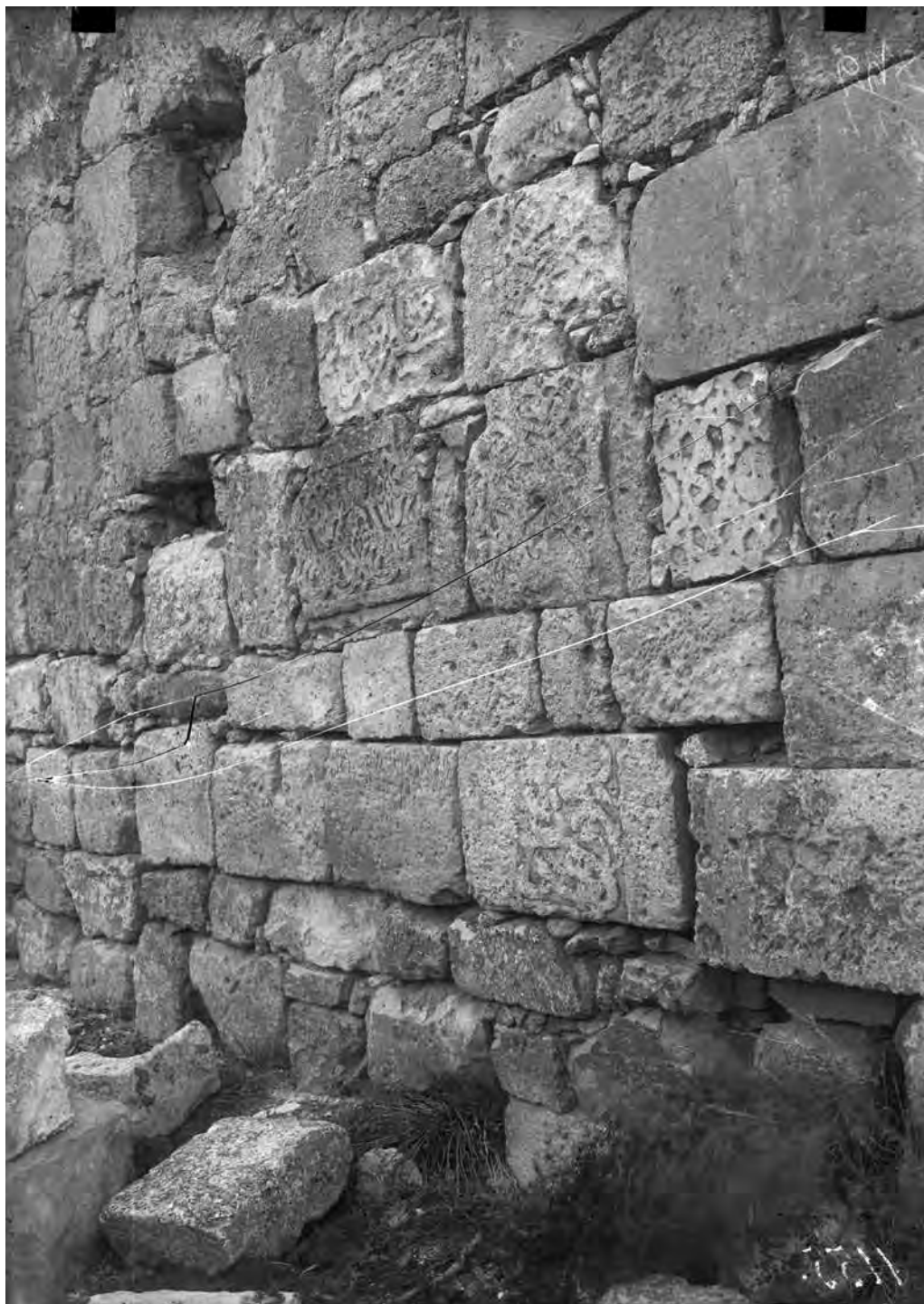
Рис. 907. Чуфут-Кале. Фото 1929 г. Резные архитектурные детали, вторично использованные в кладке мечети Хаджи-Гирея. Вид с юго-востока (Фонды БИКАМЗ. Ф-896).
