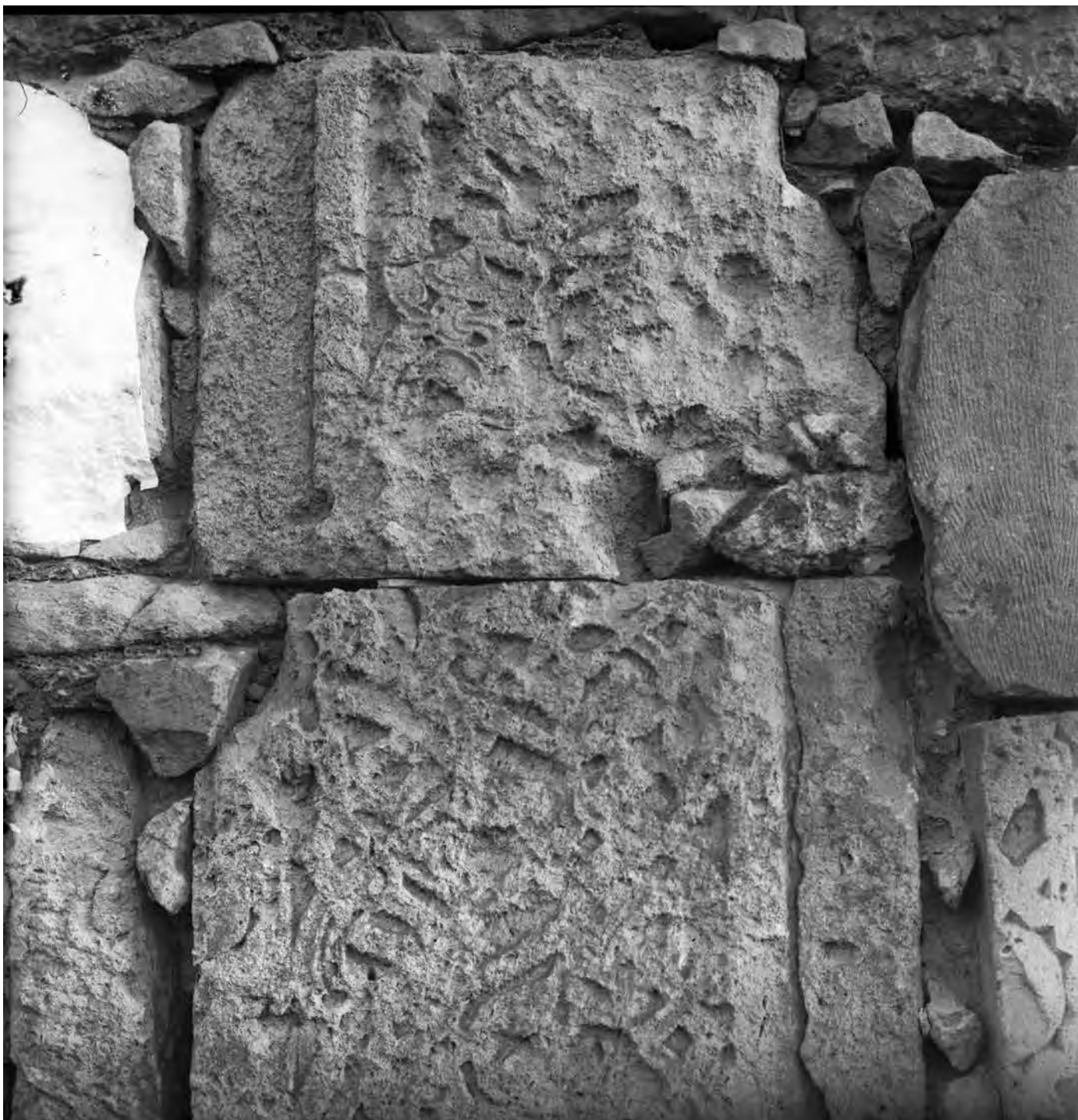
Рис. 904. Чуфут-Кале. Фото 1929 г. Резные архитектурные детали, вторично использованные в кладке мечети Хаджи-Гирея (Фонды БИКАМЗ. Ф-893).
