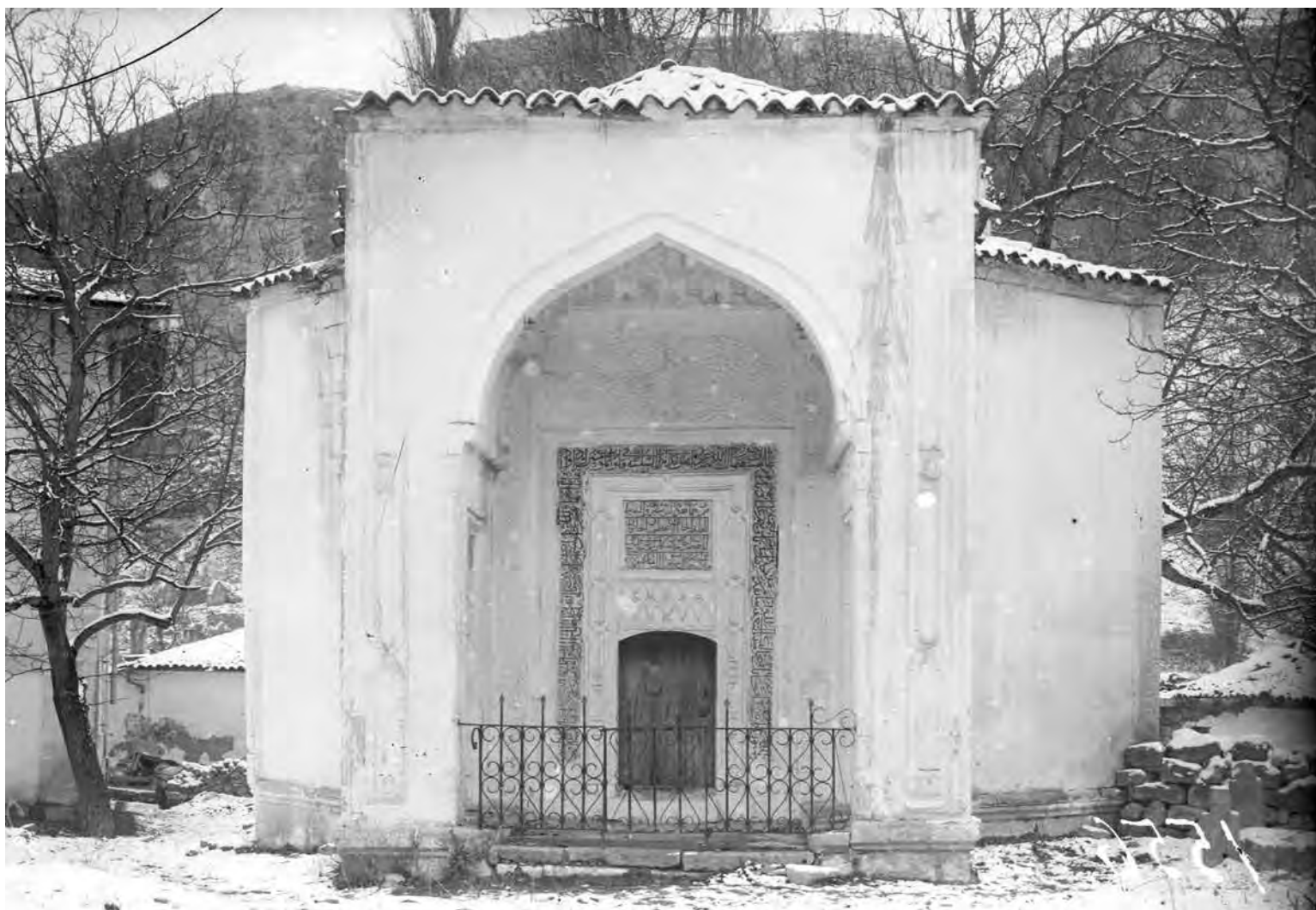
Рис. 813. Бахчисарай. Салачик. Фото 1928 г. Мавзолей Хаджи-Гирея. Вид с юго-востока (Фонды БИКАМЗ. Ф-823).
