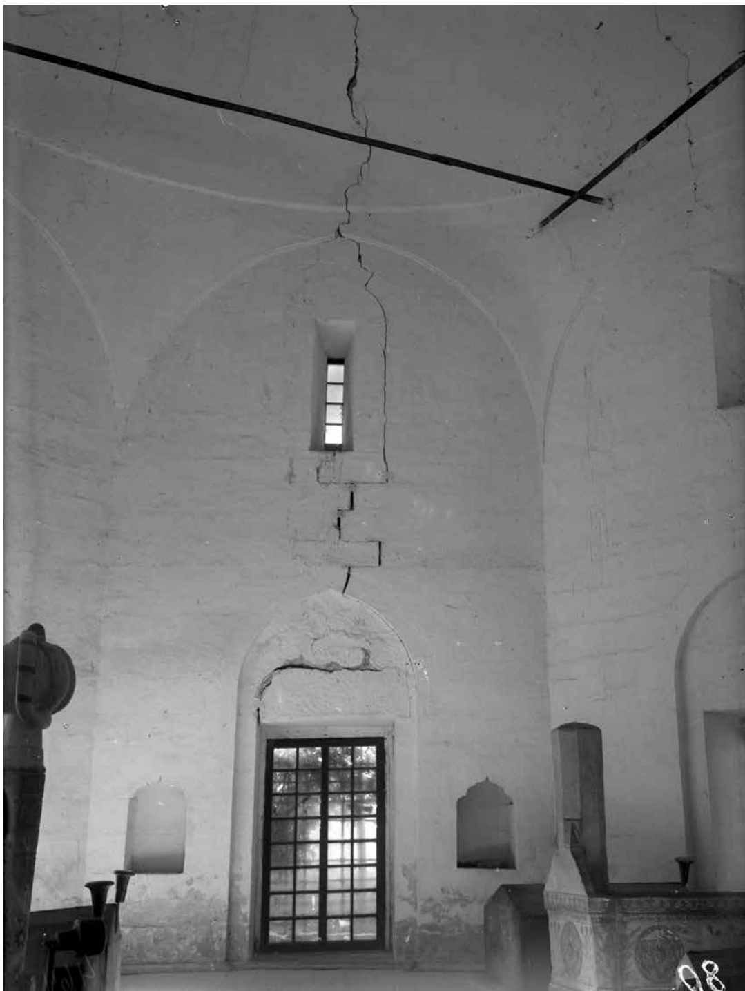
Рис. 623. Бахчисарай. Негатив 1928 г. Бахчисарайский дворец. Ханский мавзолей. Трещина, образовавшаяся в результате землетрясения, вид с севера (Фонды БИКАМЗ. Ф-650).
