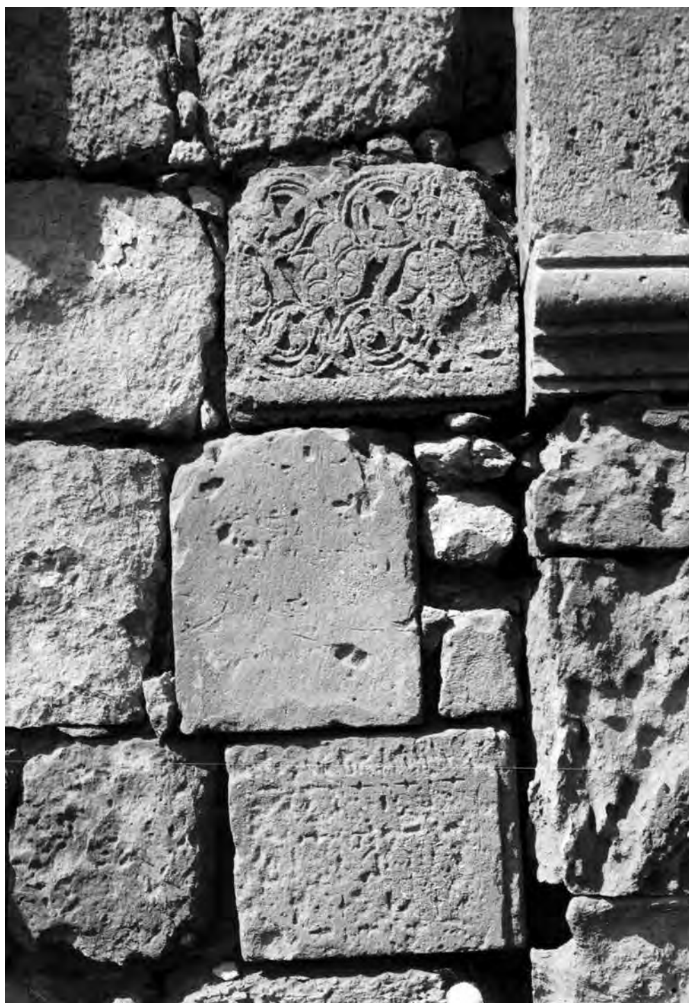
Рис. 850. Чуфут-Кале. Фото 1928 г. Резные камни, вторично использованные в кладке северной стены мечети Хаджи-Гирея (Фонды БИКАМЗ. Ф-847).
