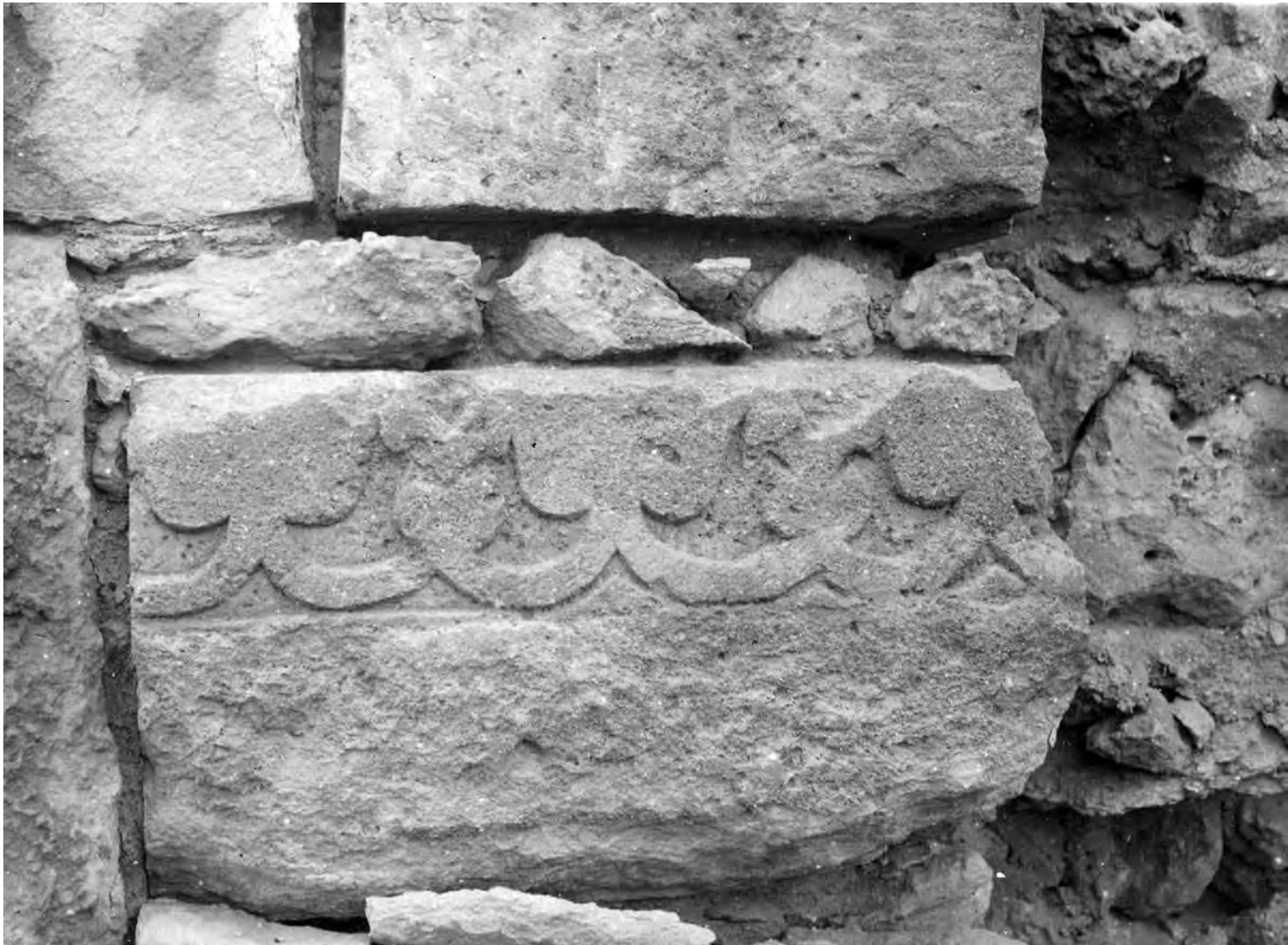
Рис. 921. Чуфут-Кале. Фото 1929 г. Резная архитектурная деталь, вторично использованная в кладке мечети Хаджи-Гирея (ГНИМА. НВФ 1183-005).
