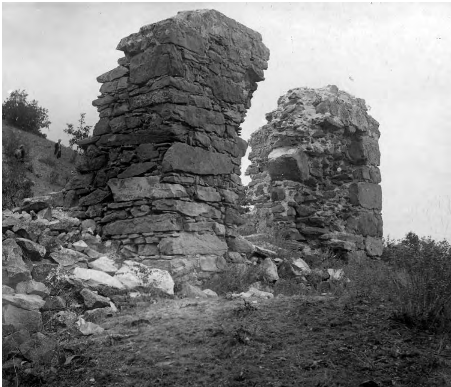
Рис. 756. Коктебель. Фото 1926 г. Руины мечети. Вид с северо-востока (ГНИМА. ОФ 6088-036).
