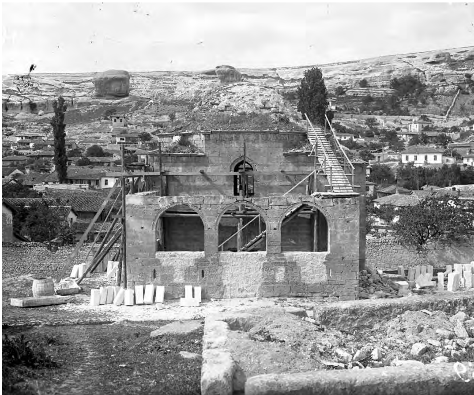
Рис. 588. Бахчисарай. Негатив 1928 г. Эски-Дюрбе. Реставрационные работы, вид с юга (Фонды БИКАМЗ. Ф-615).
