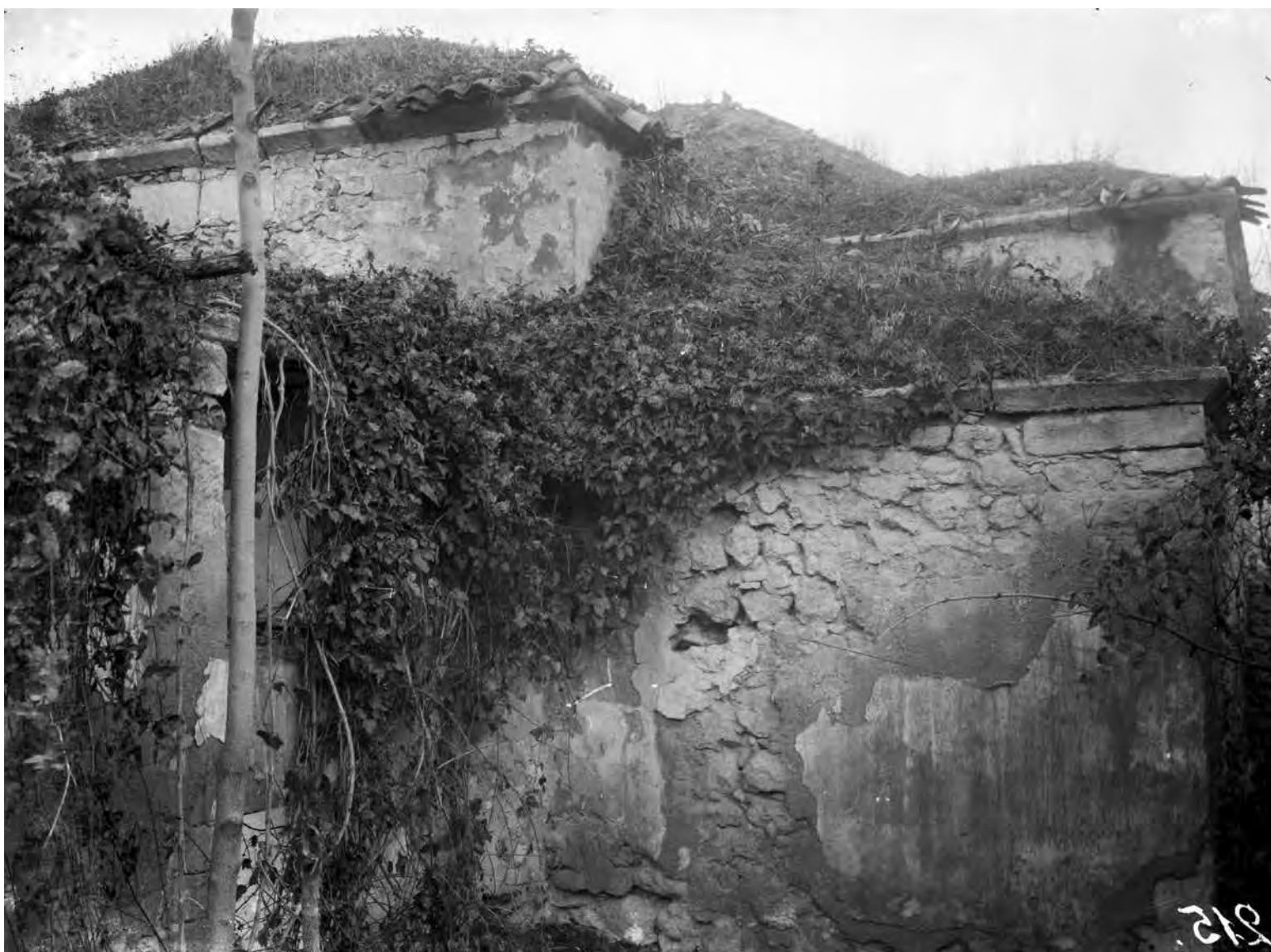
Рис. 712. Бахчисарай. Негатив 1928 г. Бани Сары-Гюзель, вид с северо-востока (Фонды БИКАМЗ. Ф-678).
