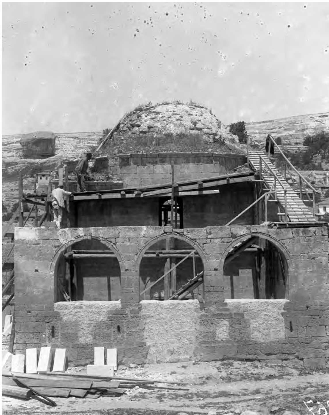
Рис. 585. Бахчисарай. Негатив 1928 г. Эски-Дюрбе. Реставрационные работы, вид с юга (Фонды БИКАМЗ. Ф-612).
