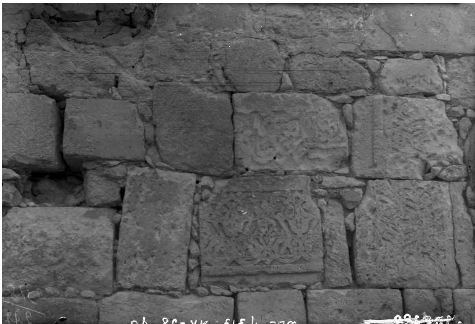
Рис. 874. Чуфут-Кале. Фото 1928 г. Резные архитектурные детали, вторично использованные в кладке мечети Хаджи-Гирея. Вид с юга (Фонды БИКАМЗ. Ф-867).
