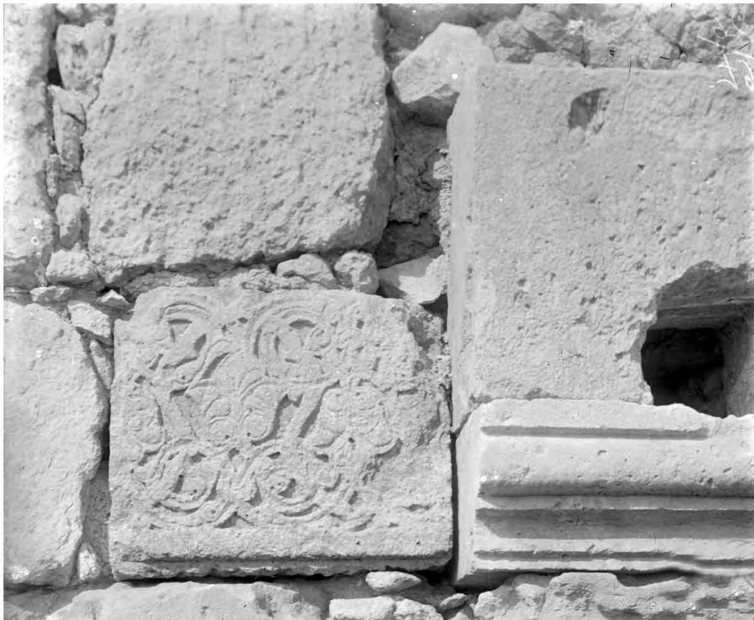
Рис. 930. Чуфут-Кале. Фото 1929 г. Резная архитектурная деталь, вторично использованная в кладке мечети Хаджи-Гирея (Фонды БИКАМЗ. Ф-907).
