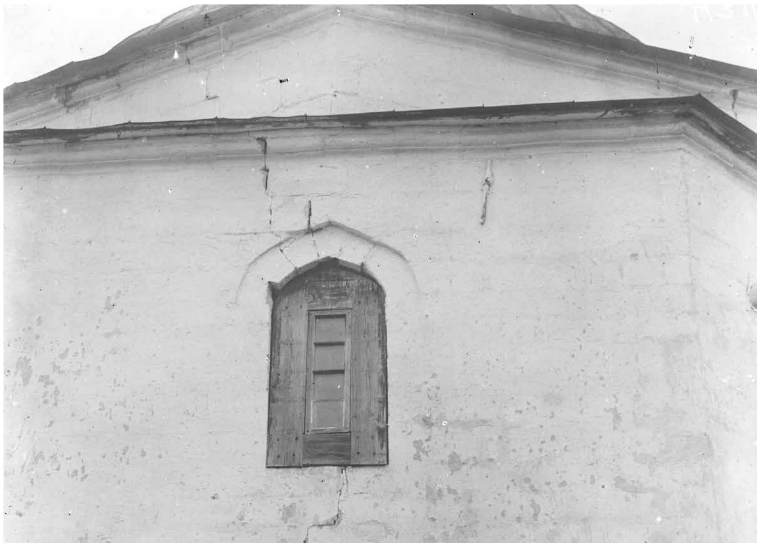
Рис. 620. Бахчисарай. Негатив 1928 г. Бахчисарайский дворец. Ханский мавзолей. Окно второго яруса, вид с юго-востока (Фонды БИКАМЗ. Ф-647).
