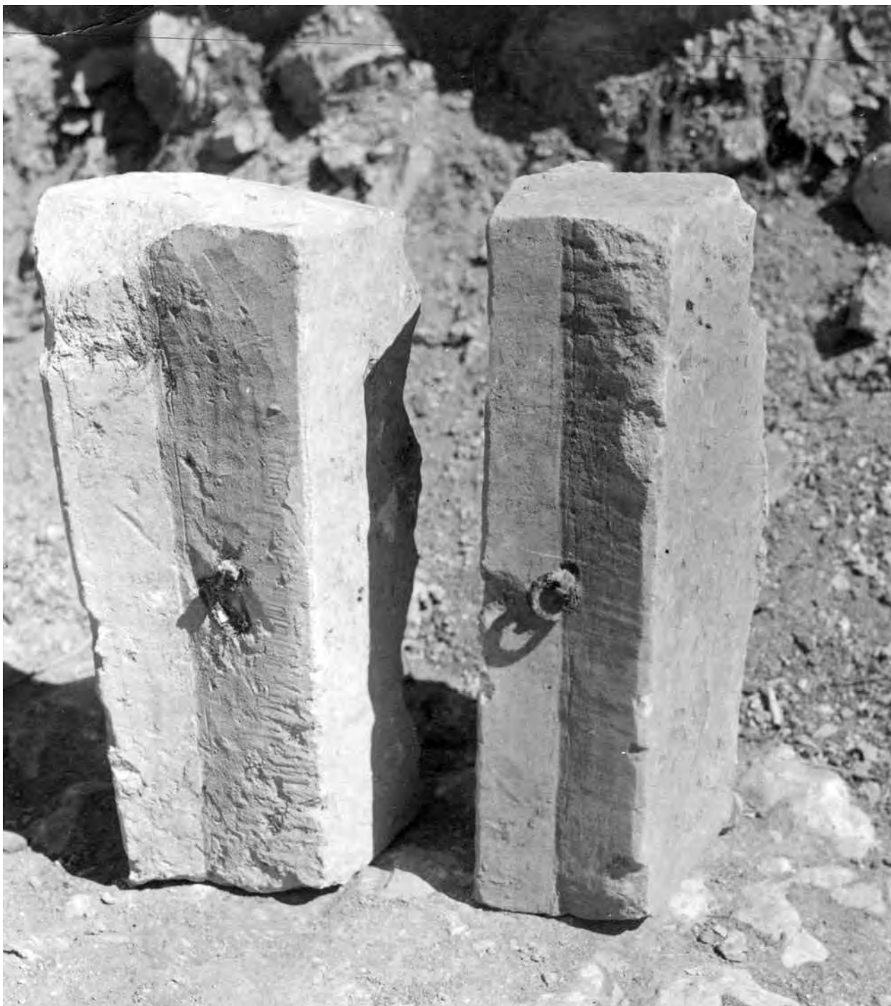
Рис. 946. Чуфут-Кале. Фото 1929 г. Камни свода мечети Хаджи-Гирея с вставленными железными кольцами для подвешивания ламп (ГНИМА. ОФ 6079-070).
