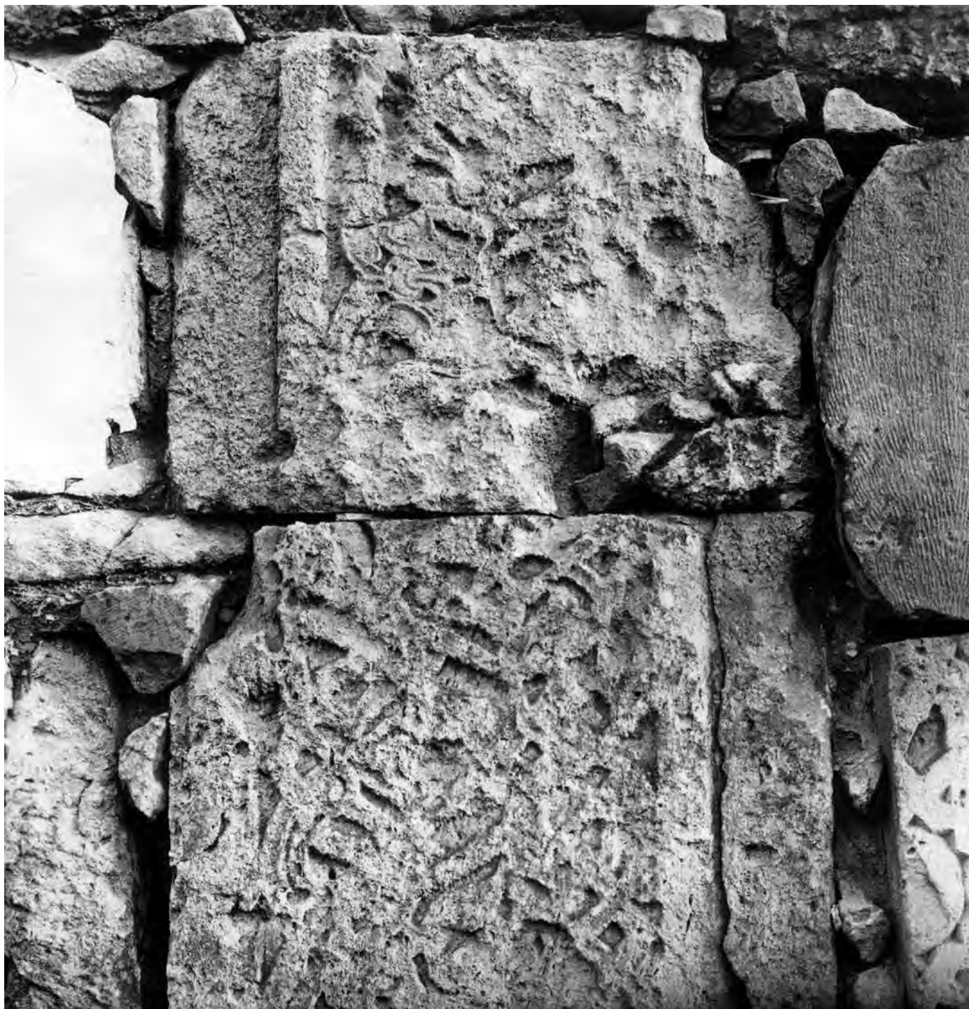
Рис. 939. Чуфут-Кале. Фото 1929 г. Резные архитектурные детали, вторично использованная в кладке мечети Хаджи-Гирея (ГНИМА. ОФ 6079-045).
