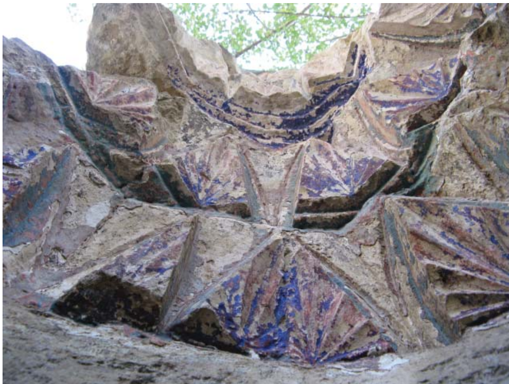
Рис. 8. Перекрытие михрабной ниши. Вид снизу, с юга. 2012 г. Фото автора.
