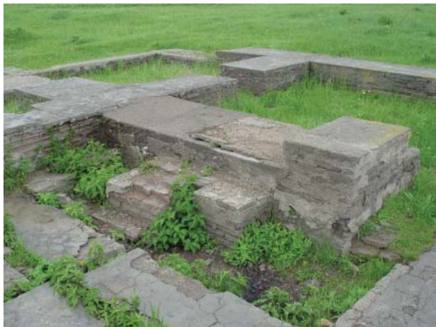
Рис. 7. Реконструкция белокаменной бани. Современный вид. Фото автора.
