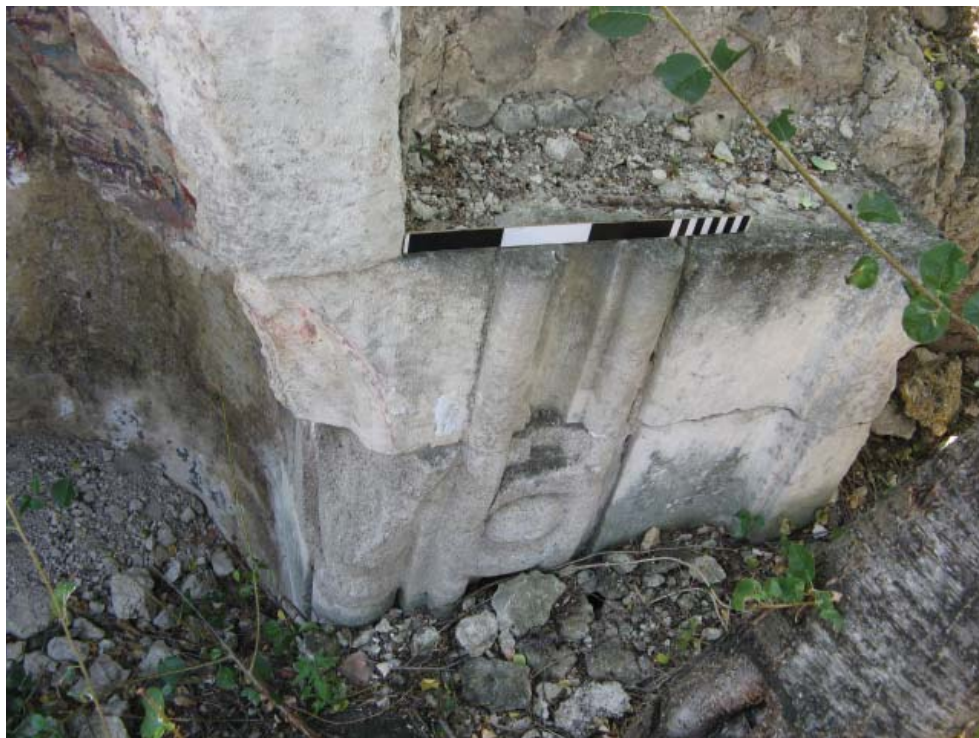
Рис. 6. Ремонтная вставка с западной капителью и частью орнамента михраба. Вид с северо-востока, сверху. 2012 г. Фото автора.
