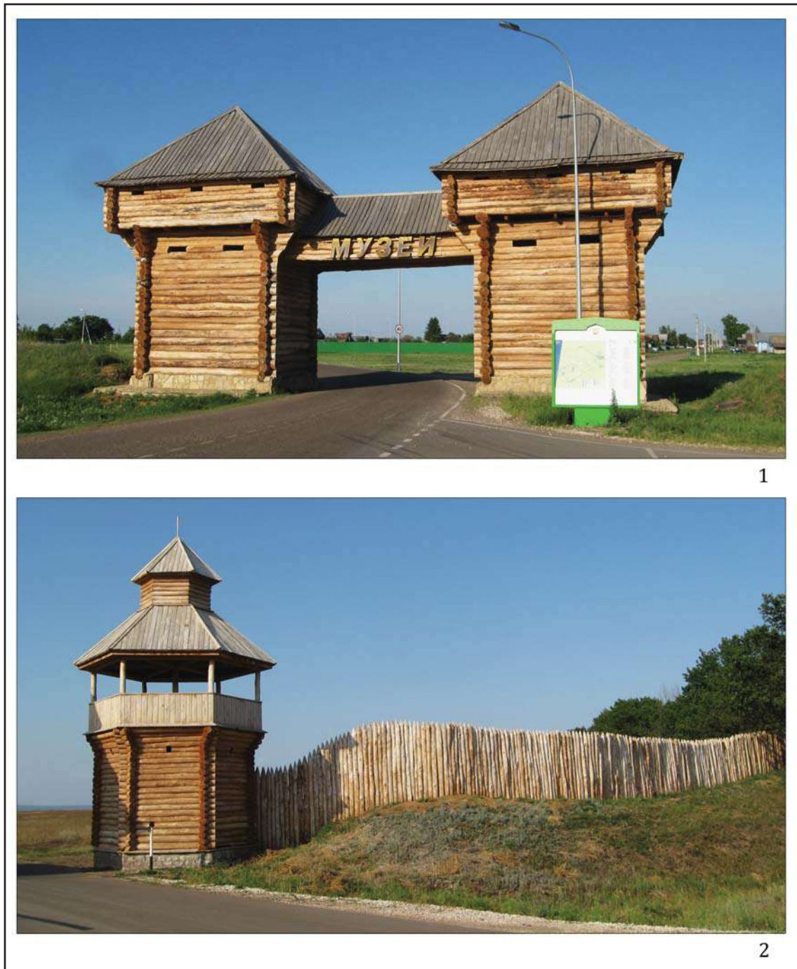
Рис. 3. Башни, выстроенные в воротных проемах в 2000-е гг.: 1 — на Западных воротах (вид с запада); 2 — на южных воротах (вид с юга).
