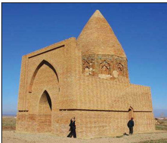
Рис. 6. Мавзолей Абат Байтак. Современное состояние после реконструкции (фото автора).
