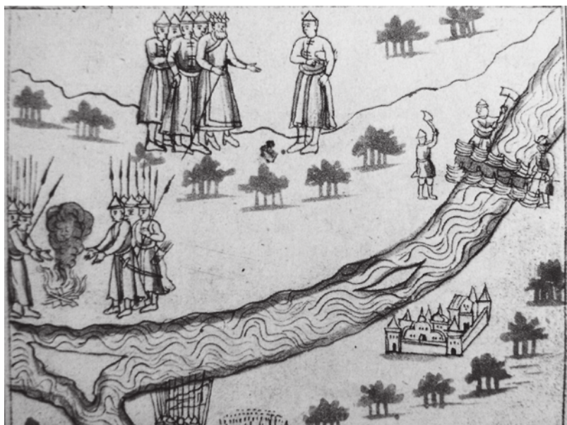
Рис. 38. Строительство моста через р. Иртыш в районе Подчевашского мыса на рисунке «Истории Сибирской» С.У. Ремезова (по Дергачева-Скоп Е.И., Алексеев В.Н., 2006).
