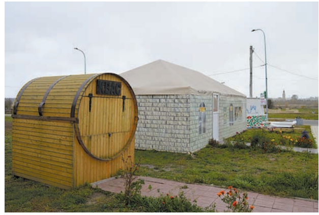
Недавно построенные пункты общественного питания рядом с музеем «Дом лекаря» Newly constructed catering facilities next to the Healer's House
