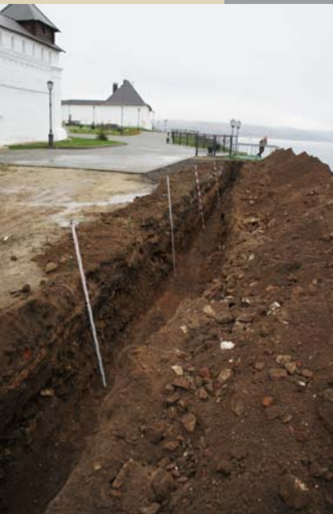
Успенская площадь, коммуникационная траншея
