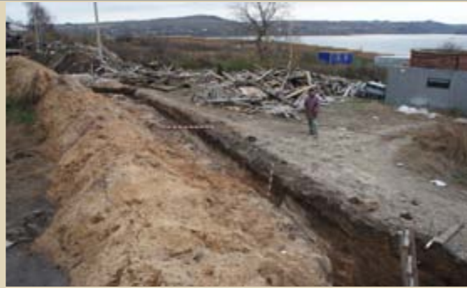
Траншеи сетей инженерных коммуникаций на территории Иоанно-Предтеченского монастыря
