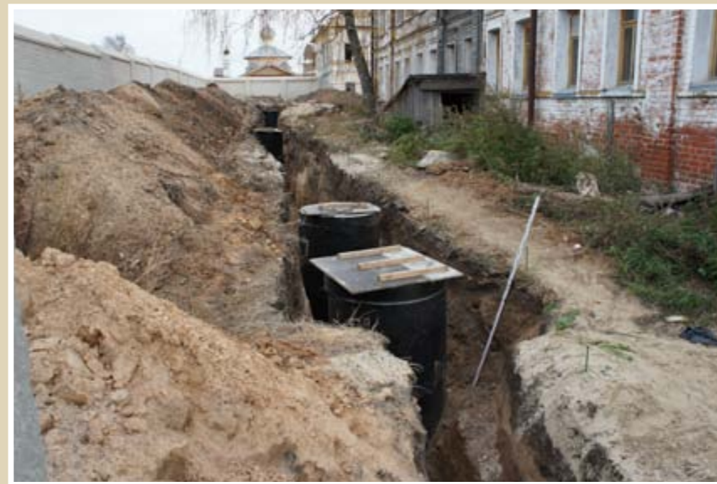
Остатки каменного фундамента в траншее сетей инженерных коммуникаций на территории Иоанно-Предтеченского монастыря
