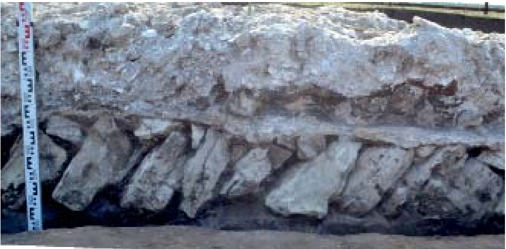
Илл. 4. Раскоп CLXXIV. Остатки фундаментов мавзолея. Фрагмент кладки основания восточной стены с горизонтом проливки известковым раствором. Фото.
